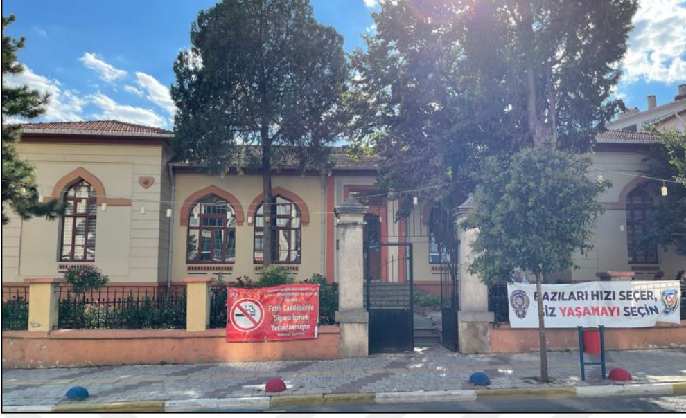
Fotoğraf 132: Kırklareli-Babaeski Atatürk İlkokulu (Atatürk Kültür Merkezi Binası), Ön Cephe Genel Görünüm
