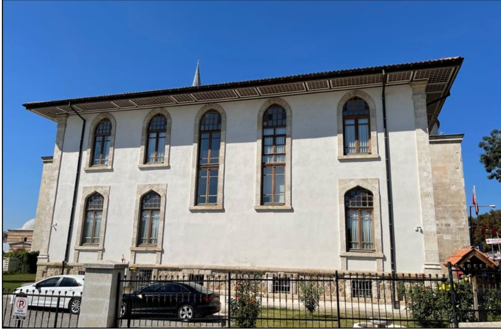
Fotoğraf 27: Edirne Vakıflar Bölge Müdürlüğü Binası Güneydoğu Cephe Görünümü
