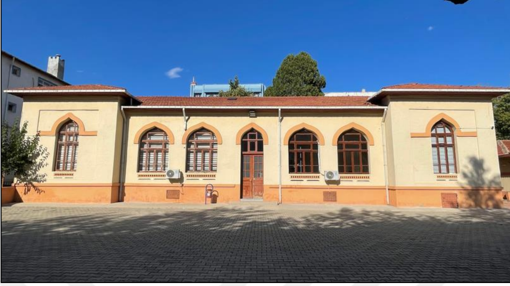
Fotoğraf 136: Kırklareli-Babaeski Atatürk İlkokulu (Atatürk Kültür Merkezi Binası), Arka Cepheden Görünüm
