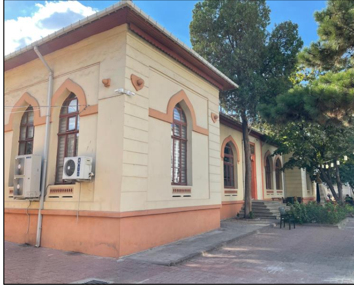
Fotoğraf 135: Kırklareli-Babaeski Atatürk İlkokulu (Atatürk Kültür Merkezi Binası), Güneydoğu Cephe ve Giriş Kısmı
