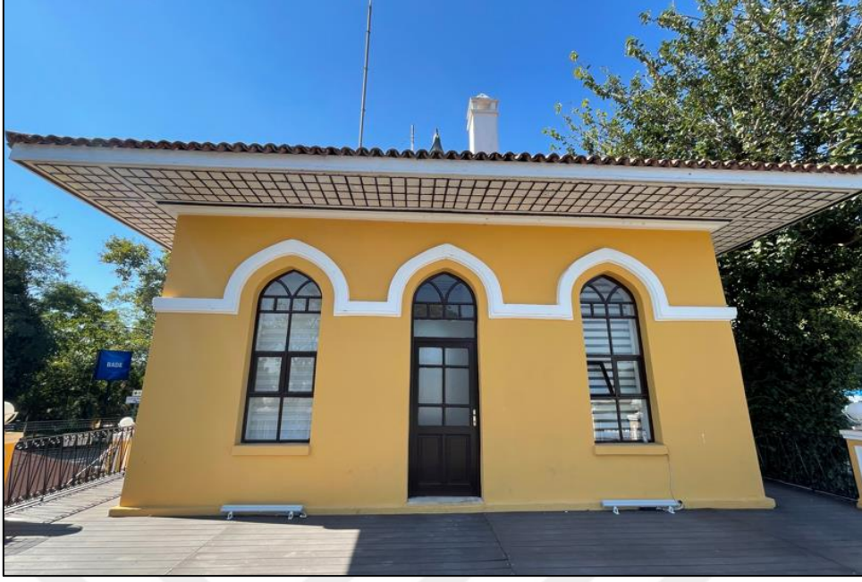
Fotoğraf 69: Karaağaç Gümrük Karakol Binası Arka Cephe Görünümü
