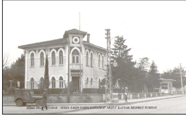
Fotoğraf 175: 1970’li Yıllarda Kırklareli-Babaeski Eski Belediye Binası,
