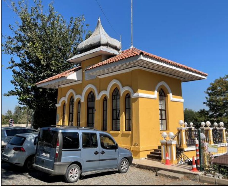
Fotoğraf 67: Karaağaç Gümrük Karakol Binası Genel Görünüm
