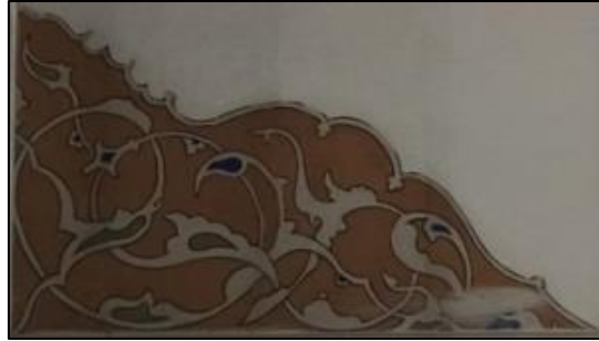
Fotoğraf 17: Edirne İttihat ve Terakki Kulübü Binası, (Halk Eğitim Merkezi Binası), Koridor Tavan Süslemeleri Detay
