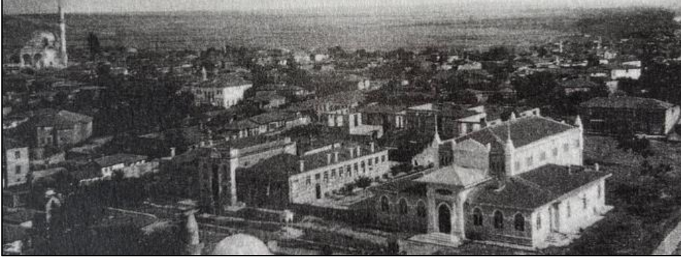
Fotoğraf 1: Edirne İttihat ve Terakki Binası (Halk Eğitim Merkezi Binası)
