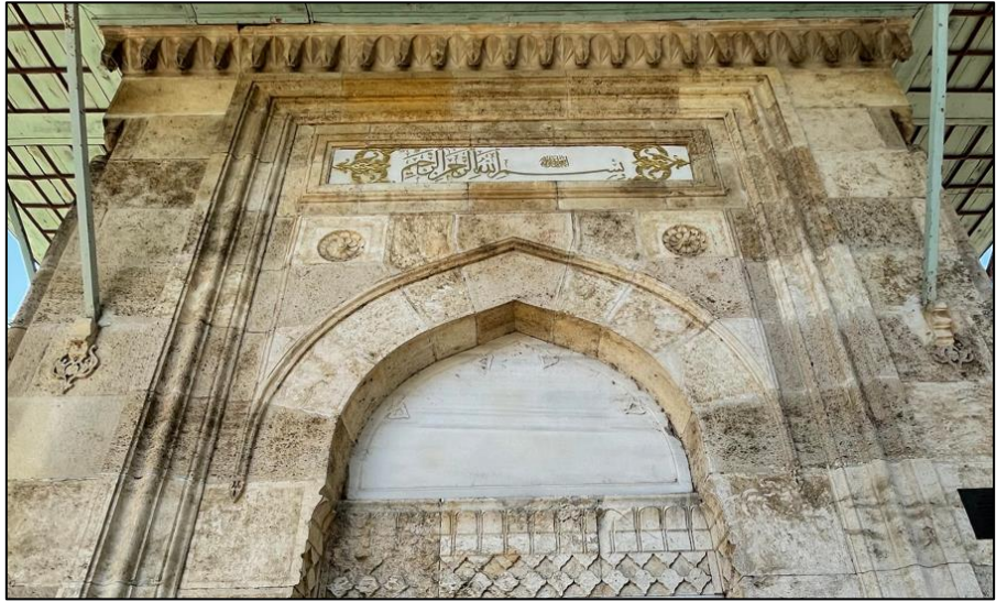
Fotoğraf 85: Karaağaç Hacı Adil Bey Çeşmesi Kuzey Cephe Ayrıntı
