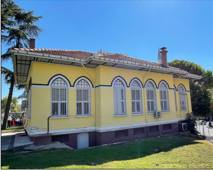
Fotoğraf 33: Edirne Basın Yayın ve Halkla İlişkiler Müdürlüğü Binası Arka Cepheden Görünüm
