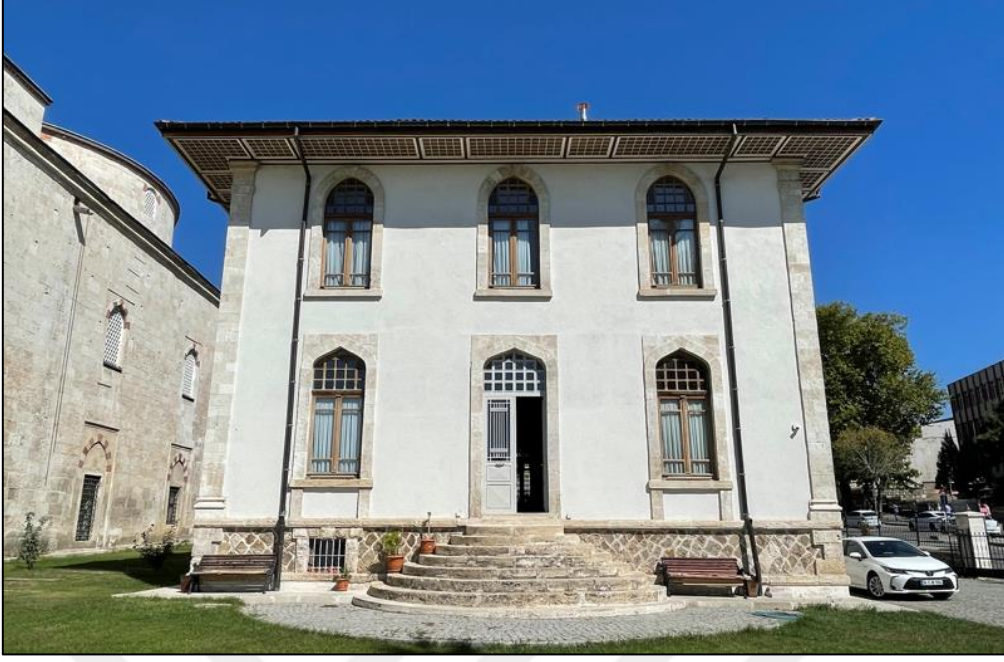
Fotoğraf 26: Edirne Vakıflar Bölge Müdürlüğü Binası Arka Cephe Görünümü
