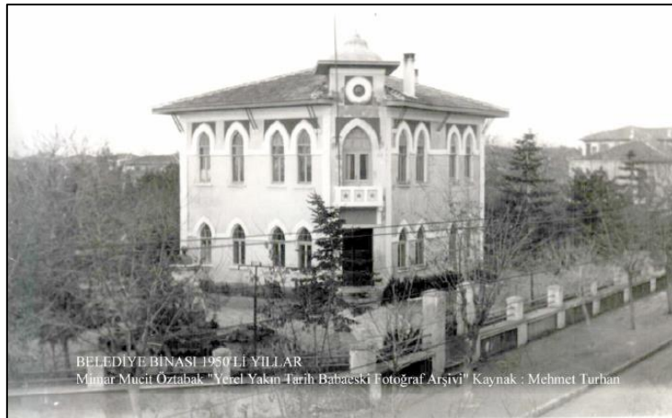
Fotoğraf 174: 1950'li Yıllarda Kırklareli-Babaeski Eski Belediye Binası,
