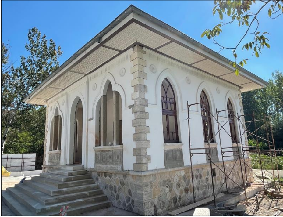
Fotoğraf 72: Karaağaç Jandarma Karakol Binası (Lojman) Genel Görünüm
