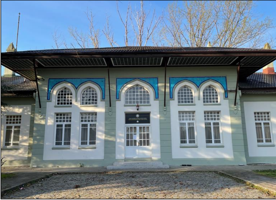
Fotoğraf 58: Karaağaç Eski İstasyon/Gar Binası (Trakya Üniversitesi Doğatarihi Müzesi), Ön Cephe Görünümü
