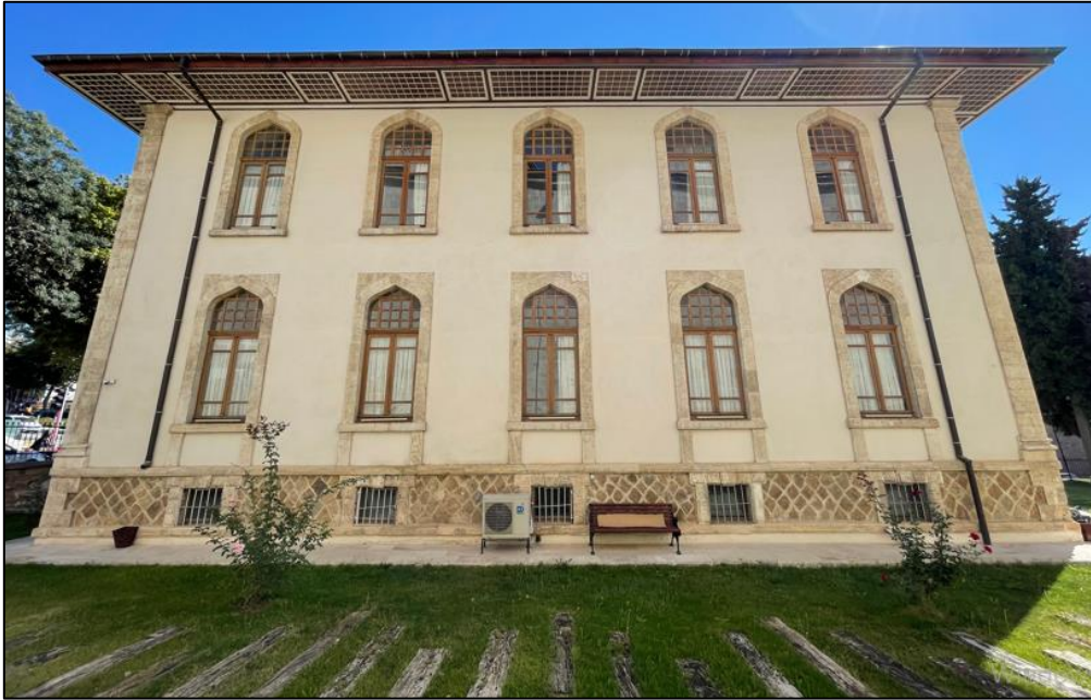
Fotoğraf 25: Edirne Vakıflar Bölge Müdürlüğü Binası Kuzeybatı Cephe Görünümü
