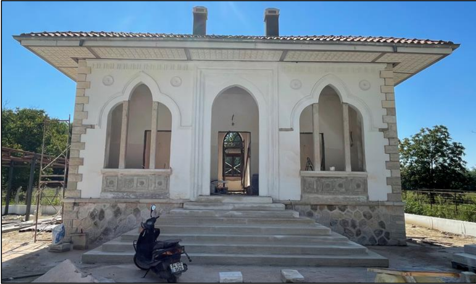
Fotoğraf 70: Karaağaç Jandarma Karakol Binası (Lojman) Ön Cepheden Görünüm, Eylül 2021
