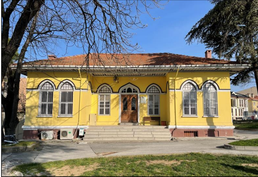
Fotoğraf 31: Edirne Basın Yayın ve Halkla İlişkiler Müdürlüğü Binası Ön Cepheden Görünüm
