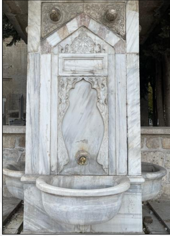
Fotoğraf 166: Kırklareli Büyük Cami Çeşmesi Güneydoğu Cephesindeki Ayna Taşı ve Yalak Kısmı
