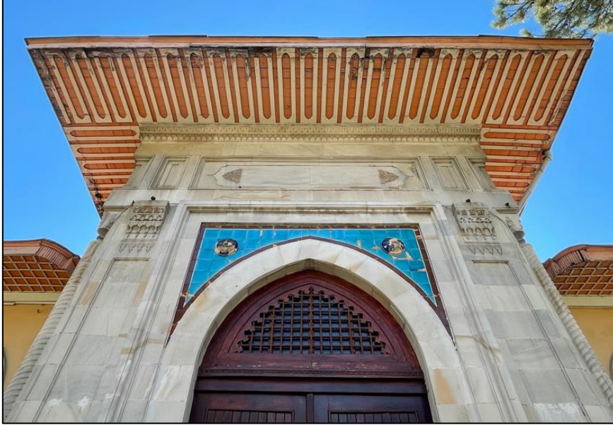
Fotoğraf 6: Edirne İttihat ve Terakki Kulübü Binası (Halk Eğitim Merkezi Binası), Ana Giriş Kısmı Detay
