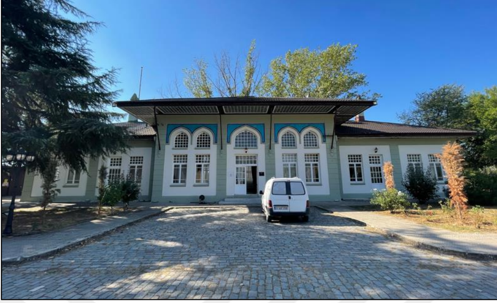
Fotoğraf 57: Karaağaç Eski İstasyon/Gar Binası (Trakya Üniversitesi Doğatarihi Müzesi), Ön Cephe Görünümü
