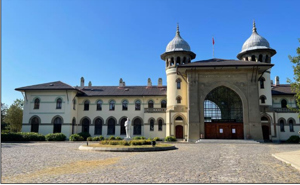
Fotoğraf 44: Karaağaç Gar Binası (Güzel Sanatlar Fakültesi) Ön Cephe ve Giriş Kısmı
