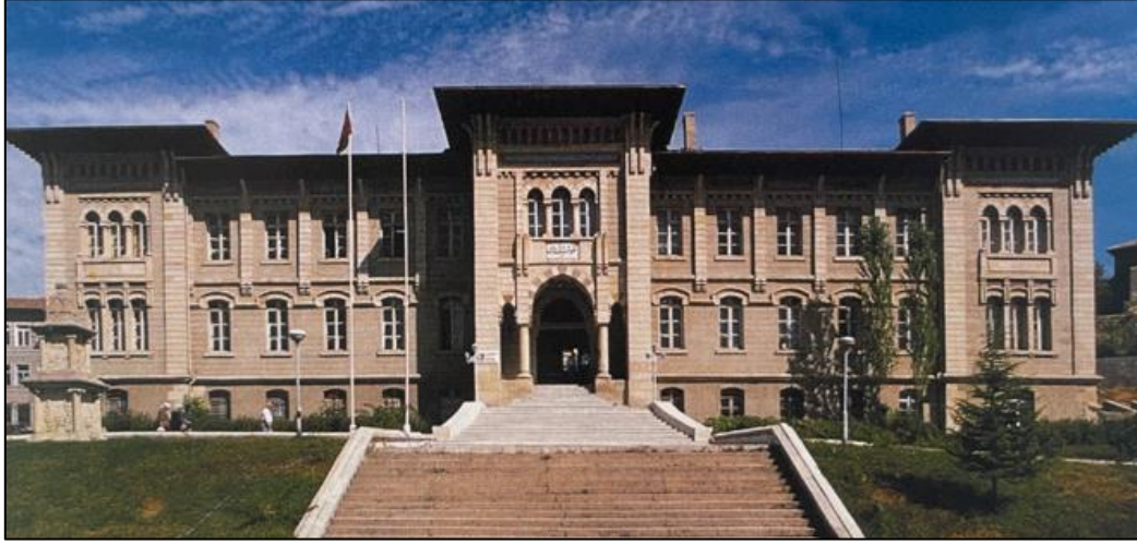
Fotoğraf 106: Kastamonu Hükümet Konağı,
