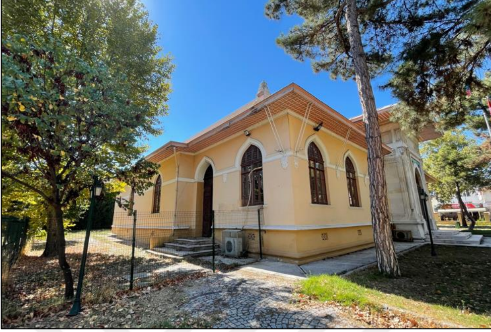
Fotoğraf 7: Edirne İttihat ve Terakki Kulübü Binası (Halk Eğitim Merkezi Binası), Doğu Cephe Görünüm
