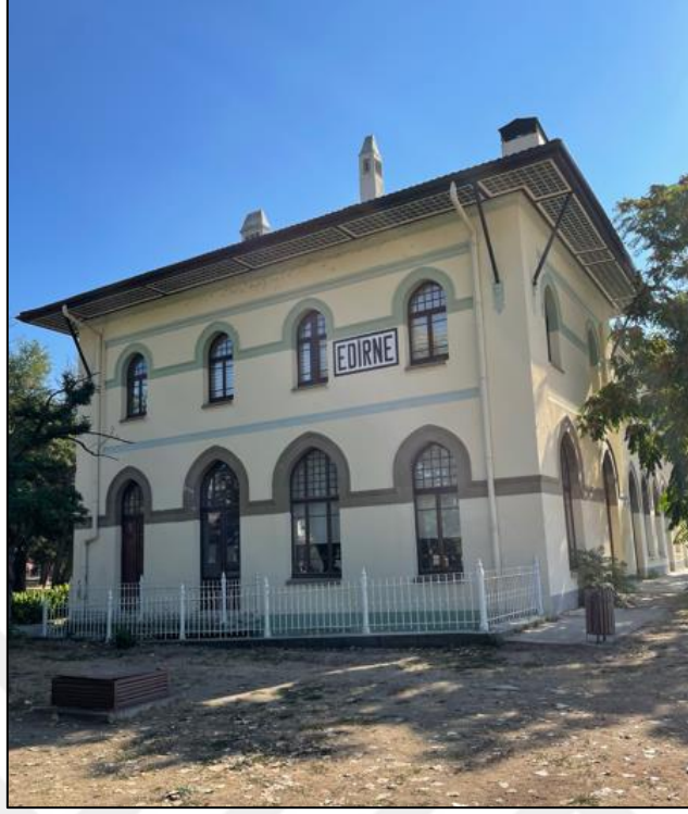
Fotoğraf 49: Karaağaç Gar Binası (Güzel Sanatlar Fakültesi) Kuzeybatı Cephesi
