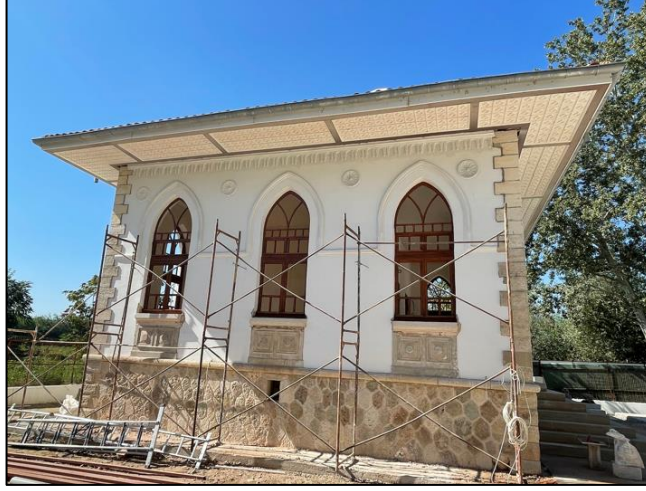
Fotoğraf 75: Karaağaç Jandarma Karakol Binası (Lojman) Doğu Cepheden Görünüm
