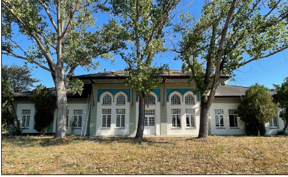
Fotoğraf 59: Karaağaç Eski İstasyon/Gar Binası (Trakya Üniversitesi Doğa Tarihi Müzesi), Arka Cephe Görünümü
