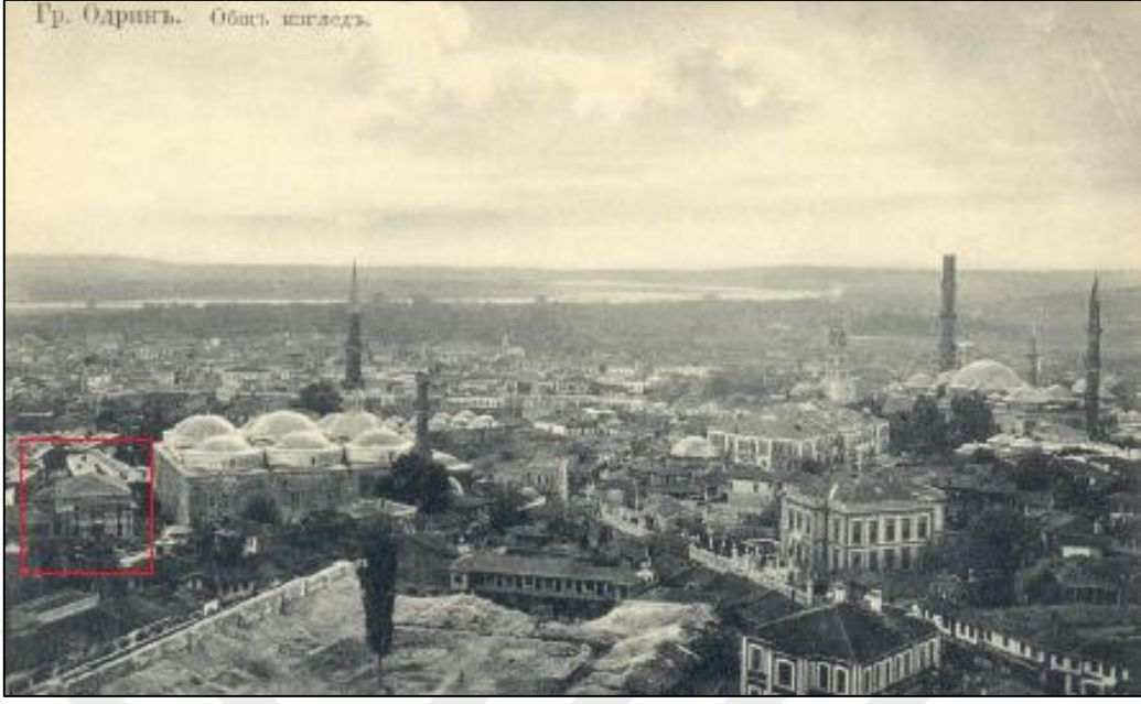
Fotoğraf 20: Edirne Vakıflar Bölge Müdürlüğü Binası Yapının İnşaat Aşamasından Eski Bir Fotoğraf
