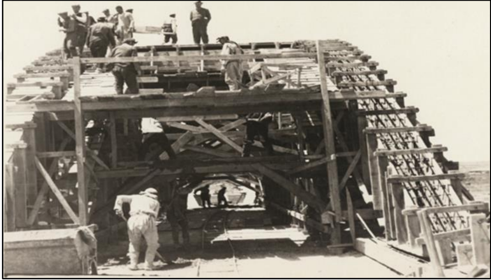
Şekil 5.91. Çetinkaya Köprüsü İnşaatı (Salt Araştırma, 2021)
