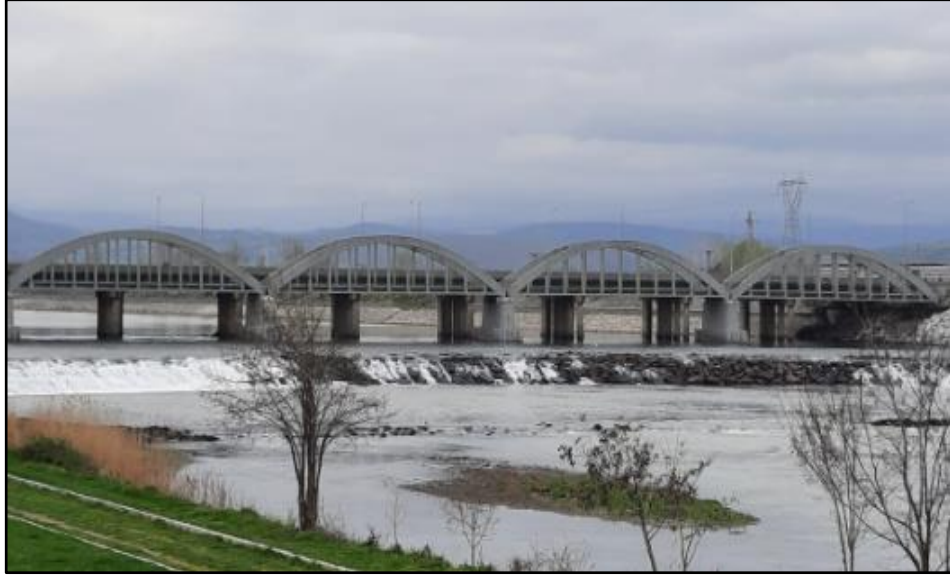
Şekil 5.92. Çetinkaya Köprüsü Günümüz Görüntüsü
