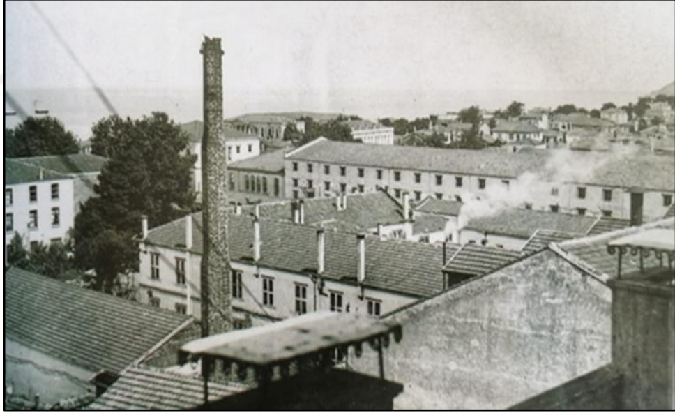
Şekil 5.1. Reji Sigara Fabrikası (İpek vd. 2016:109)
