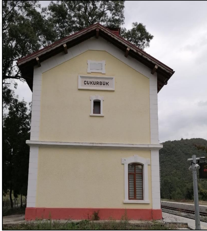
Şekil 5.71. Çukurbük Tren İstasyonu
