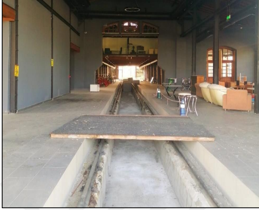
Şekil 5.85. Demiryolu Rayları Restorasyon Öncesi
