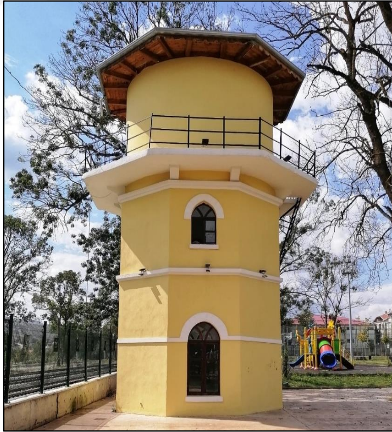
Şekil 5.96. Kavak Şimendifer Su İstasyonu
