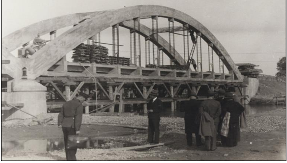
Şekil 5.90. Çetinkaya Köprüsü İnşaatı (Salt Araştırma, 2021)
