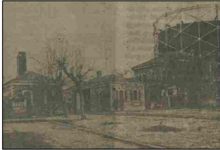
Şekil 4.29. Havagazı Fabrikası (Akşam Gazetesi, 1938:8)
