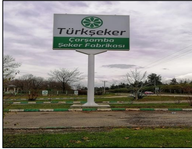
Şekil 5.26. Çarşamba Şeker Fabrikasının Giriş Bölümü
