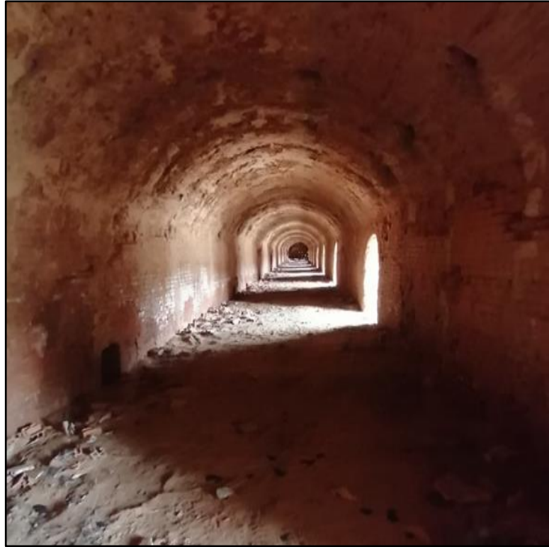
Şekil 5.19. Fabrika İçinde Fırınların Bulunduğu Yapı
