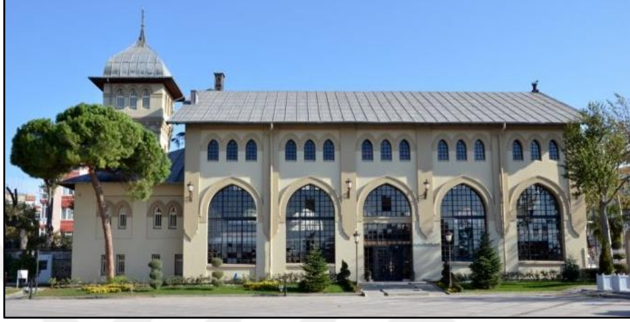
Şekil 4.22. Bağlarbaşı Elektrik Fabrikası'nın Günümüz Görünümü (Yıldız, 2021)
