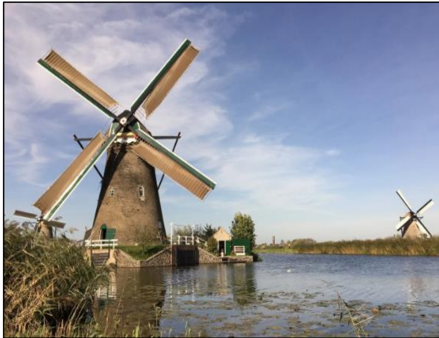
Şekil 3.2. Kinderdijk-Elshout Değirmen Ağı (Coggins, 2019)
