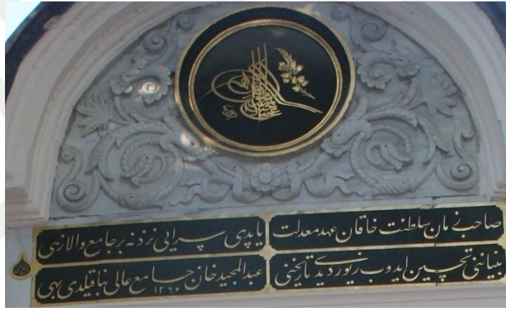
Resim 5.125. Küçük Mecidiye Camisi, inşa kitabesi
