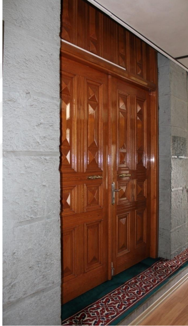
Resim 5.295. Kaptan Hasan Paşa Camisi, taçkapı genel görünüş
