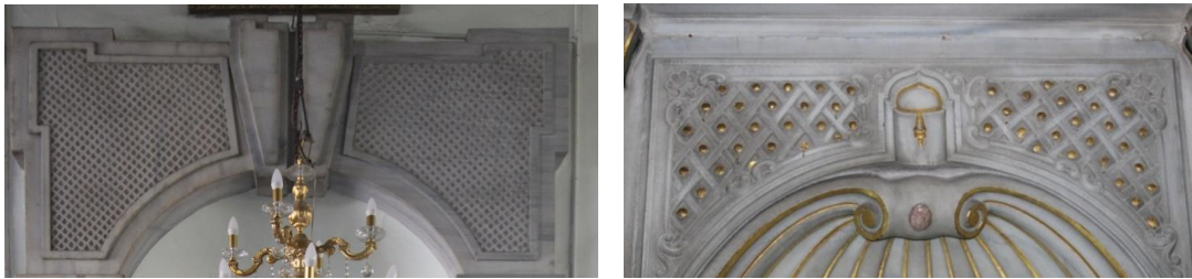
Resim 6.28. Kaptan Hasan Paşa ve Bala Süleyman Ağa camilerinde mihrap süslemeleri
