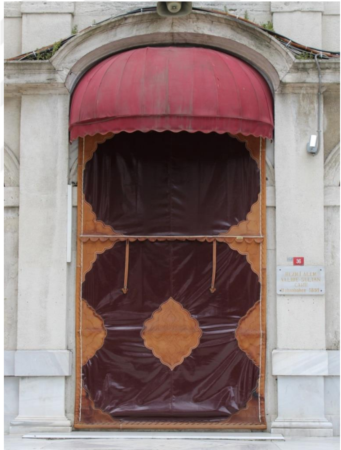
Resim 5.146. Dolmabahçe Camisi, taçkapı genel görünüş
