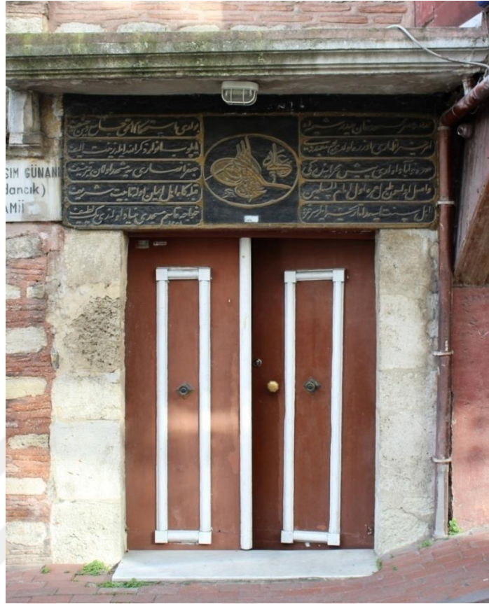
Resim 5.78. Hoca Kasım Günani Camisi, taçkapı genel taçkapı görünüş
