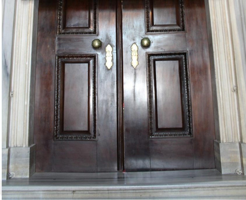
Resim 5.230. Pertevniyal Valide Sultan Camisi, taçkapı giriş açıklığı detay
