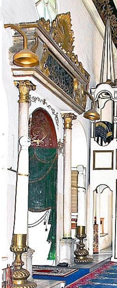
Resim 5.76. Küçük Selimiye Camisi, mihrabın restorasyon öncesi görünüşü
