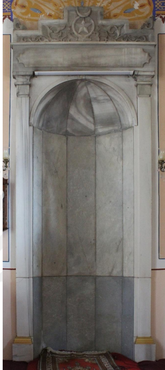
Resim 5.217. Fuad Paşa Camisi, mihrap genel görünüş
