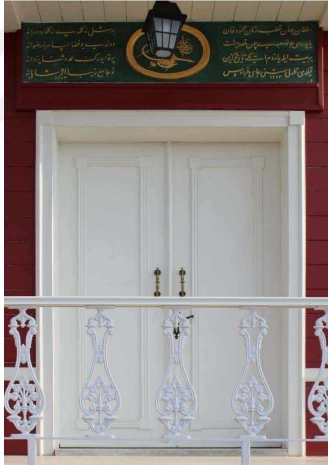
Resim 5.88. Kuleli Bahçe Camisi, taçkapı genel görünüş
