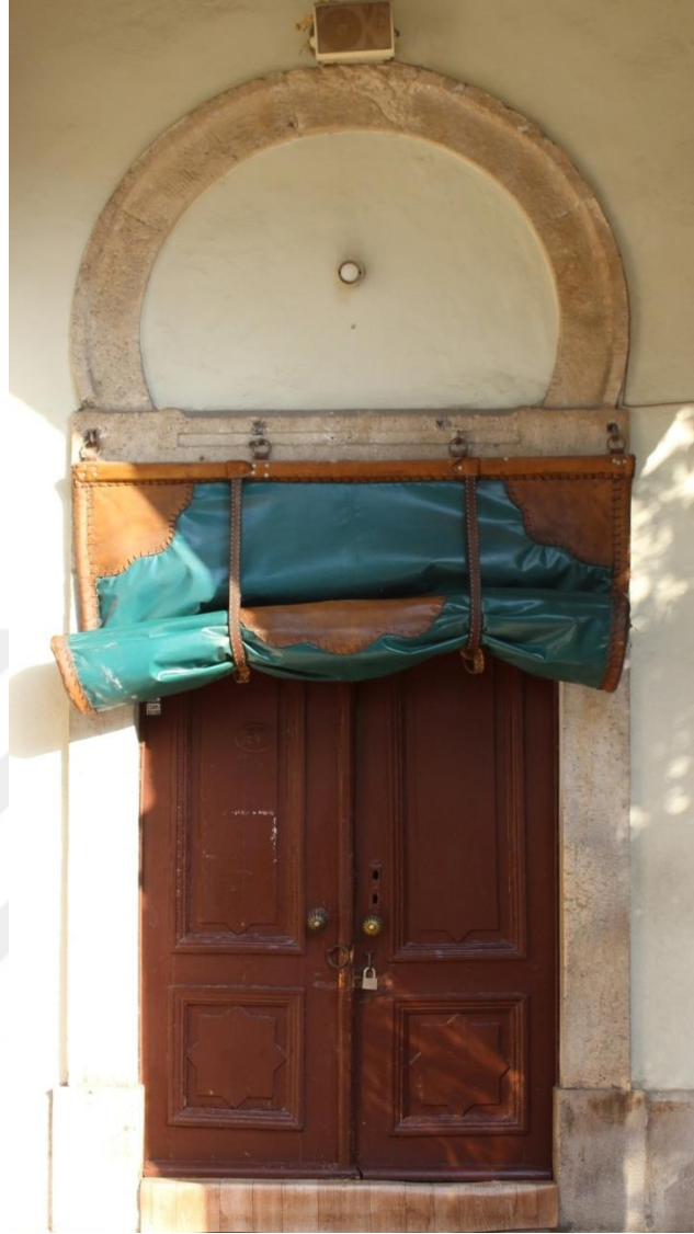
Resim 5.216. Fuad Paşa Camisi, taçkapı genel görünüş
