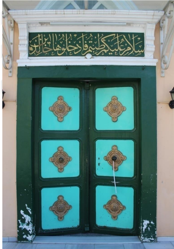
Resim 5.242. Zühdü Paşa Camisi, taçkapı genel görünüş
