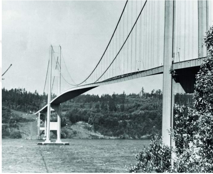
Şekil 3.2 : Tacoma Köprüsü rüzgar etkisiyle sallanırken ( Tacoma Narrows Köprüsü Neden Yıkıldı? , 2020).
