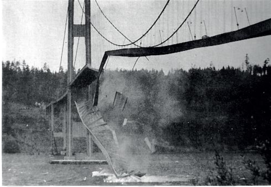
Şekil 3.3 : Tacoma Köprüsü rüzgar etkisiyle yıkılırken ( Tacoma Narrows Köprüsü Neden Yıkıldı? , 2020).
