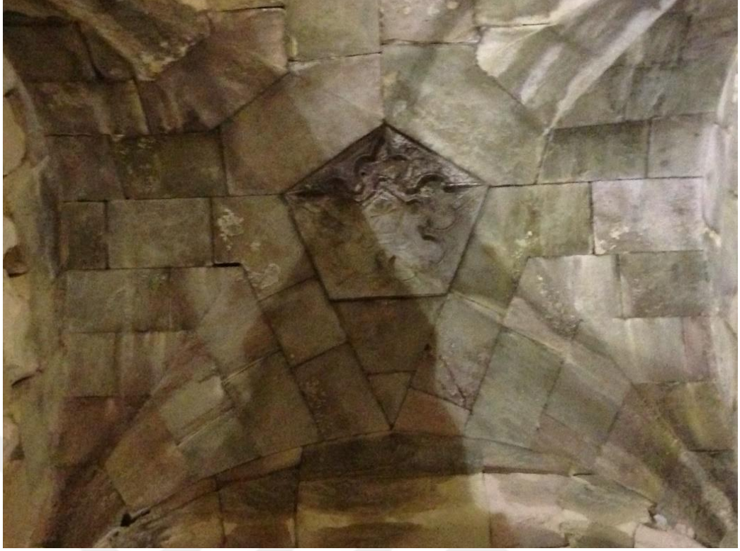
Şekil 73: Planda 8 Numarayla Gösterilen Çapraz Tono (Orijinal Fotoğraf : Ali Turan )
