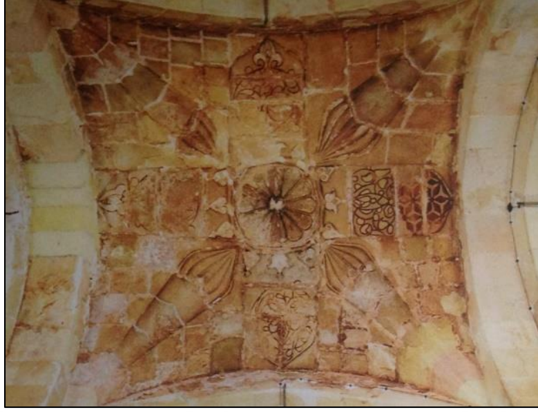
Şekil 48: Kaşık Biçimli Dört Oyuklu Karışık Manastır Tonozu Planda 9 Numara (Orijinal Fotoğraf : Ali Turan)
