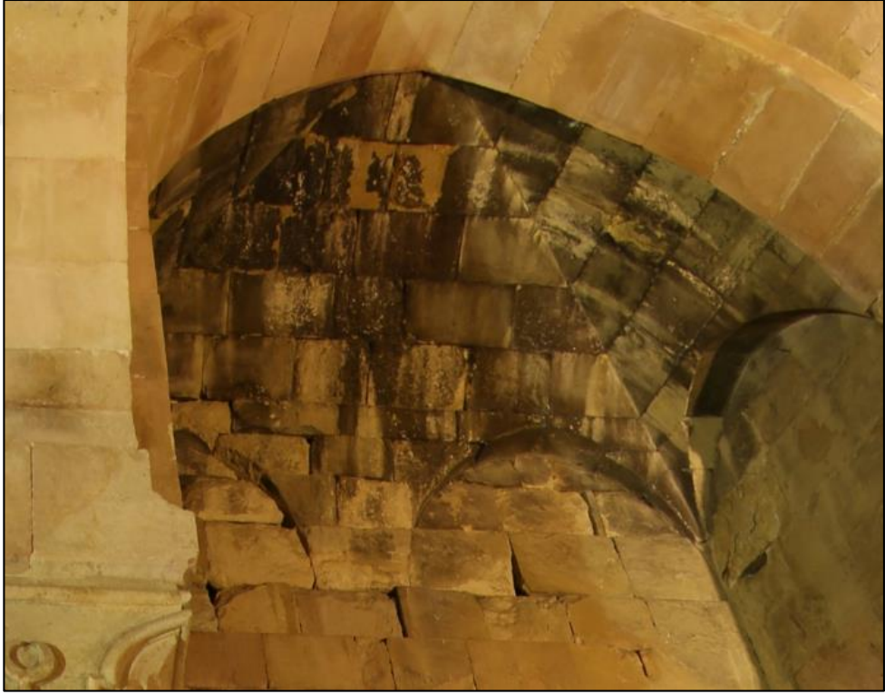
Şekil 72: Planda 7 Numarayla Gösterilen Sivri Tonoz (Orijinal Fotoğraf : Ali Turan )
