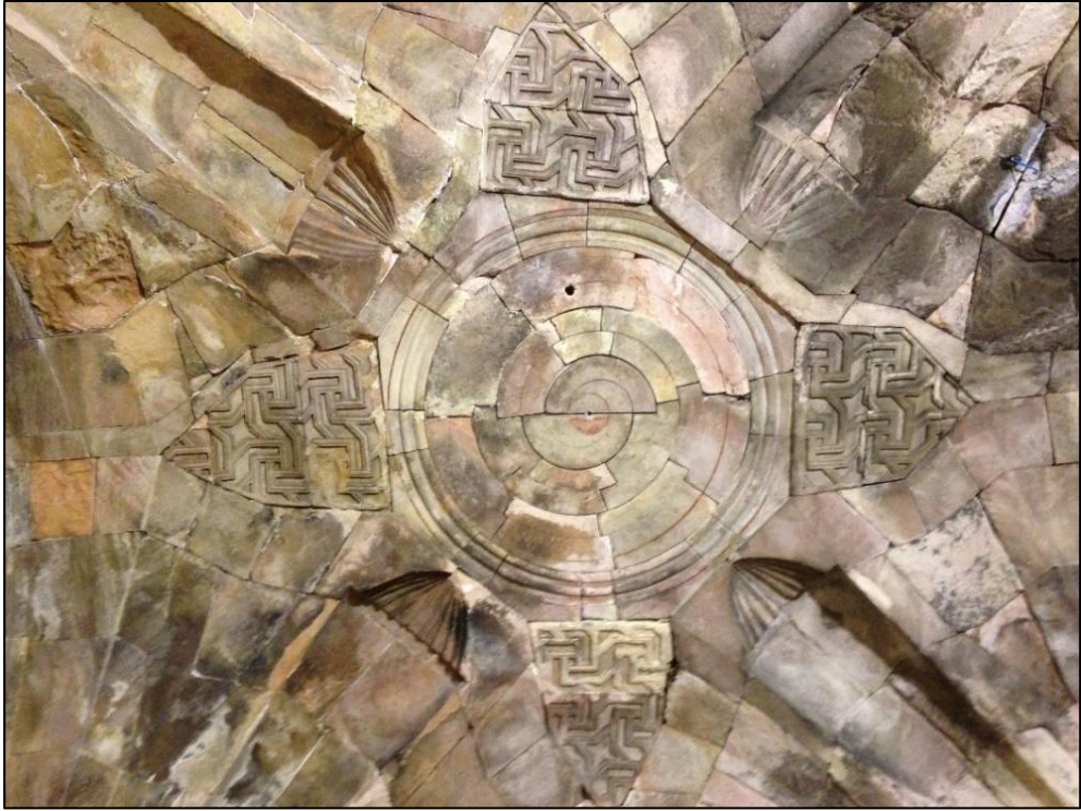
Şekil 70: Planda 5 Numarayla Gösterilen Ana Eyvan Tonozu (Orijinal Fotoğraf : Ali Turan )
