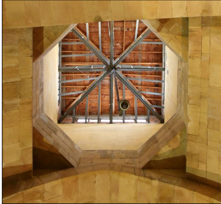
Şekil 222: Darüşşifanın Camlı Demir Doğrama Külahnın İç Kısmından Görünüşü (Orijinal Fotoğraf: Ali Turan)
