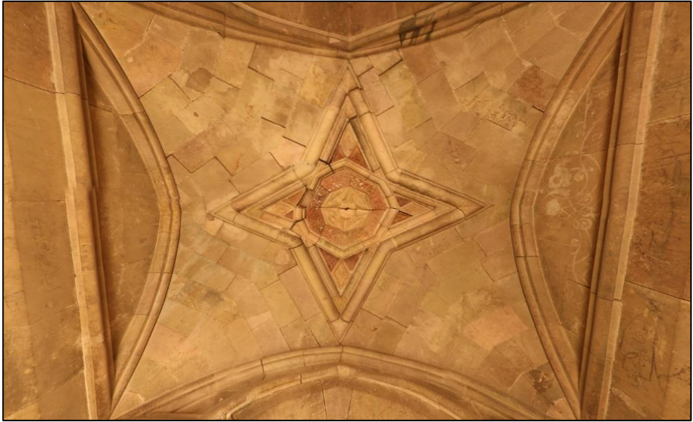
Şekil 66: Planda 1 Numara ile Gösterilen Darüşşifa Girişindeki Dört Kollu Yıldız Biçimindeki Tonoz (Orijinal Fotoğraf : Ali Turan )
