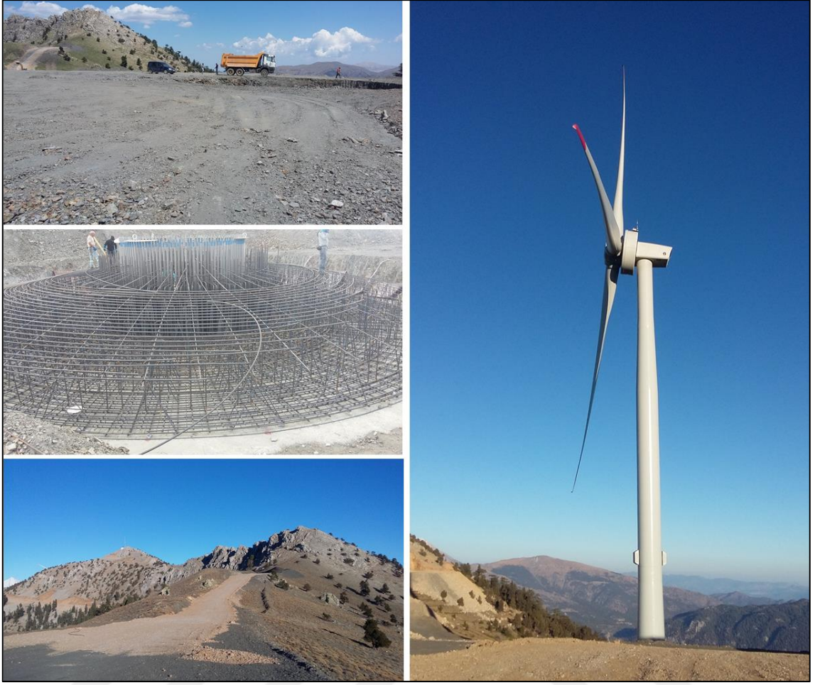
Fotoğraf 5.4. RES alt yapı çalışmaları
