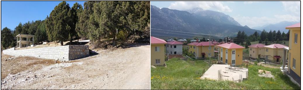
Fotoğraf 5.1. Alanda bilinçsiz yapılaşma sonucu oluşan tahribat
