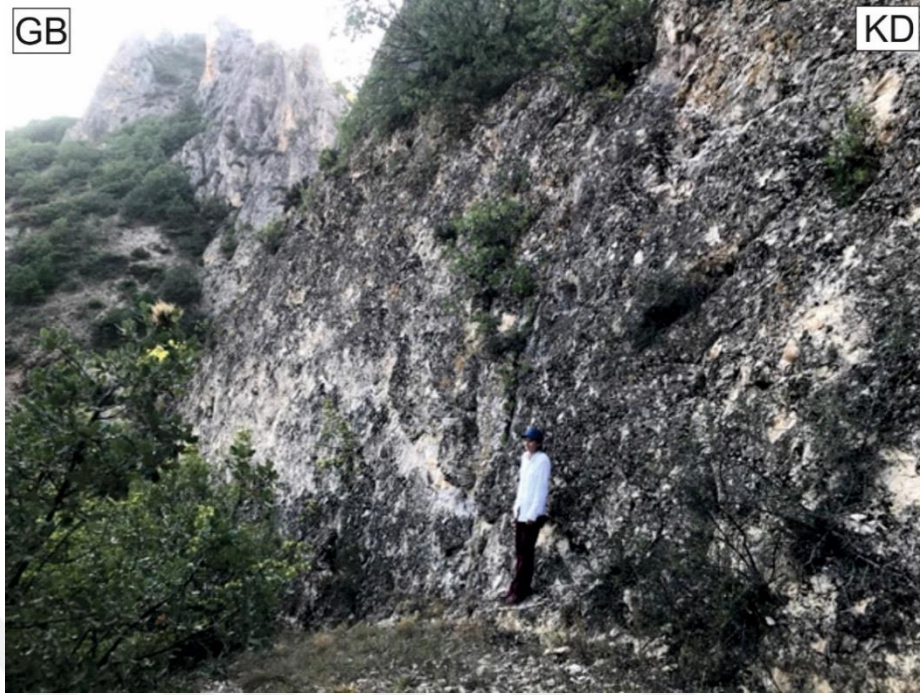
Şekil 4. 116: G-1118 no'lu lokasyonda gözlemlenen K51D/74KB duruşlu, eğim atımlı ters fay.
