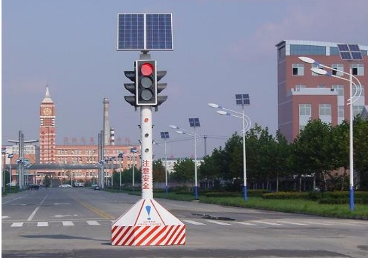
Şekil 2.25: Trafik işaretlerinde ve sokak lambalarında güneş enerji uygulamaları (Öztürk, 2012).
