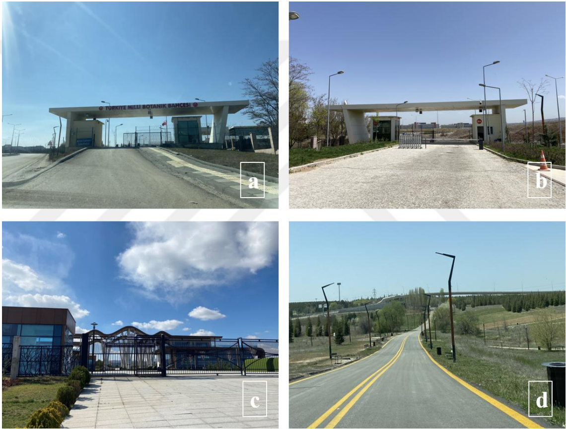
Şekil 4.29 TMBB girişleri: (a) ve (b) Personel ve servis giriş kapısı, (c) Ana giriş kapısı, (d) Tahliye girişine giden ana yol (Orijinal 2022)
