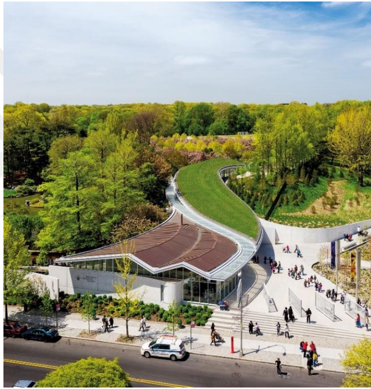
Şekil 2.27 Brooklyn Botanik Bahçesi Ziyaretçi Merkezi binası üzerinde bulunan yeşil çatı (Stamp, 2017)
