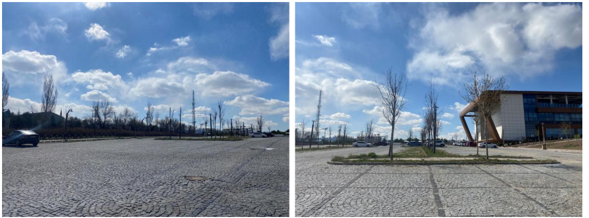
Şekil 4.13 TMBB Giriş Meydanının yanındaki açık otoparkta kullanılan doğal granit küp taş malzemesi (Orijinal 2022)
