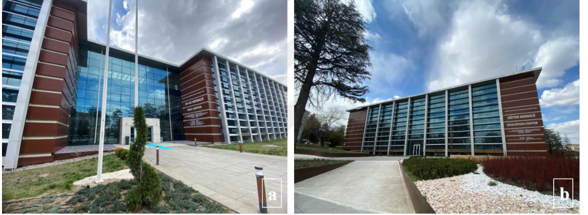
Şekil 4.19 TMBB AR-GE Merkezi binasında (a) ve Eğitim Merkezi binasında (b) ultraviyole korumalı camların görünümü (Orijinal 2022)
