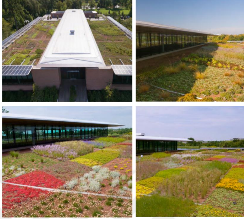
Şekil 2.28 Chicago Botanik Bahçesi, Bitki Bilim Merkezi binası üzerinde bulunan yeşil çatı (Hawke, 2015)
