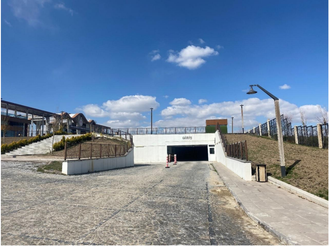
Şekil 4.26 TMBB Giriş ve Karşılama Merkezi binası ile giriş meydanının altında bulunan 1500 araçlık yer altı otoparkı girişi (Orijinal 2022)
