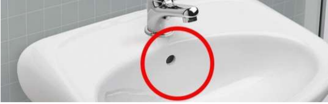
Şekil 2.14 : Lavabolarda su taşma deliği.
