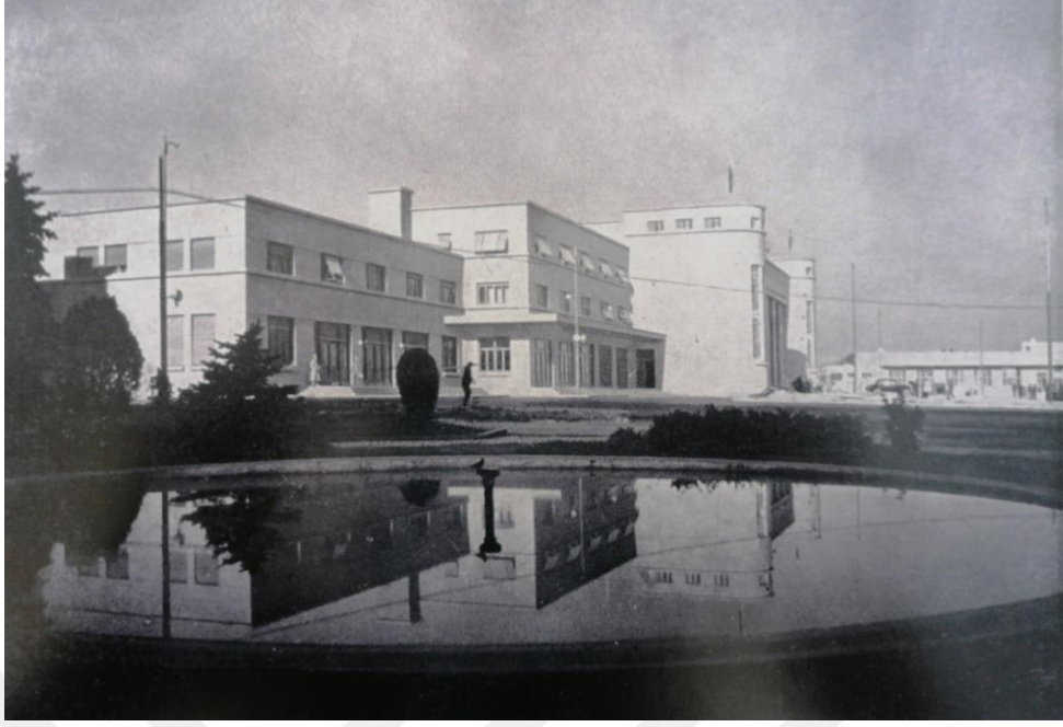
F.69: Ankara yeni gar binasının ön cephesine doğudan bakış (Aycı 1937:47)
