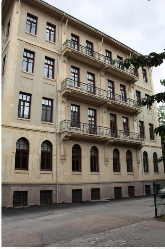
F.60: TCDD II. Genel Müdürlük Binası (Medipol Üniversitesi) güneybatı cephesi
