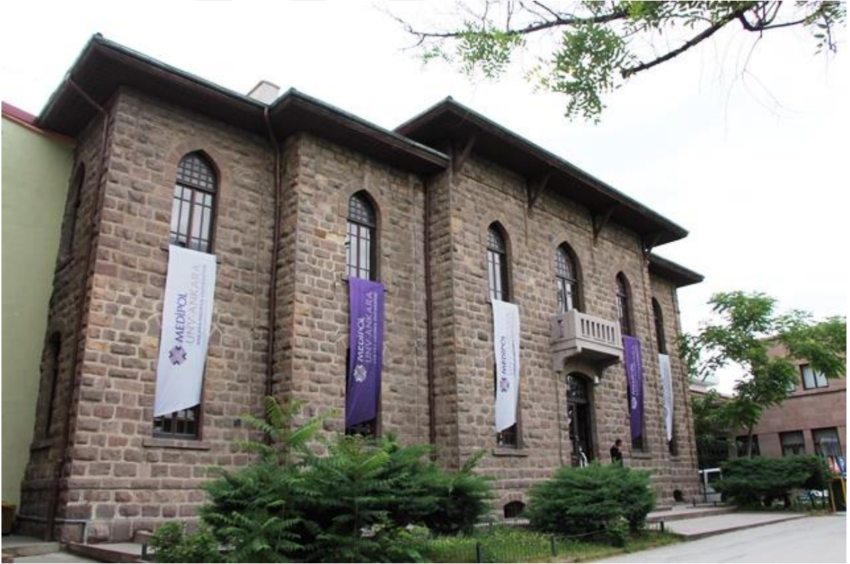
F.34: Ankara Otelı kuzeydoęu cephesi
