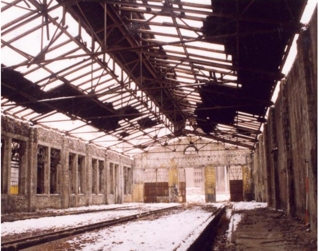
F.41: Galeri 4 iç mekan (Kaynak: Uygur Mimarlık, Fotoğraf arşivi)
