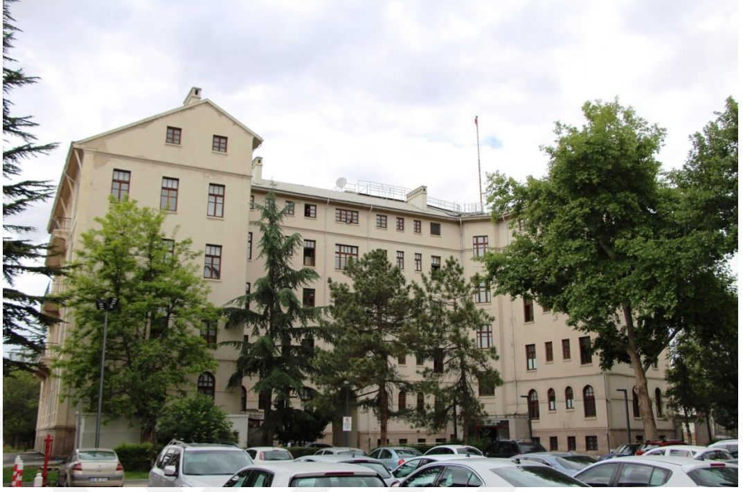
F.58: TCDD II. Genel Müdürlük Binası (Medipol Üniversitesi) güneydoğu (giriş) cephesi
