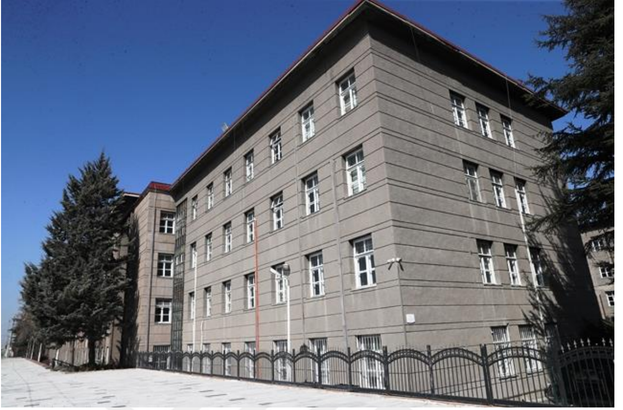
F.107: TCDD Genel Müdürlüğü güneybatı (peron) cephesi
