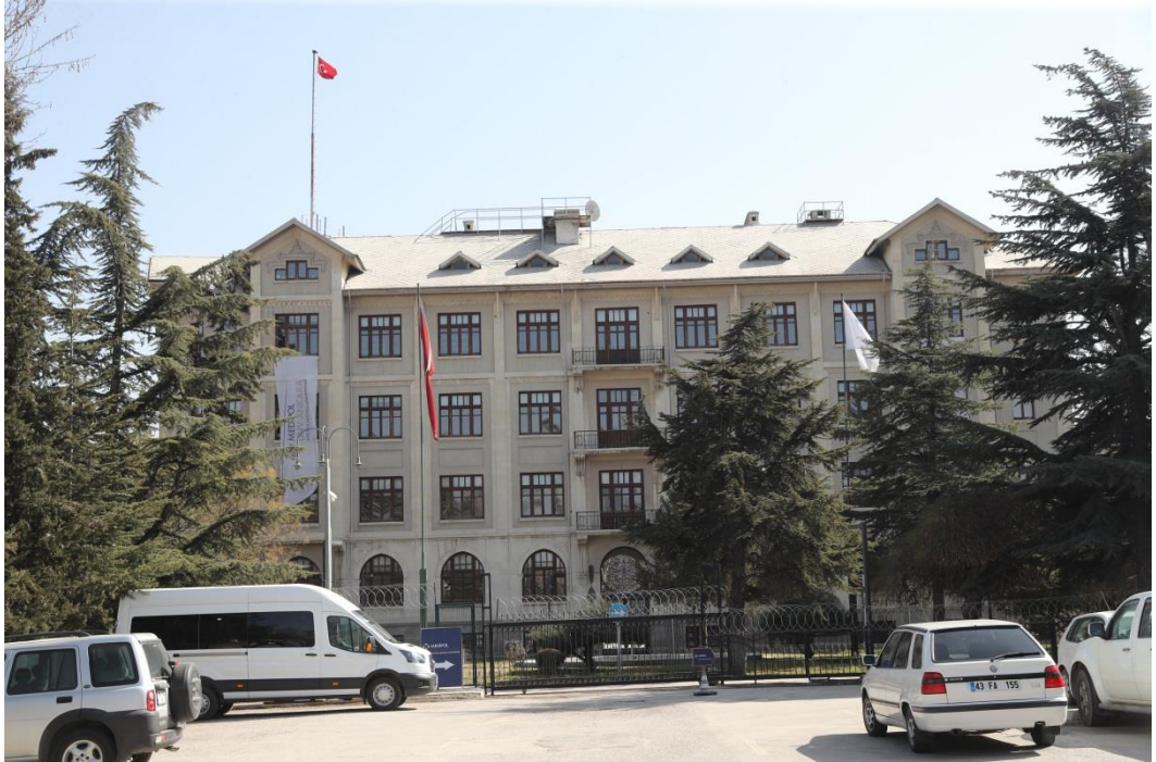
F.59: TCDD II. Genel Müdürlük Binası (Medipol Üniversitesi) kuzeybatı cephesi
