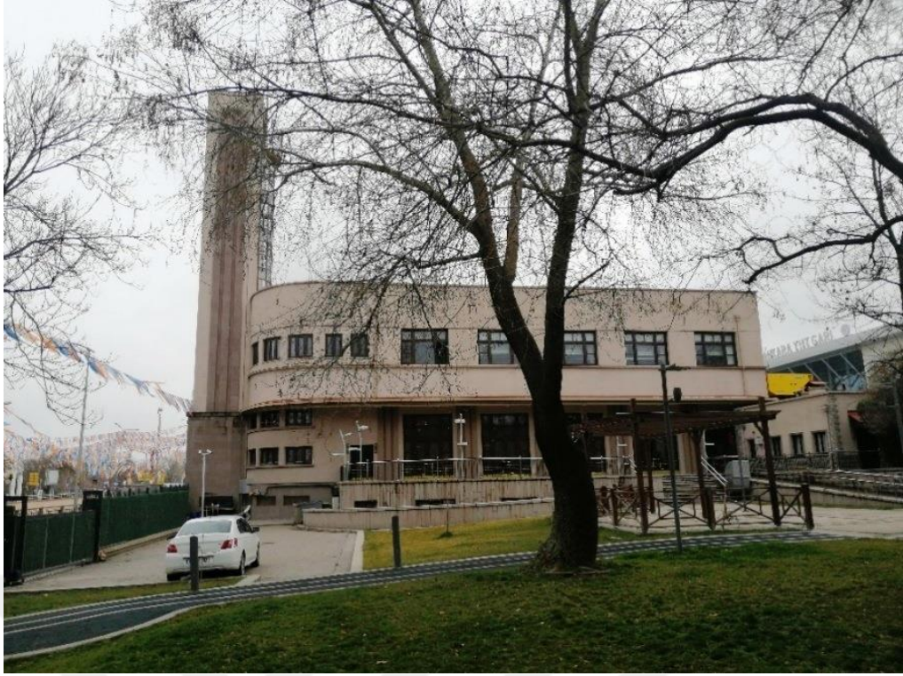
F.96: Gar Gazinosu güneydoğu cephesi
