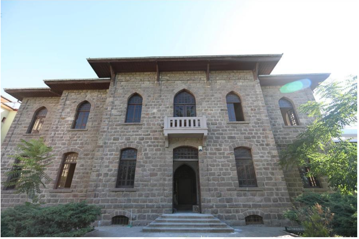
F.33: Ankara Otelı kuzeydoęu cephesi 149
