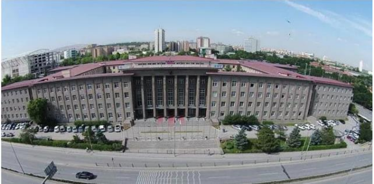
F.104: TCDD Genel Müdürlüğü kuzeydoğu cephesi 206
