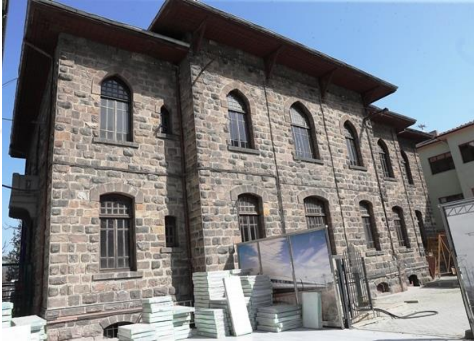
F.36: Ankara Oteli güneybatı (peron) cephesi
