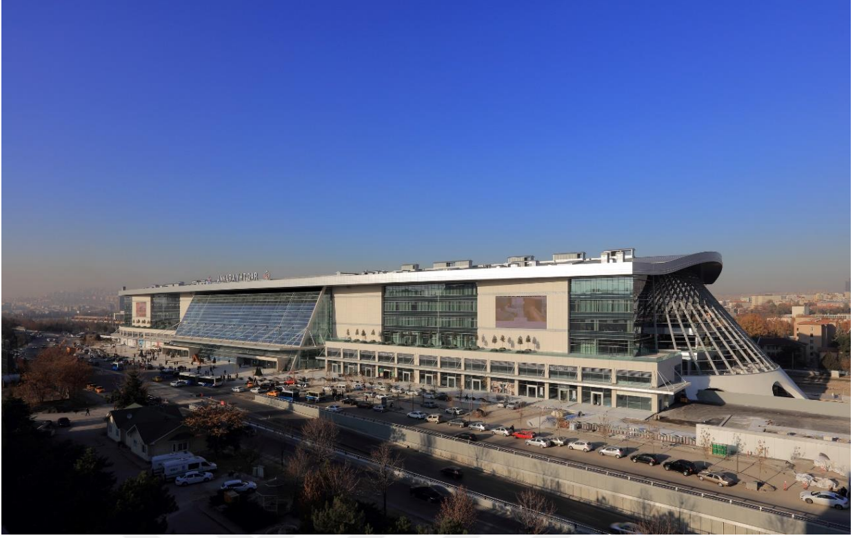
F.116: Ankara Yüksek Hızlı Tren Garı güneybatı cephesi 217
