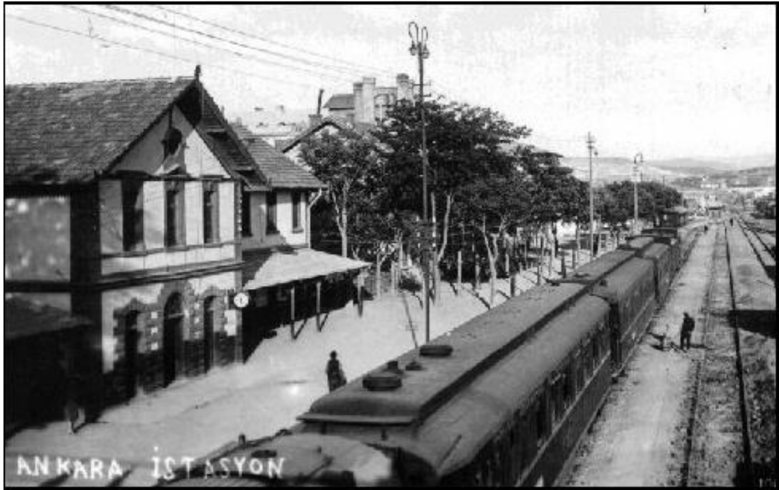
F.21: Eski istasyon binasının demiryolu cephesi
