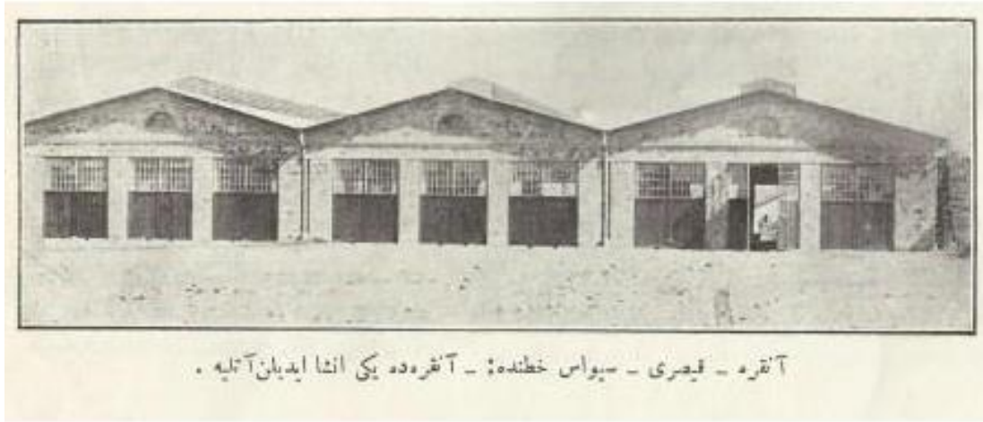
F.37: CerModern'in temelini oluşturan demiryolu atölye binası.
