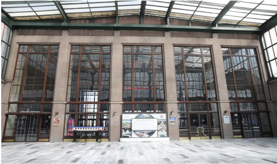
F.87: Ankara Garı güneybatı cephesi peronlara çıkış
