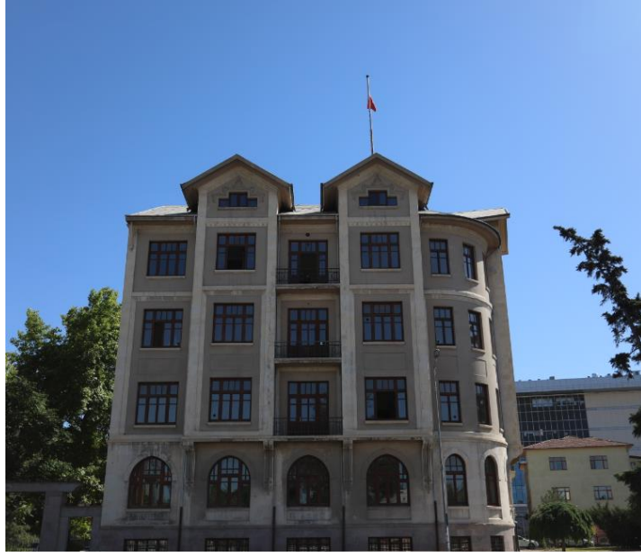
F.62: TCDD II. Genel Müdürlük Binası (Medipol Üniversitesi) Kuzeydoğu (Talatpaşa Bulvarı) cephesi 174
