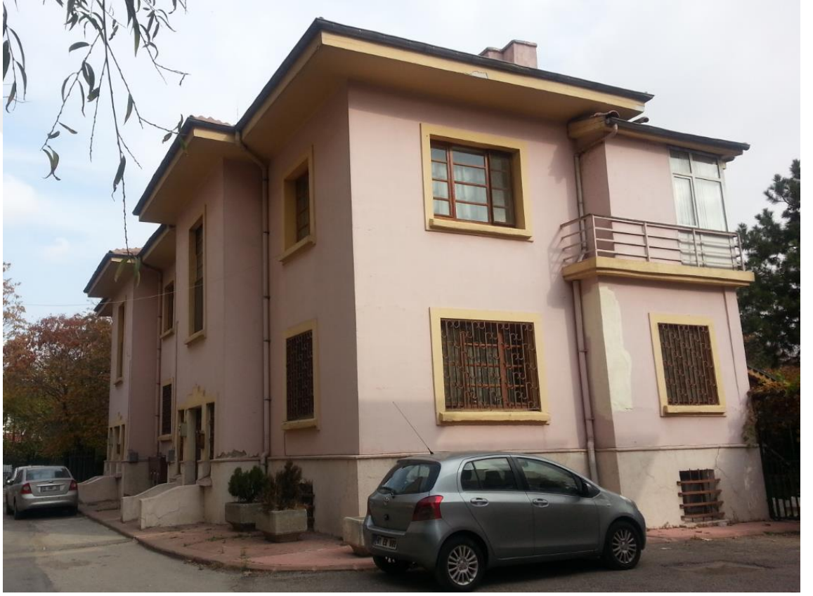
F.113: TCDD İşletmesi Genel Müdürlüğüne ait lojman güneydoğu cephesi
