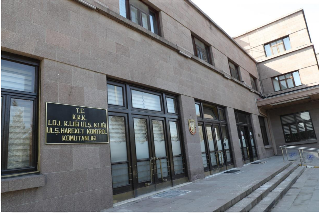
F.82: Ankara Garı kuzeydoğu cephesi (sol kanat) iki katlı bölüm
