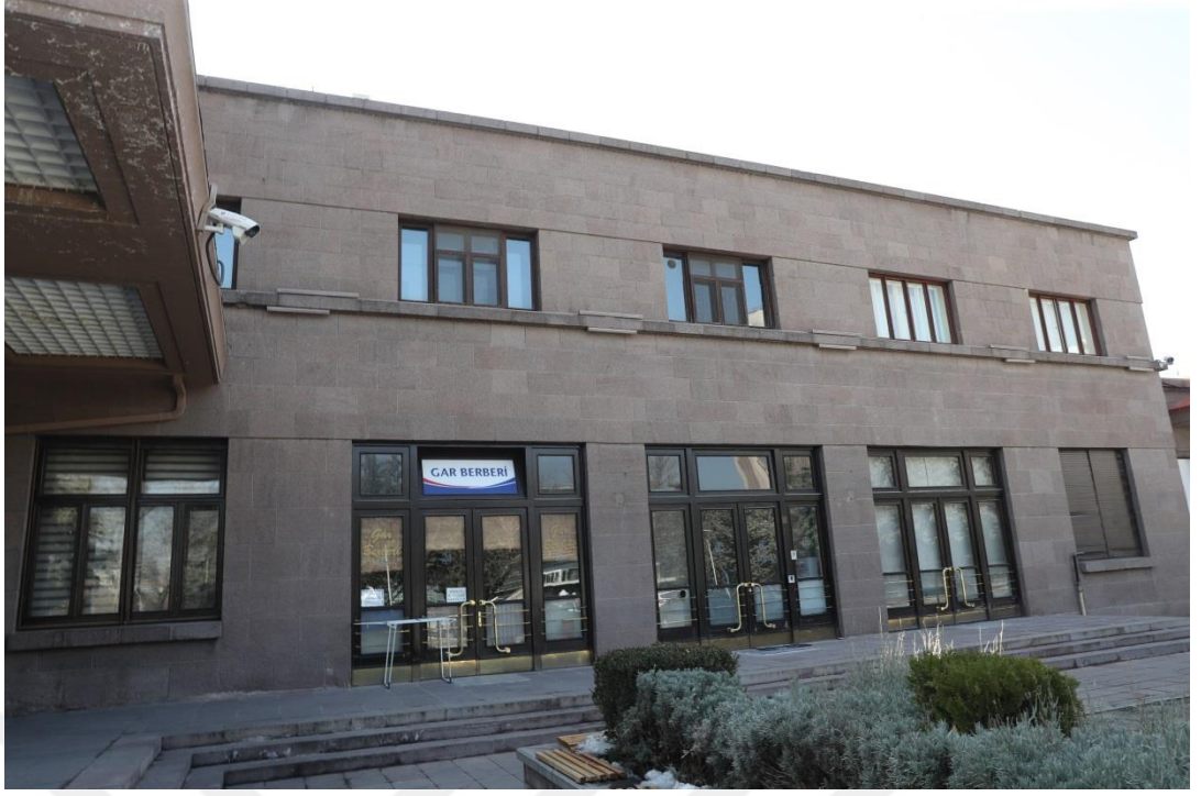
F.84: Ankara Garı kuzeydoğu cephesi (sağ kanat) iki katlı bölüm
