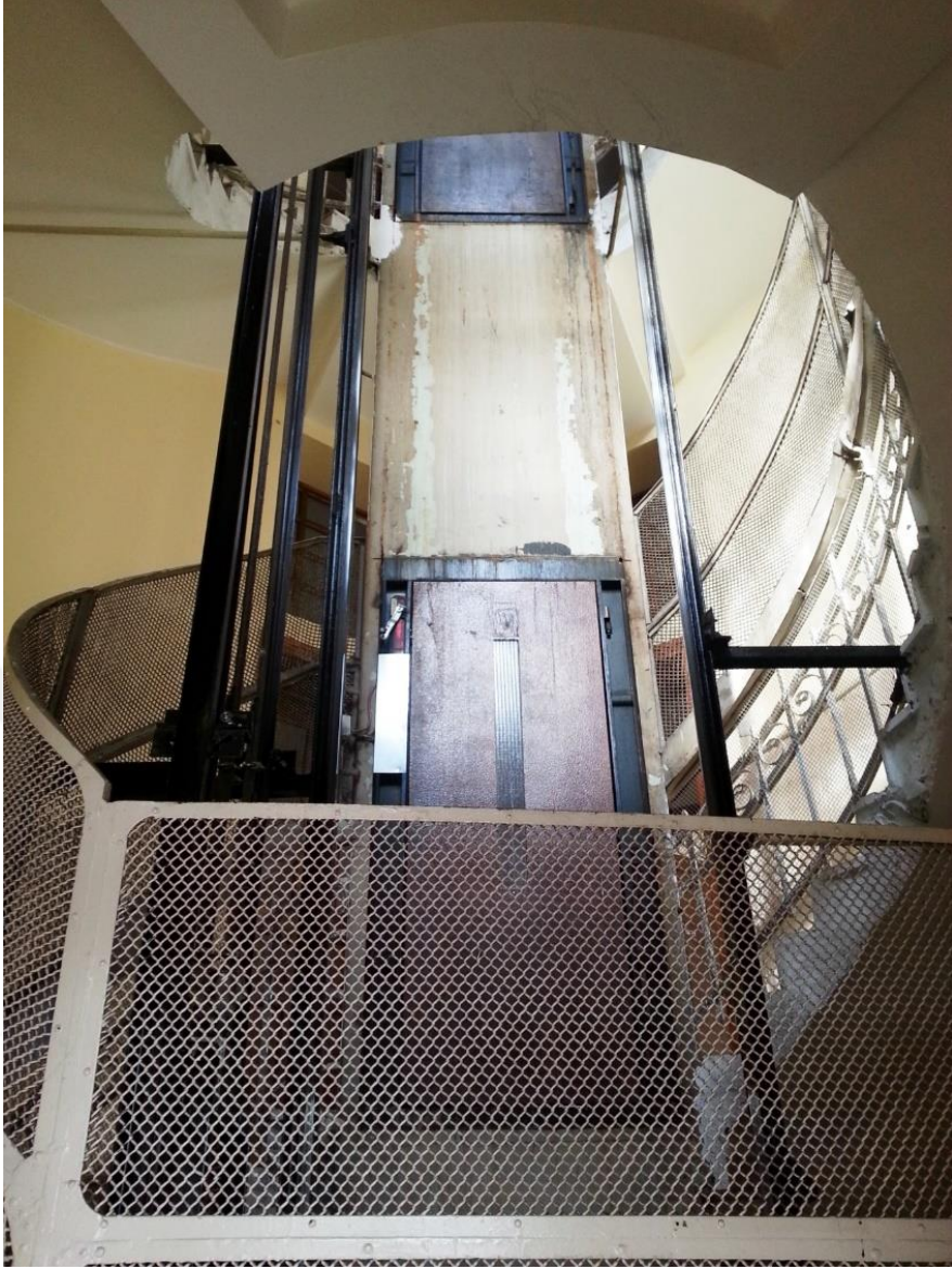
F.66: TCDD II. Genel M¼d¼rl¼k Binası (Medipol ¼niversitesi) asans¼r (Kaynak: TCDD Arşivi)
