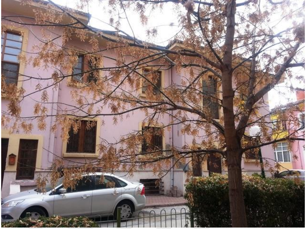
F.114: TCDD İşletmesi Genel Müdürlüğüne ait lojman güneydoğu cephesi
