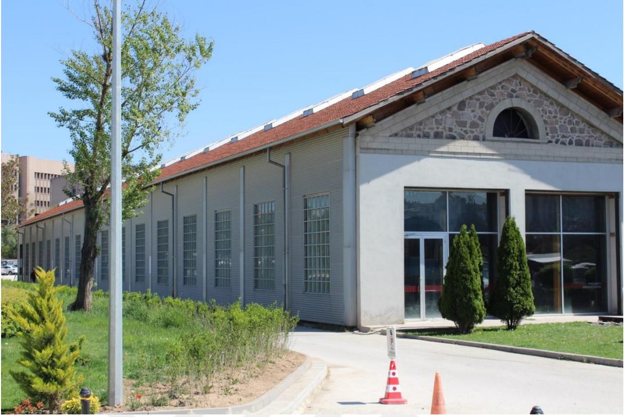
F.48: Galeri birimleri (galeri-4) güneybatı cephesi
