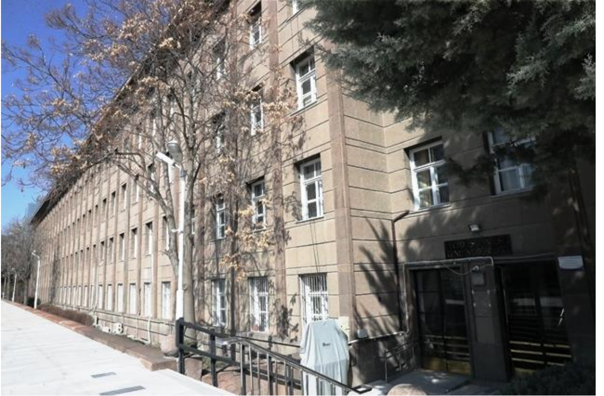
F.108: TCDD Genel Müdürlüğü güneybatı (peron) cephesi
