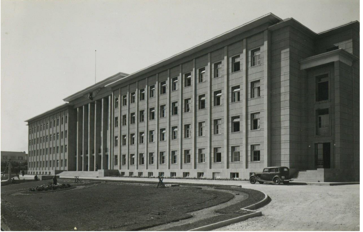
F.103: TCDD Genel Müdürlüğü kuzeydoğu cephesi 203
