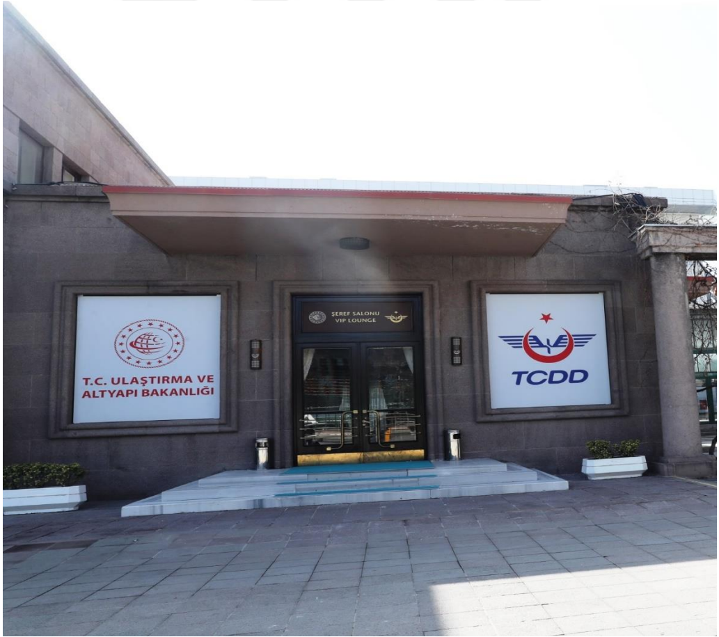
F.85: Ankara Garı kuzeydoğu cephesi (sağ kanat) tek katlı bölüm
