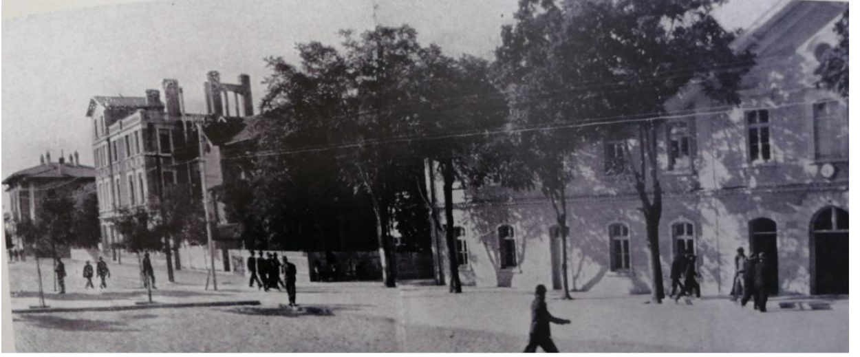
F.18: Eski istasyon binası şehir cephesi
