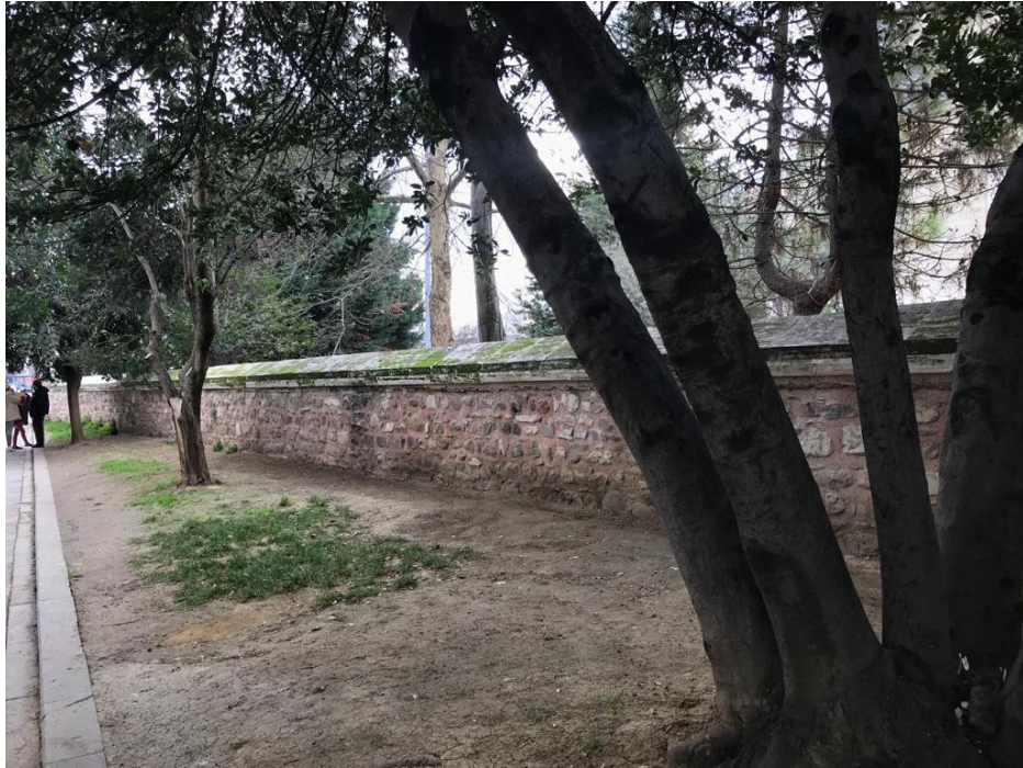
Fotoğraf 16. Doğu cephe arka avlu duvarı (Eylül 2021)
