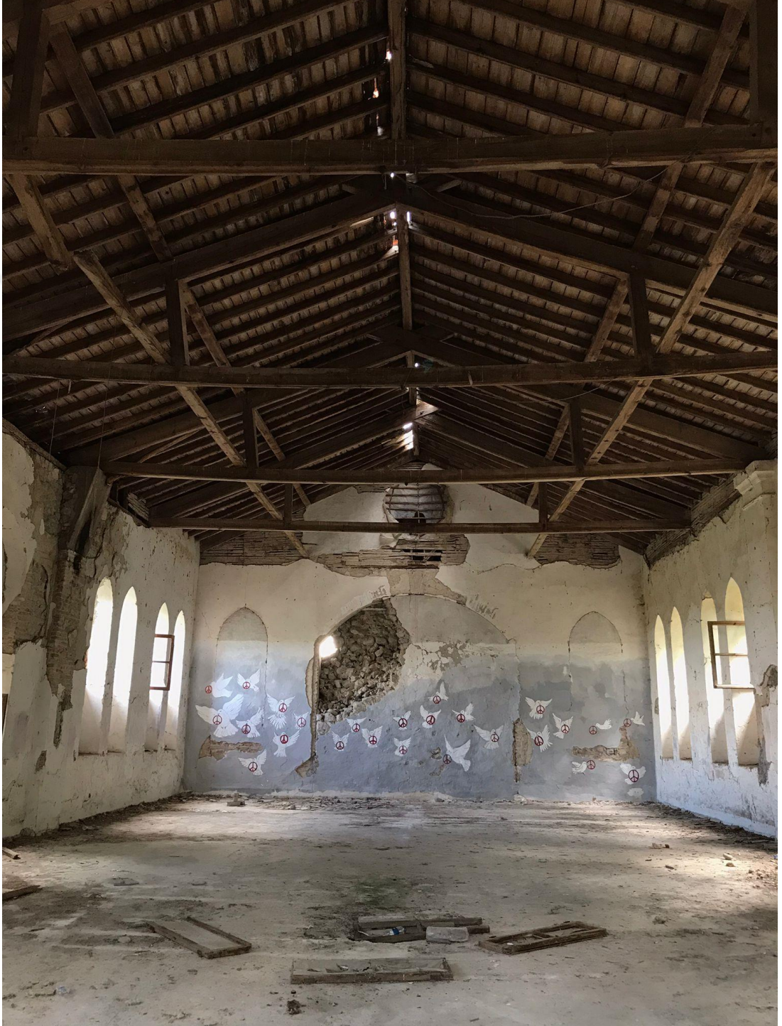
Fotoğraf 74. Birinci kat iç mekan görünümü (Eylül 2021)
