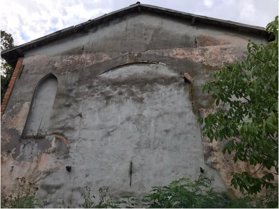
Fotoğraf 64. Kuzeydoğu cephesi (Eylül 2021)
