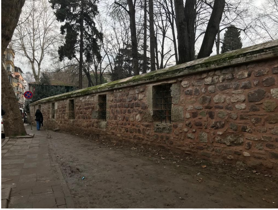
Fotoğraf 19. Batı cephe ön avlu duvarı (Eylül 2021)
