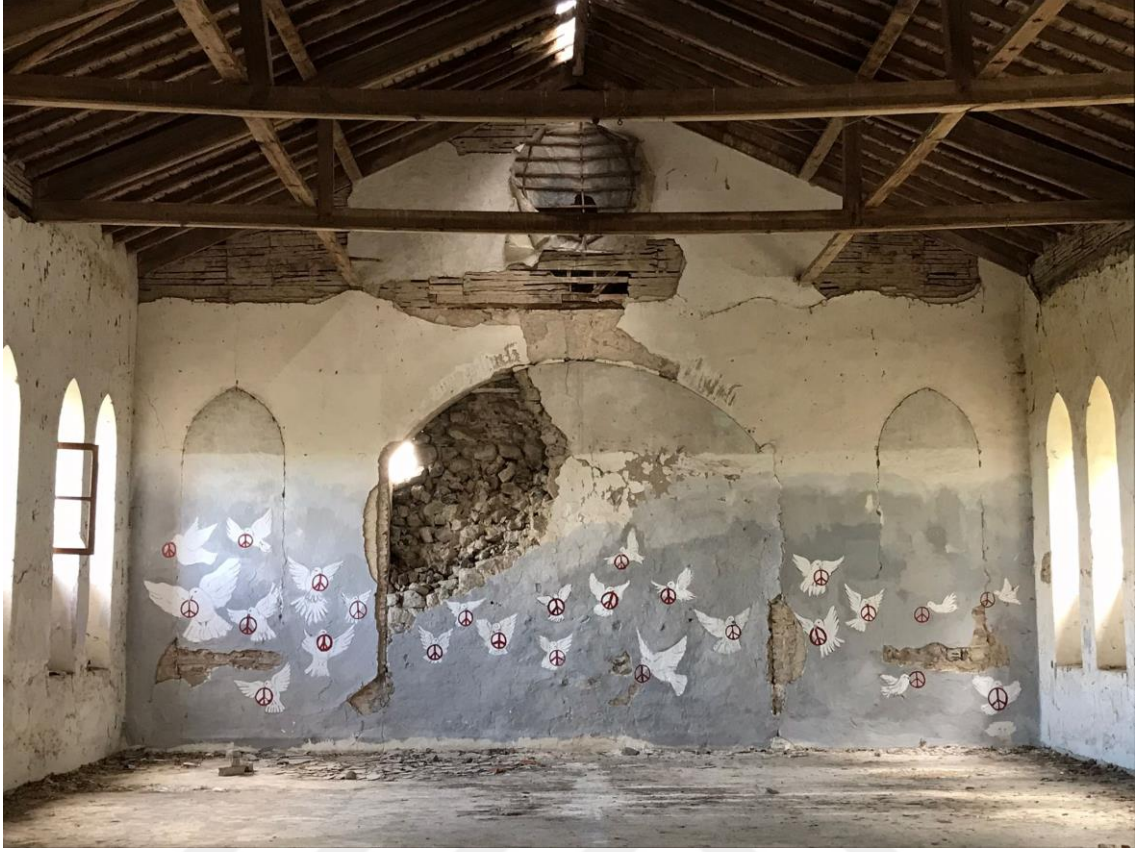
Fotoğraf 75. Birinci kat kuzeydoğu duvarına bakış (Eylül 2021)
