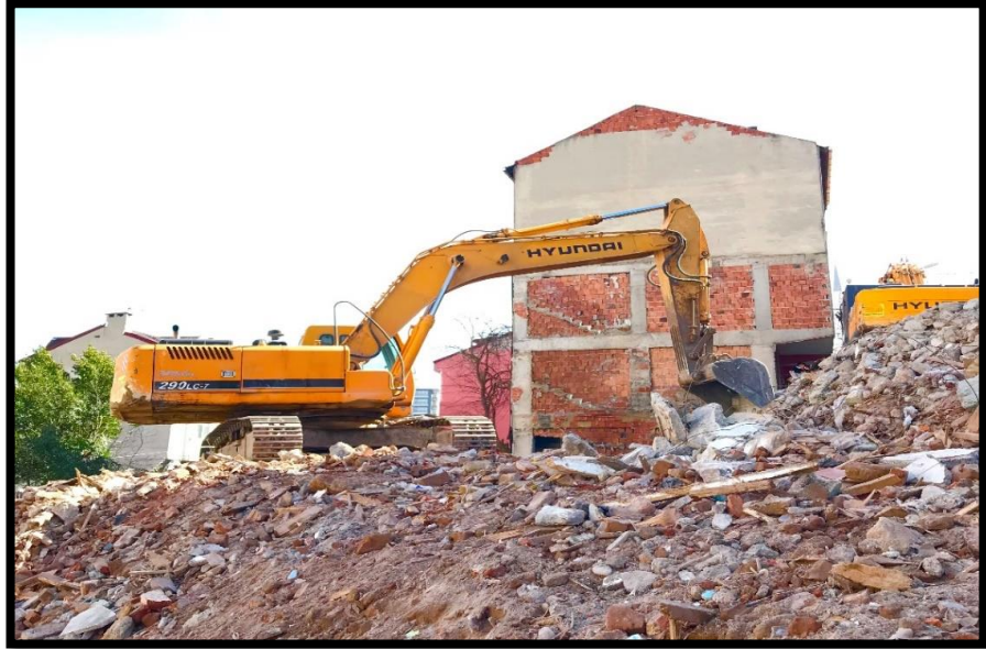
Fotoğraf 34: Kentsel Dönüşüm Projesi Kapsamındaki Çalışmaların Devam Ettiği Sarıgöl Mahallesi
