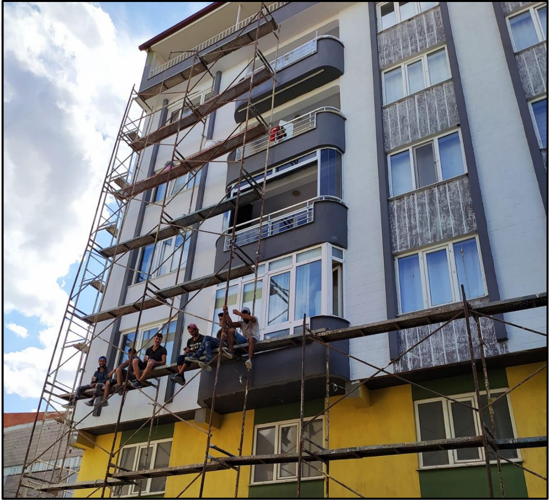
Foto 16: İnşaat İskelesinde Dinlenme Molası Veren Mevsimlik İnşaat İşçileri (Soma/Manisa)
