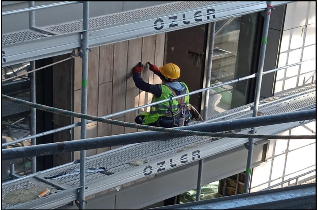
Foto 8: İnşaat İşinde Çalışan Mevsimlik İşçi (Esenyurt/İstanbul)
