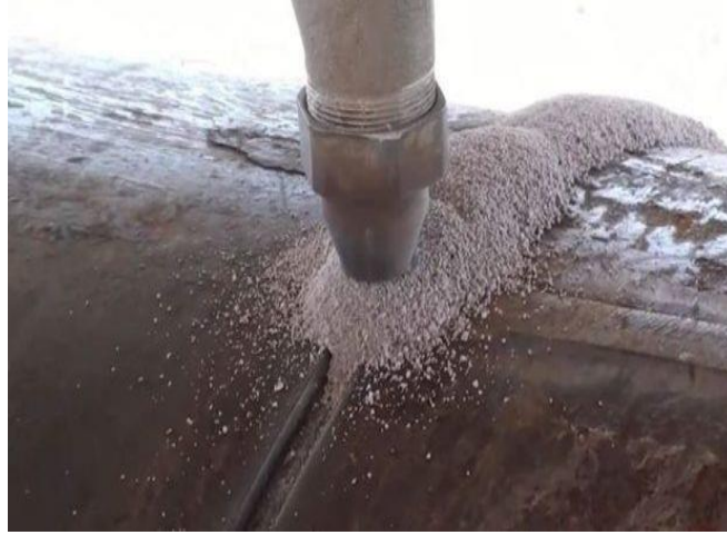
Şekil 6.3: Tozaltı Kaynağı Uygulaması
