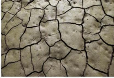
Şekil 1.1 Çatlamış kil tabakası
