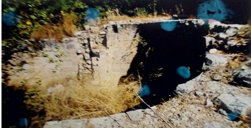
Resim 8: Eşek Deresinde Bulunan Kilise Yıkıntısı
