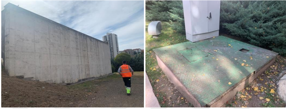
Şekil 3.15.Dikmen Vadisi Su Deposu Görselleri (Tiğiz, 2021)
