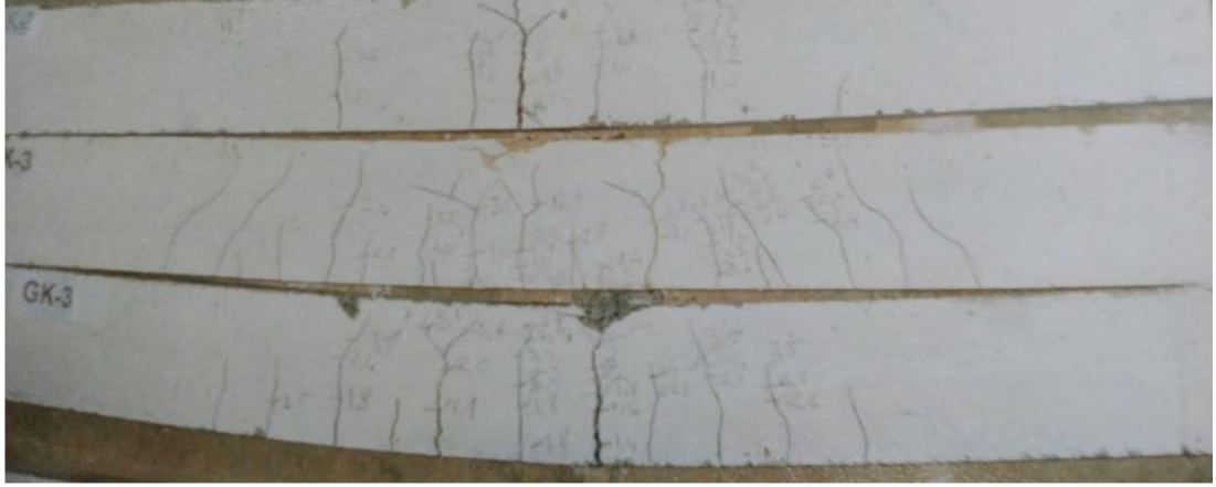
Şekil 3.9: Beton bir kirişin eğilme etkisinde kırılması
