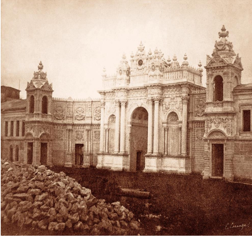
Foto 15. Dolmabahçe Sarayı İnşatı (İstanbul Araştırmaları Enstitüsü Fotoğraf Arşivi).
