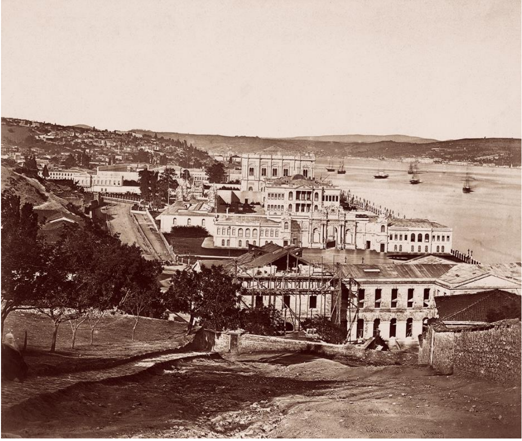
Foto. 40. Dolmabahçe Saray Tiyatrosu İnşaatı (İstanbul Araştırmaları Enstitüsü Fotoğraf Arşivi).
