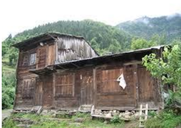
Şekil 4.6. Yapı Kabuğunda Ahşap Malzeme
