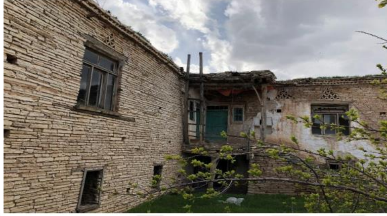
Şekil 4.5. Yapı Kabuğunda Taş Malzeme
