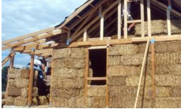
Şekil 4.3. Yapı Kabuğunda Saman Balyası
