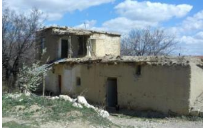
Şekil 4.4. Yapı Kabuğunda Kerpiç Malzeme
