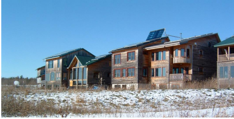
Şekil 4.11. Ithaca Eko-Köyünde Fotovoltaik Paneller
