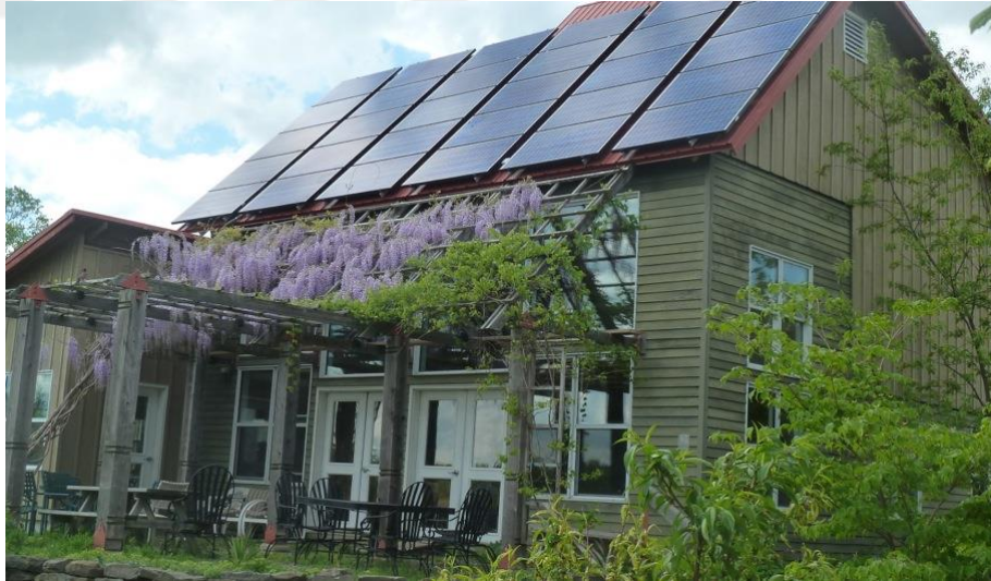
Şekil 4.10. Ithaca Eko-Köyünde Fotovoltaik Panel Kullanan Bir Ev
