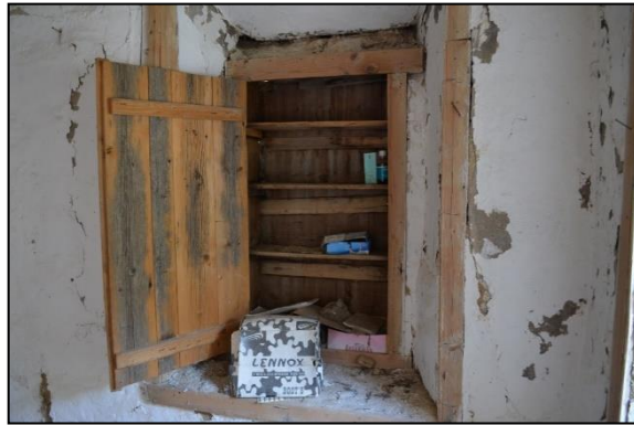
Şekil 78. Pencereden dönüştürülmüş dolap.
