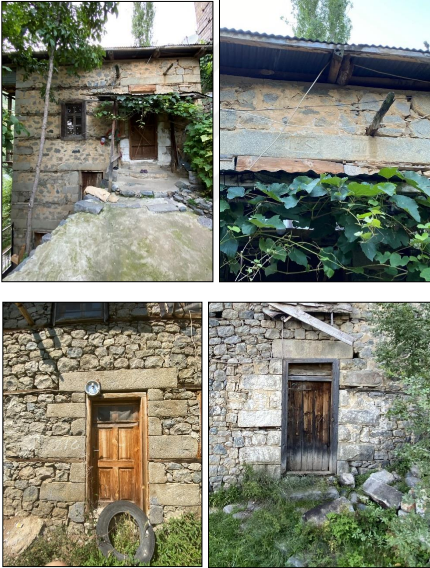
Şekil 105. Dış kapıların üzerinde semboller ya da inşa tarihi bulunan taş lento bloklar.
