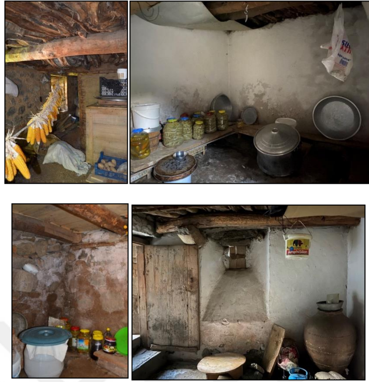
Şekil 84. Depo amaçlı kullanılan alt zemin katı.
