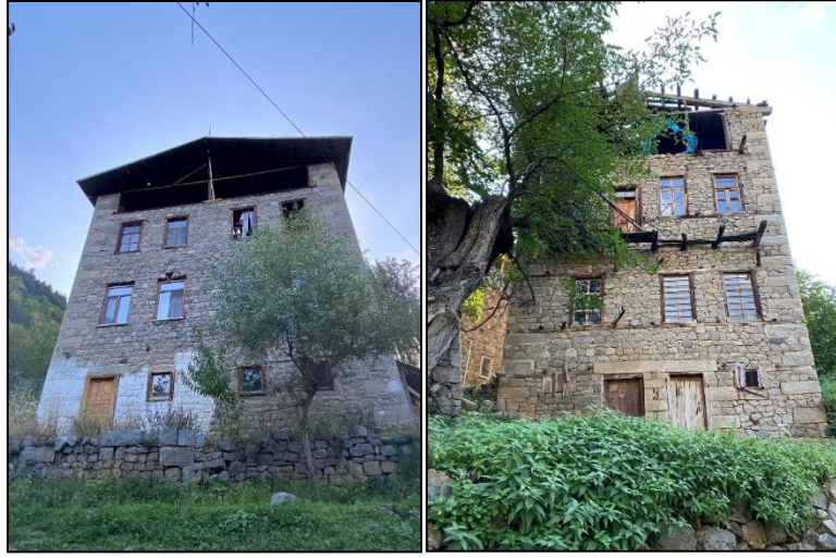
Şekil 93. Cephesinde çatı açıklığı bulunan yapılar.
