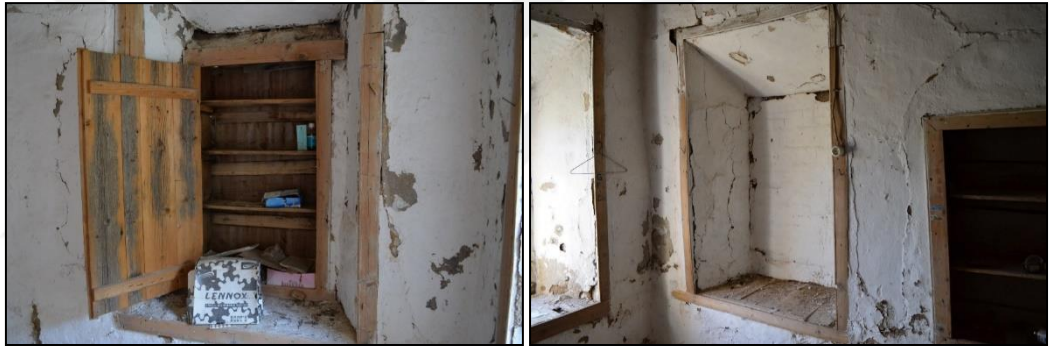
Şekil 102. Sırasıyla, dolaba çevrilmiş pencere açıklığı, kapatılmış pencere açıklığı.
