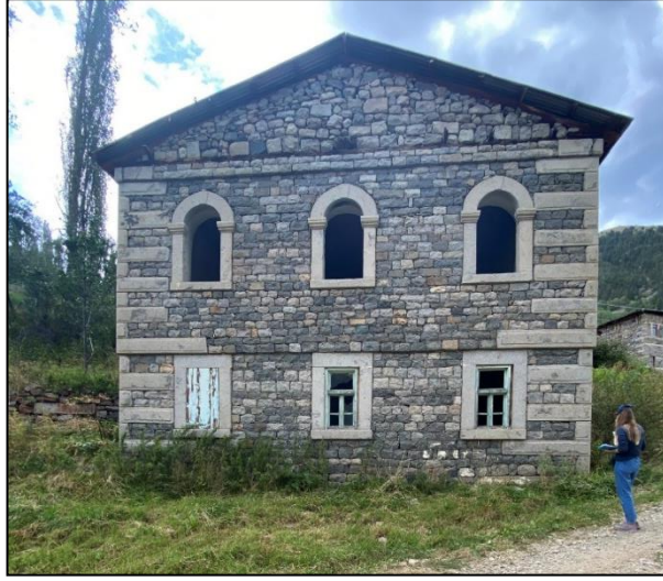
Şekil 98. Kemerli ve taş blok söveli pencere.
