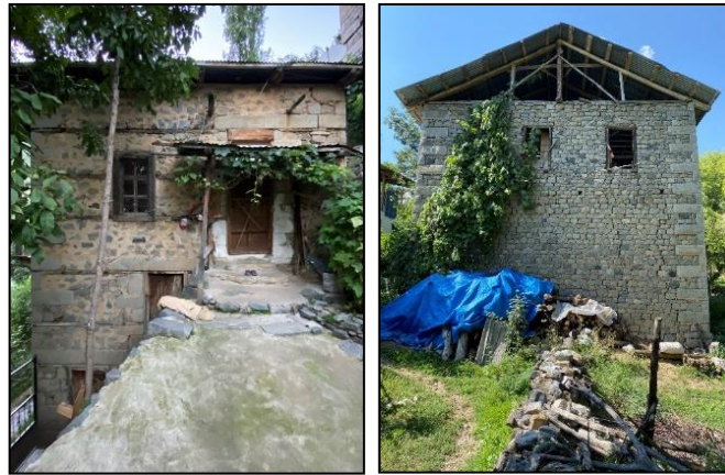
Şekil 52. Sırasıyla 7 nolu tescile önerilen yapı, 52 nolu tescile önerilen yapı.
