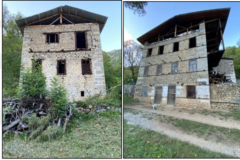
Şekil 51. Sırasıyla, 34 nolu ve 54 nolu tescilli yapılar.
