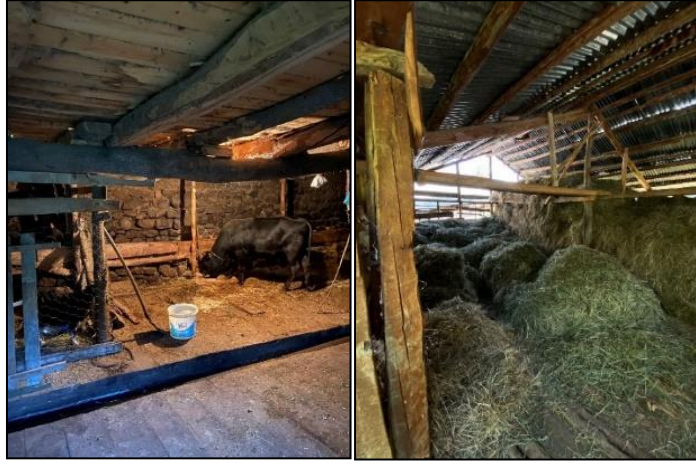
Şekil 86. Sırasıyla, ahırın zemin katı ve birinci katı.
