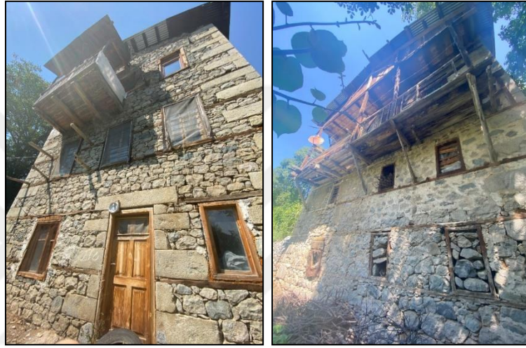
Şekil 111. Ahşap balkon çıkmaları.
