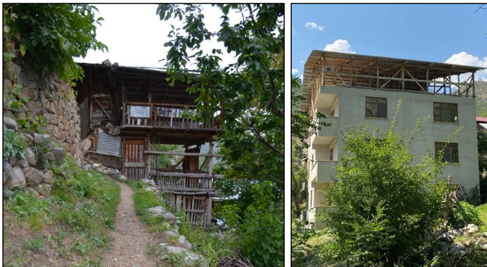
Şekil 55. Sırasıyla, 17 nolu ahşap seyir terası ve 22 nolu betonarme yapı.
