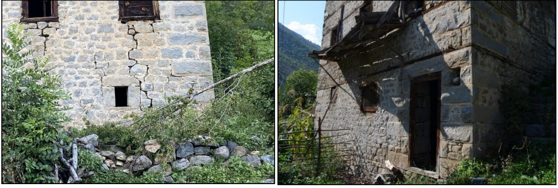
Şekil 101. Alt zemin kat pencereleri.
