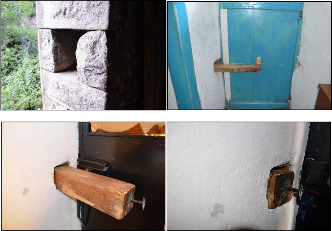
Şekil 106. Kilit sistemi.
