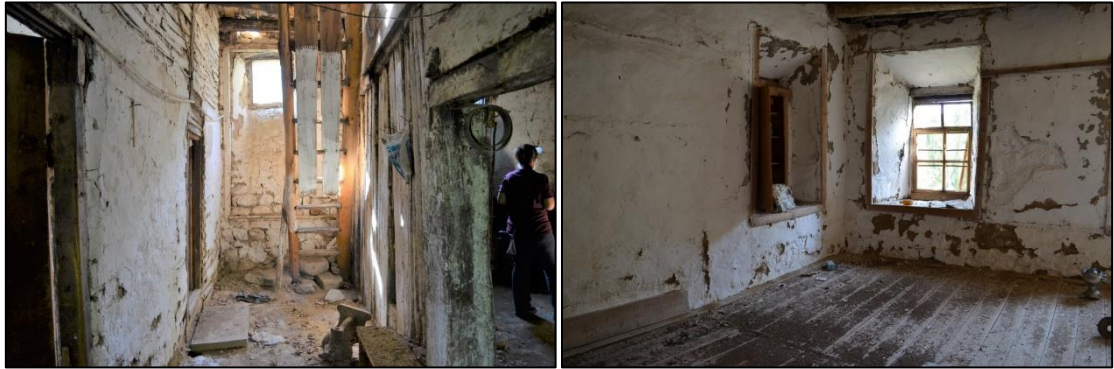
Şekil 128. 32 Nolu kullanılmayan yapı.
