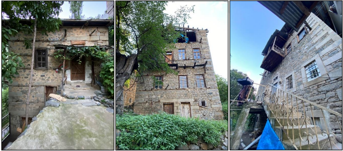
Şekil 92. Sırasıyla, ana girişin doğuda olduğu yapı, bodrum kat kapıları, zeminden yükseltilmiş giriş.
