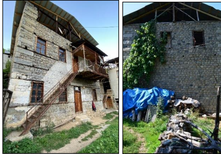
Şekil 90. Sırasıyla, Ahşap hatıllı ve ahşap hatılsız cepheler.
