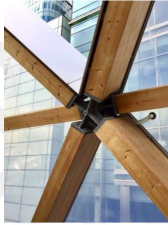
(a) Gerilmesiz IK yapısı için sabit birleşim detayı örneği (Oliveira, Oliveira Pauletti, Meneghetti 2020)
