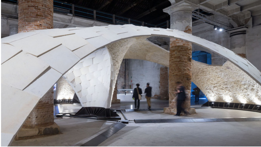
Şekil 2.7 Geleneksel yığma tekniği ile oluşturulan yığma kabuk yapısı (P. Block et al. 2016).
