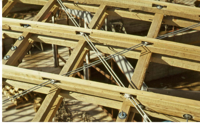
Şekil 2.17 Mannheim Bundesgartenschau’da kayma gerilmesi dayanımı arttırmak için kullanılan diyagonal kablo elemanları (Liddell 2015).
