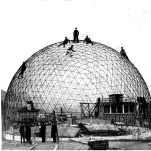
(a) Alamanya'nın Jena kentinde bulunan Zeiss Planetarium yapısının yapım aşaması (Donatılar tamamlandıktan sonra yapı yüzeyine püskürtme beton uygulanmıştır (Cassinello 2013)).
