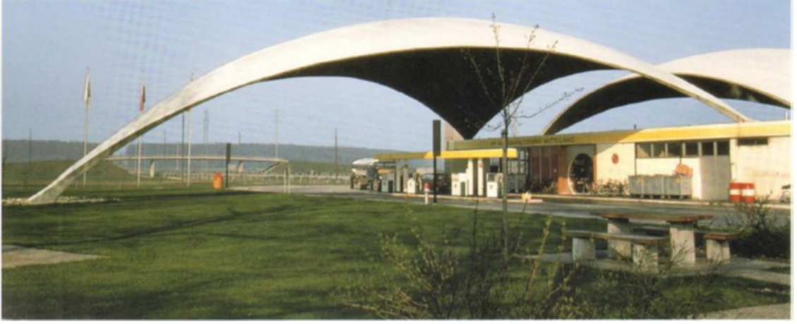
Şekil 2.12 BP benzin istasyonu için Almanya’da tasarlanan ikiz İK yapısı, Heinz Isler, Almanya, 1968
