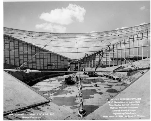
(b) Üretim aşamasında gerilen kablo ızgara sistemi (Watson 2010).
