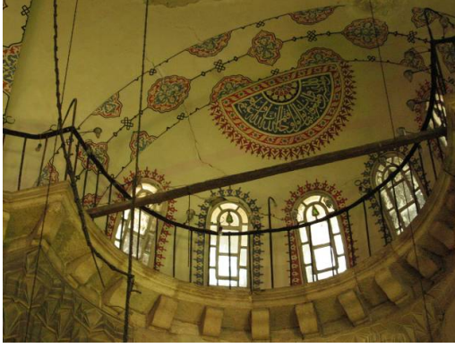
(a) Cami yapısında demir gergi elemanı kullanımı (Celik, Sesigur, Cili 2010).
