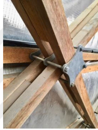
(b) Gerilmeli IK yapısı için hareketli birleşim detayı örneği (Oliveira, Oliveira Pauletti, Meneghetti 2020)
