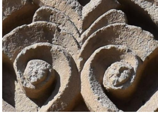
Çizim 2. 92. Kuzeydoğu Cephe, İnsan Maskaları.
