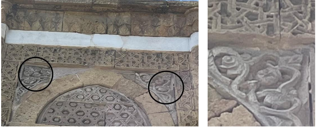
Resim 2. 293a, 2. 293b. Güneydoğu Cephe, İnsan Maskları.
