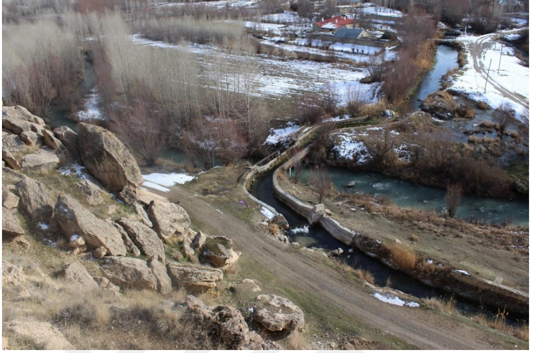
Resim 3: Minua (Şamram) Kanalı'nın başlangıç noktası (kaynak suyunun Engil [Hoşap] Çayı üzerinden geçtiği alan- Aşağıkaymaz Mahallesi [Mejingir])
