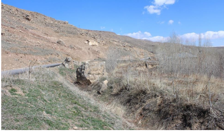
Resim 42: Kanal içersine yuvarlanan kayalar
