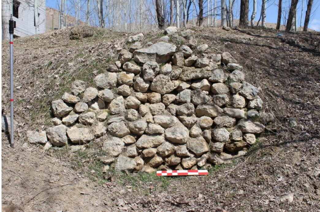
Resim 20: Ortaçağ istinat duvarı (Köprüler [Gem] Mahallesi)
