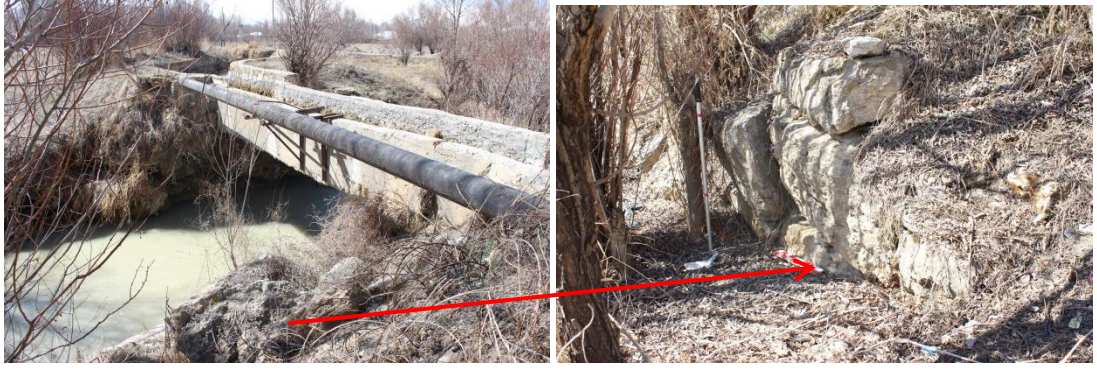
Şekil 15: Kanallın Engil (Hoşap) Çayı üzerinden geçtiği kısım ve köprü kaidelerini oluşturan bloklar
