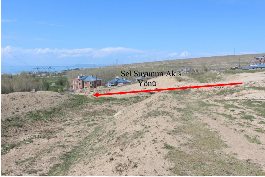
Resim 39: Su baskınlarında kanalın beden duvarlarının görünümü
