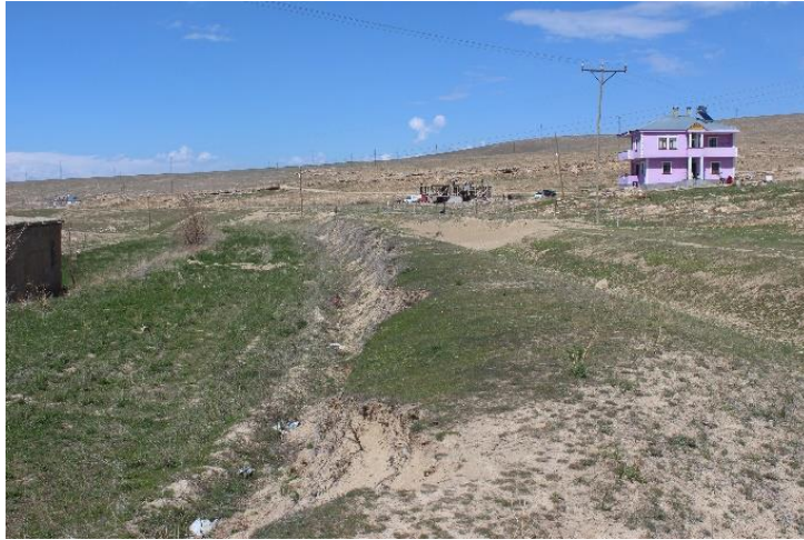
Resim 43: Üst: Kanal içersinde genişletme çalışmaları sonucu oluşan tahribat. Alt: Kanalın dış eğiminde oluşan tıraşlama tahribatı
