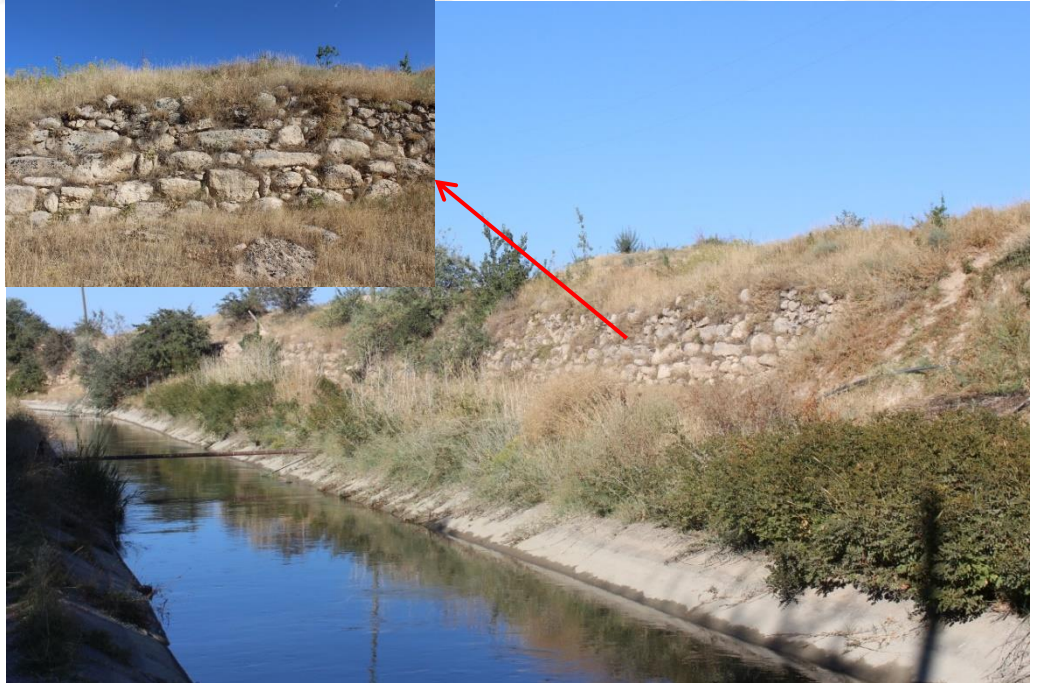
Resim 19: İkinci grup istinat duvarı örneği (Kıyıcak [Suvartan])
