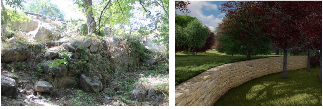
Şekil 40: Sol: Seyir terası oluşturmak için inşa edilen istinat duvarları. Sağ: İstinat duvarı ve seyir terasını yeniden ayağa kaldırma önerisi
