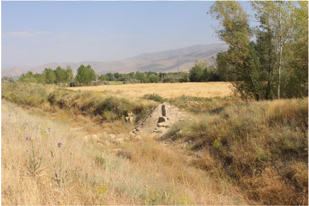
Resim 47: Kanal içi modern set uygulaması
