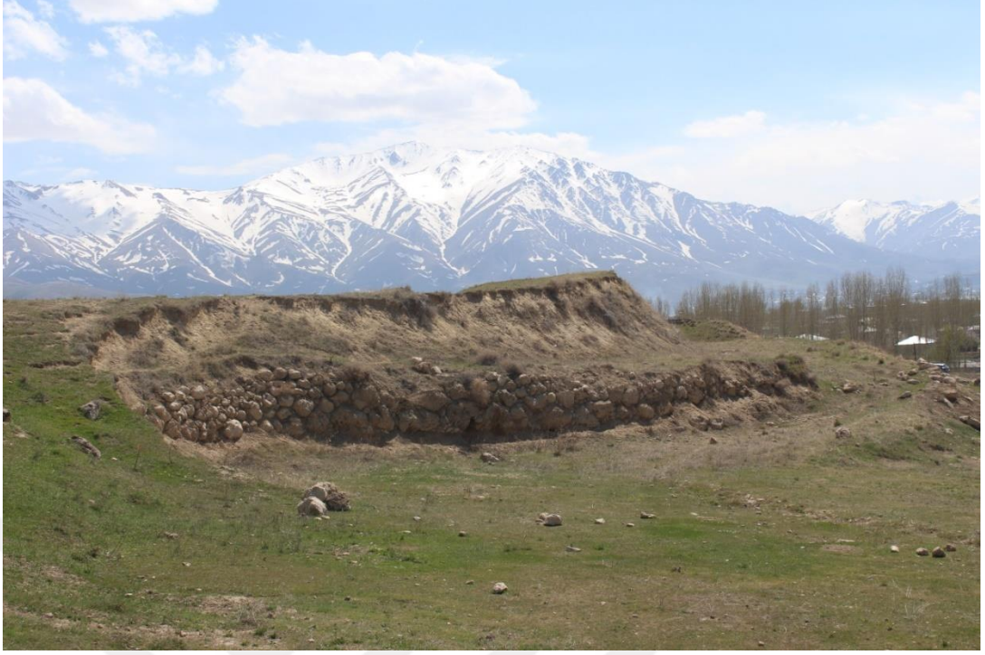
Resim 17: Dördüncü istinat duvarı alanından görünüm
