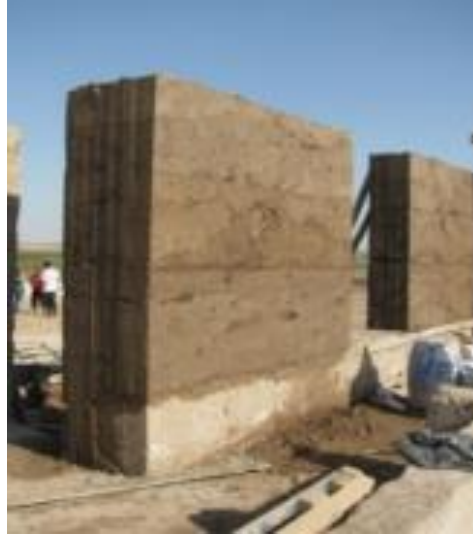
Resim 48: Şanlıurfa’da alkerden yapılan bir duvarın görünümü (Kafescioğlu, 1982: 25, Şekil 20)
