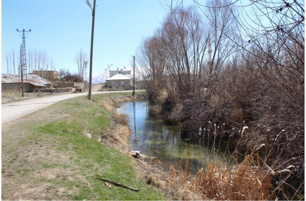
Resim 4: Kanalin Arkboyu (Gelbelesan) Mahallesi'nden geçişi
