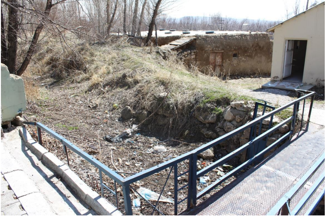
Resim 6: Kanalı Çayırbaşı (Kerevanis) Mahallesi'nden bir görünümü
