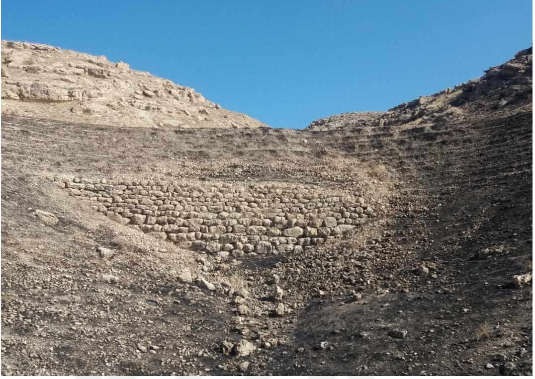
Resim 15: Tek parçadan oluşan ikinci masif istinat duvarı
