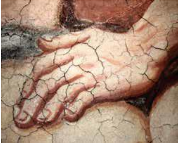
Resim 4.8. Kılcal çatlak görünümü (Bensa vd.,2012:205)
