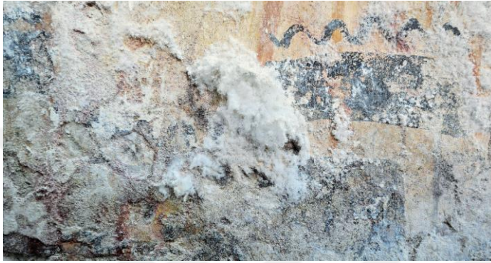
Resim 4.9. Tuz çiçeklenmesi (Weyer,2015:226)
