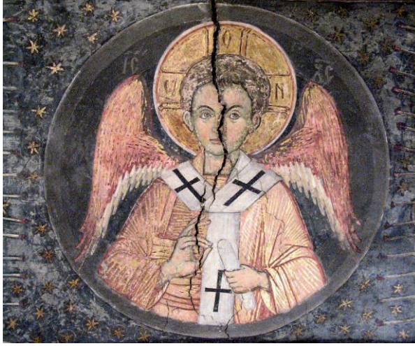
Resim 4.7. Statik çatlak görünümü (Weyer,2015:204)
