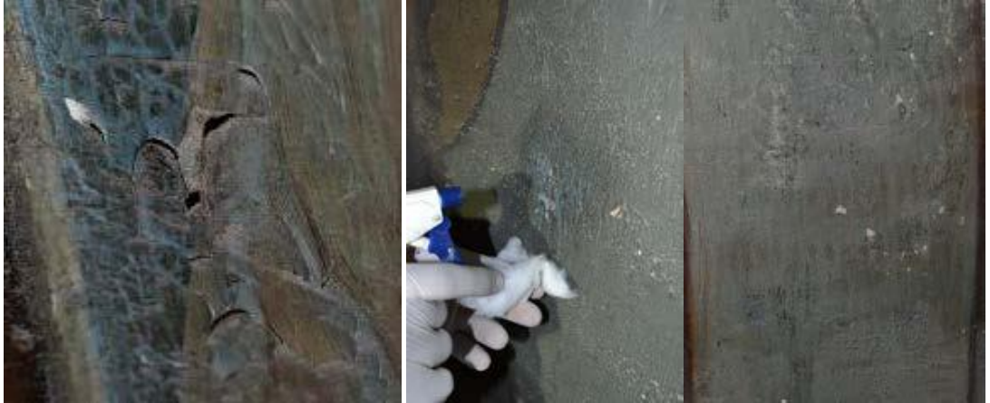
Resim 5.12. Primal AC kullanılarak yapılan güçlendirme işlemi (Abd El-Tawab N.,2014:349)
