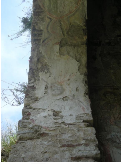
Resim 4.3. Güneş ışığı ve hava akımının neden olduğu bozulmalar (Günözü,2015:108)
