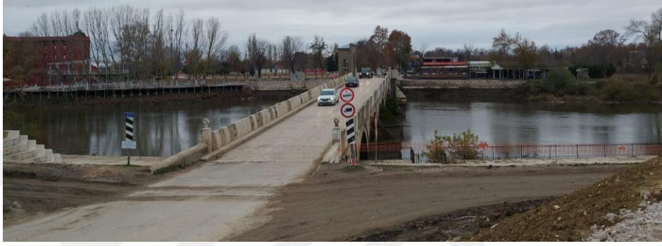
Şekil 5.16. Ekmekçiade Ahmet Paşa Köprüsü (Fotoğraf: Ayşe Saranlı, 2022)
