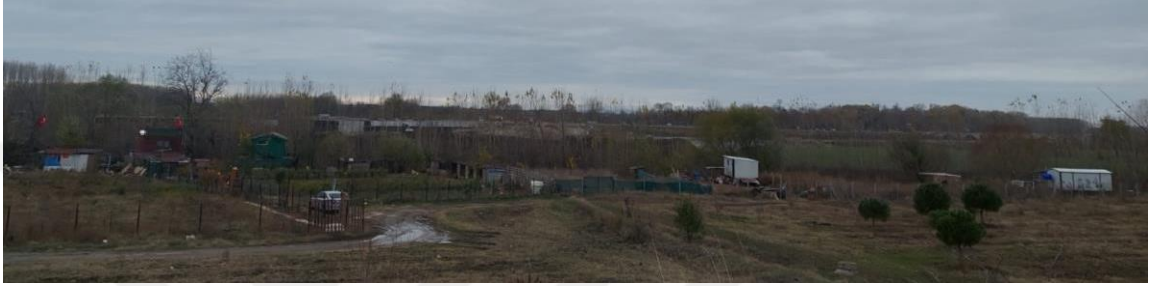
Şekil 5.20. Güney Kıyı Şeridinde Bulunan Yapılar (Fotoğraf: Ayşe Saranlı, 2022)
