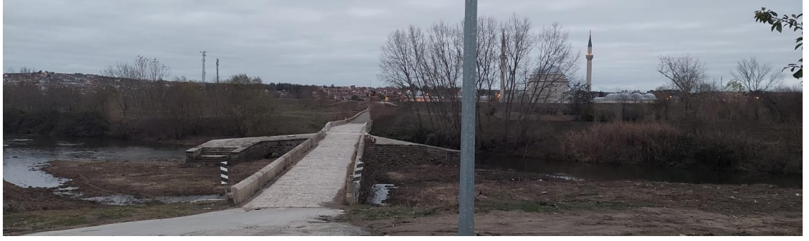
Şekil 5.27. Yalnız Göz Köprüsü Gazimihal-Yeniimaret Bağlantısı (Fotoğraf: Ayşe Saranlı, 2022)
