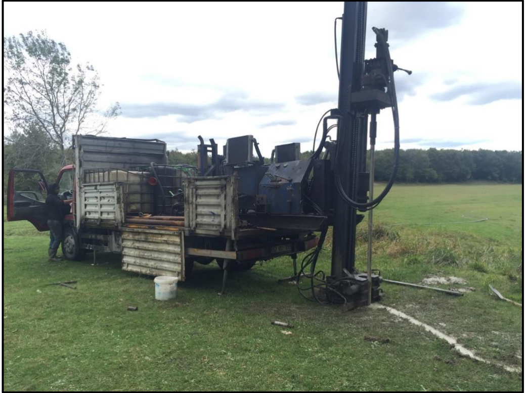
Şekil 3.6. Aks yeri talvegde açılan SK-5 No.lu temel sondaj kuyusu
