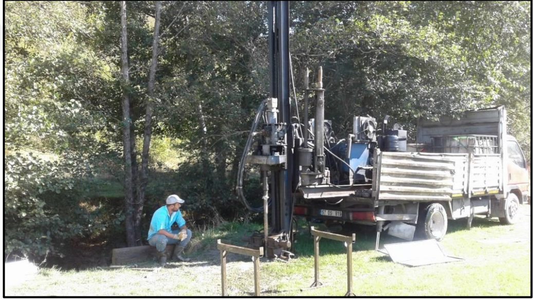
Şekil 3.8. Dolusavak düşü havuzunda açılan DSK-1 No.lu temel sondaj kuyusu
