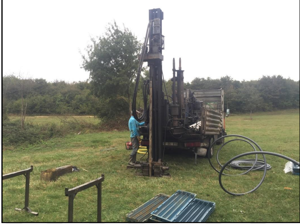
Şekil 3.5. Aks yeri sol sahilde açılan SK-4 No.lu temel sondaj kuyusu
