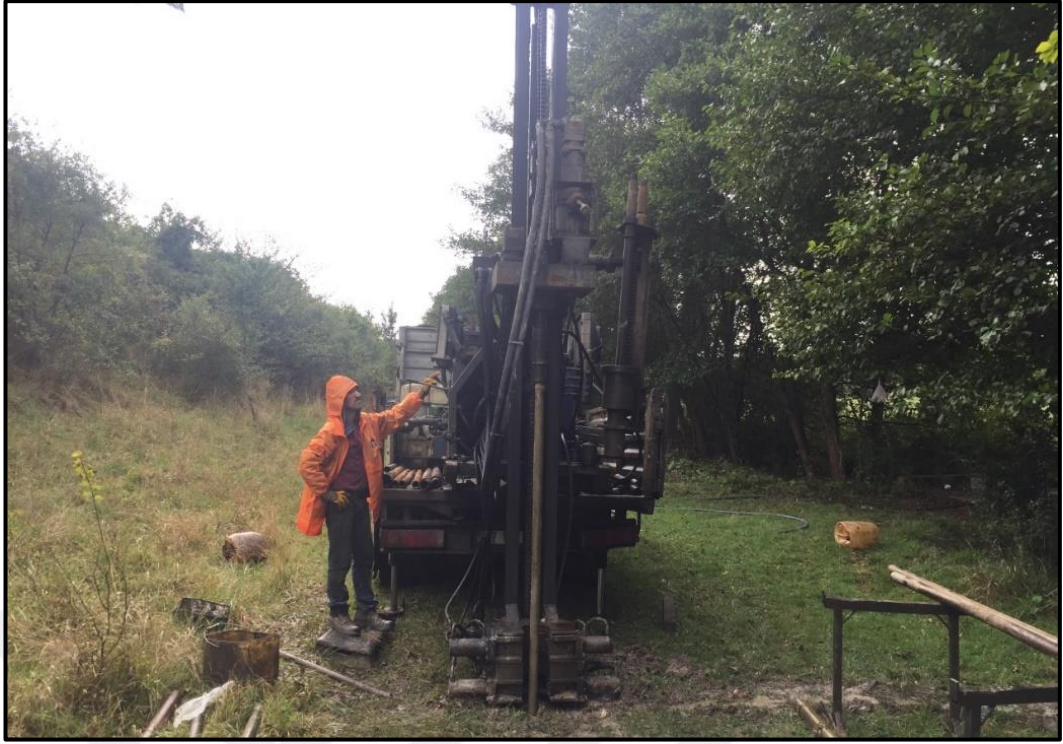
Şekil 3.7. Aks yeri sağ sahilde açılan SK-6 No.lu temel sondaj kuyusu
