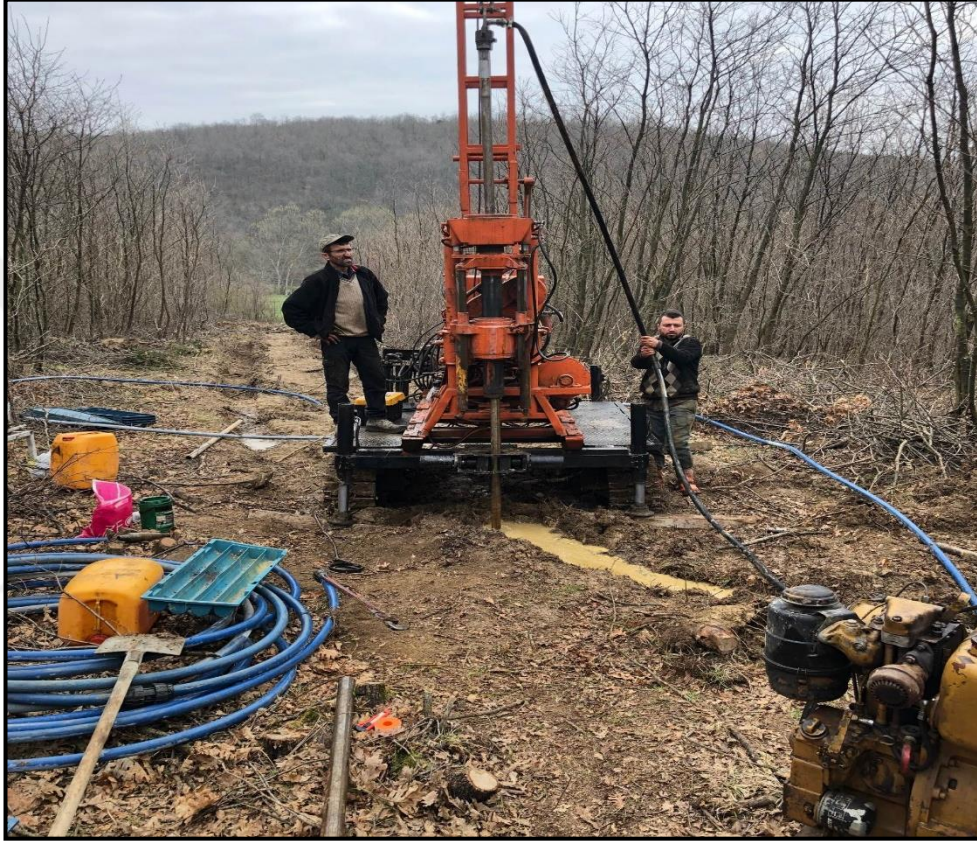
Şekil 3.2. Aks yeri sol sahilde açılan SK-1 no.lu temel sondaj kuyusu
