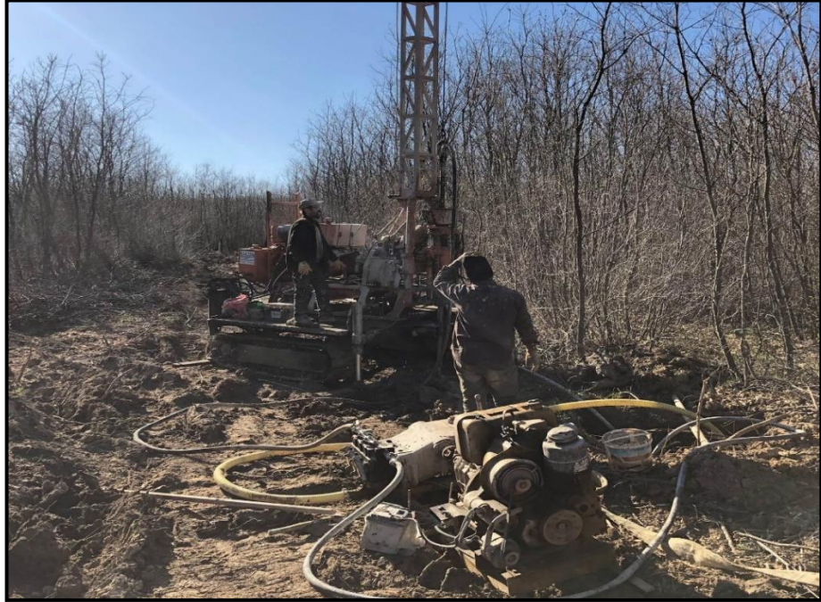
Şekil 3.3. Aks yeri sol sahilde açılan SK-2 No.lu temel sondaj kuyusu
