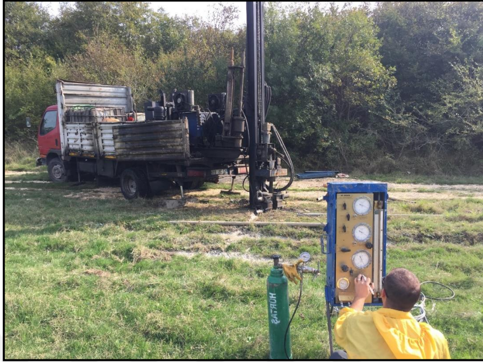
Şekil 3.4. Aks yeri sol sahilde açılan SK-3 No.lu temel sondaj kuyusu
