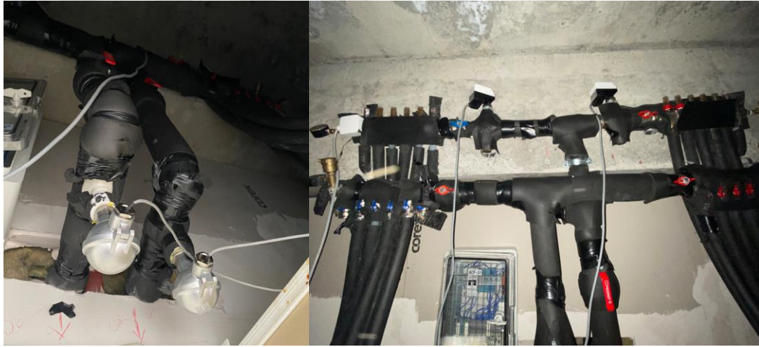
Şekil 2.15 Asma tavanda yer alan kollektör grubu görünümü.
