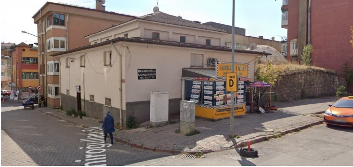
Şekil 4.30. Sivas Hamamcıoğlu Hamamı Restorasyon Sonrası (Google Maps, 2019)
