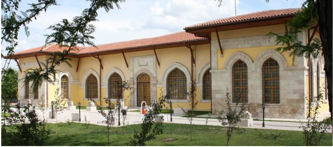
Şekil 5.41. Sivas Sanayi Mektebi Demir Atölyesi, Batı Cephesi (Sivas İl Kültür ve Turizm Müdürlüğü Arşivi)
