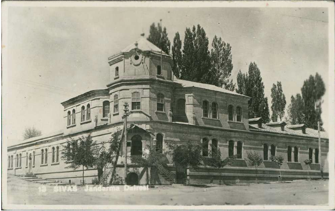
Şekil 5.56. 1941 Yılına Ait Sivas Jandarma Binası Fotoğrafı (İBB, Atatürk Kitaplığı Arşivi)
