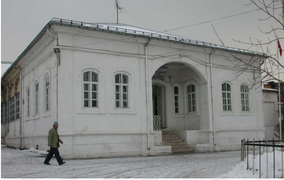
Şekil 5.48. Eski Sivas Açık Cezaevi, Restorasyon Öncesi (Sivas İl Kültür ve Turizm Müdürlüğü)
