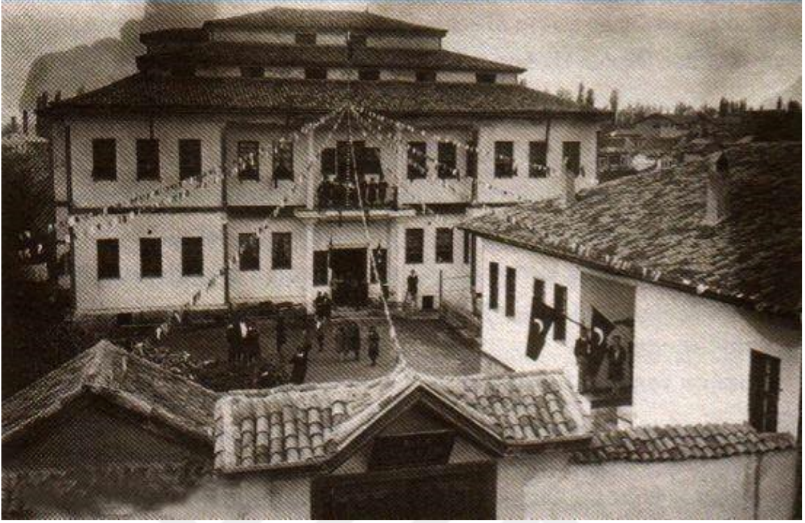
Şekil 5.26. Sivas Aramyan Okulu Giriş Cephesi (Eskitürkiye Arşivi)
