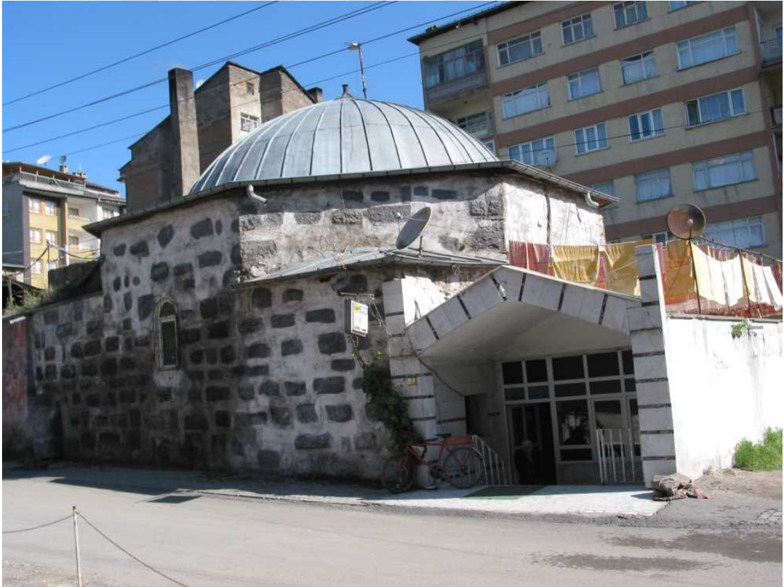
Şekil 5.43. Sivas Eski Paşa Hamamı (Sivas İl Kültür ve Turizm Müdürlüğü Arşivi)
