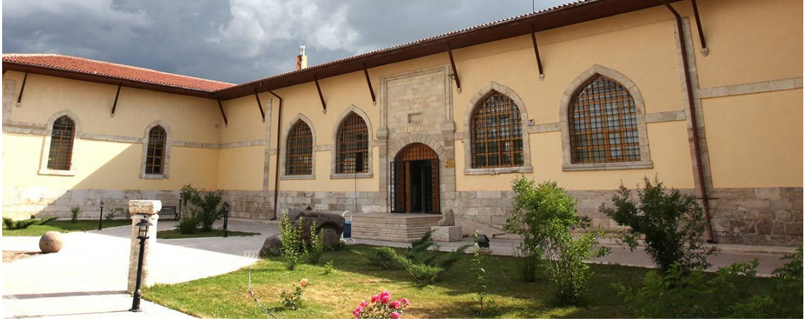
Şekil 5.42. Sivas Sanayi Mektebi Demir Atölyesi, Doğu Cephesi (Sivas İl Kültür ve Turizm Müdürlüğü Arşivi)
