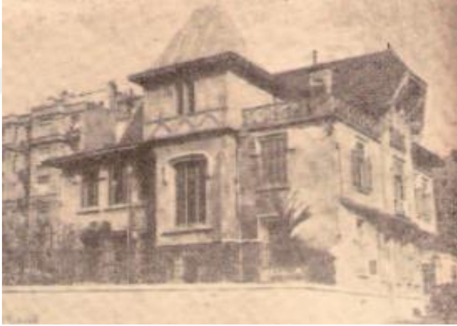
Şekil 3.8. İstanbul, Hayvanları Koruma Derneğinin Merkez Binası ve Hayvan Hastanesi 315
