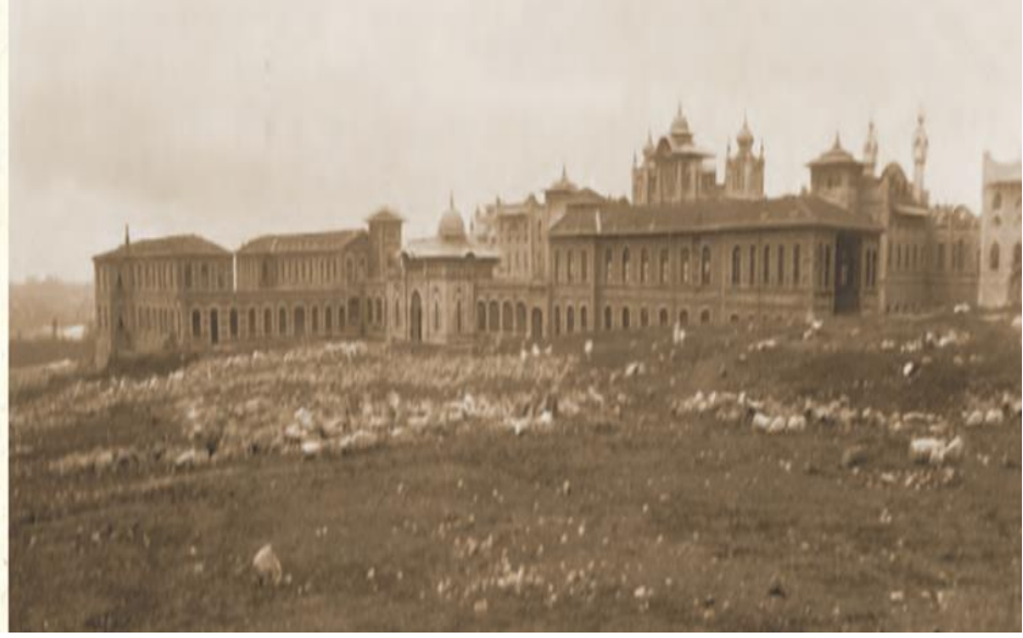
Şekil 2.3. Mekteb-i Tıbbiyye-i Şahanenin Bahçesinde 1893 Yılında İnşa Edilen Kuduz Tedavi Binası (Seriyyât Hariciyesi Binalardan Biri) 182
