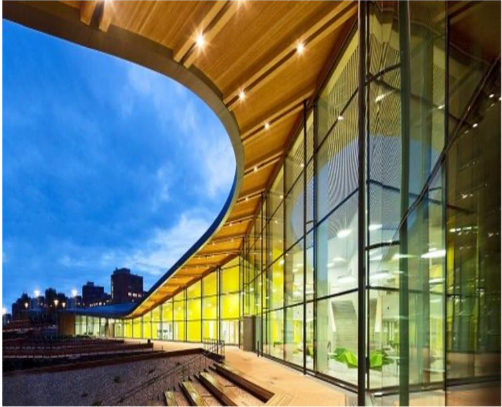
Şekil 3.3. Finlandiya Okul Binası Dış Cephe
