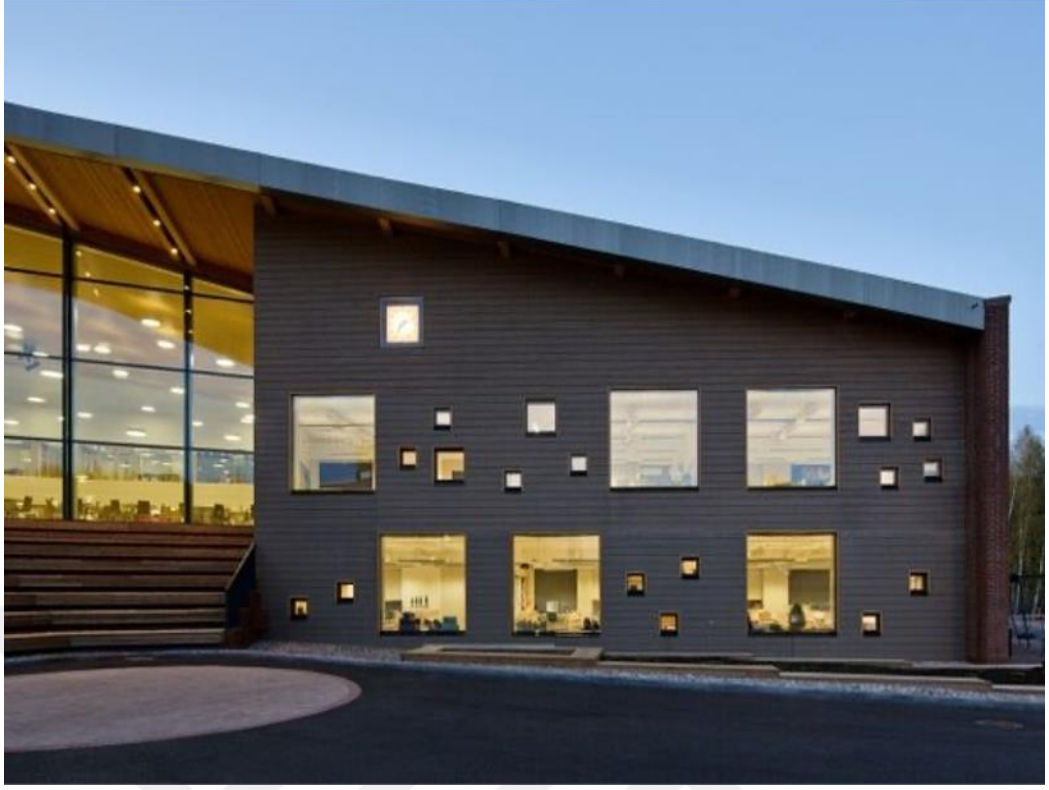
Şekil 3.2. Finlandiya Okul Binası Dış Cephe
