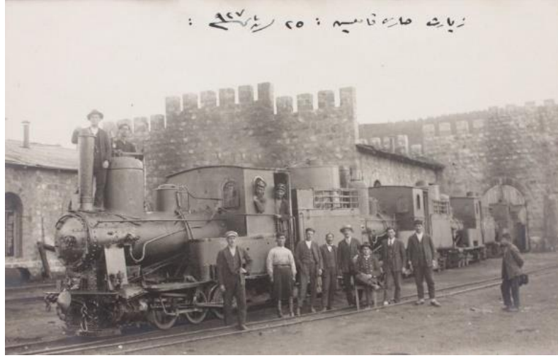
Şekil 6.4. 1925 Yılı Sarıkamış Cer Atölyeleri(Revizörlük Binası) durumu aktif lokomotif ve dekovil hattı (Sönmez, B.Arşivi)
