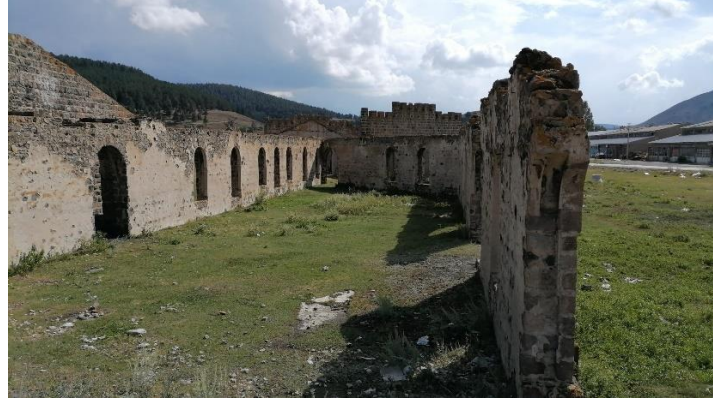
Şekil 6.12.Cephede ve çatıda malzeme kayıpları (Gökdere,2022)
