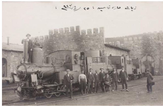
Şekil 6.38. 1925 Yılı Sarıkamış Cer Atölyeleri(Revizörlük Binası) (Sönmez, B.Arşivi)
