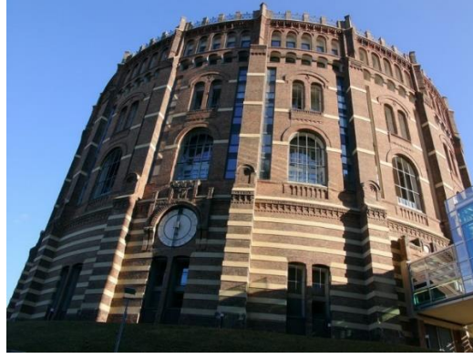
Şekil 3.4. Gazometrelerin restorasyon sonrası cephesi(Gazometre C) (Wehdorn, 2002)
