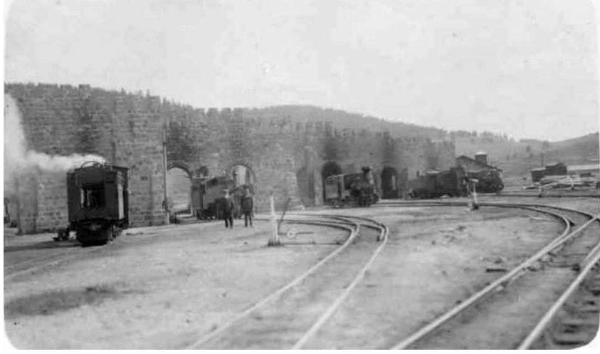
Şekil 6.39. 1925 Yılı Sarıkamış Cer Atölyeleri(Revizörlük Binası) (Sönmez, B.Arşivi)
