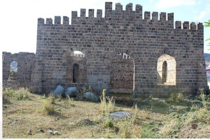
44 Şekil 6.6. Güneydoğu cephe (Gökdere, 2022)
