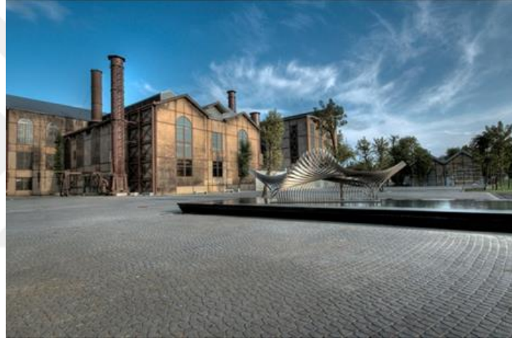
Şekil 3.19. Restorasyon sonrası görünüm (Santralistanbul, 2022)
