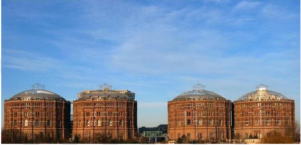
Şekil 3.2 Gazometrelerin restorasyon sonrası görünümü (Mimdap,2006)
