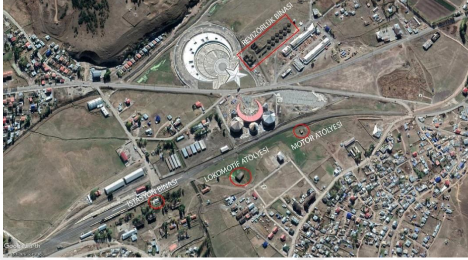
Şekil 6.1.Sarıkamış’da inşa edilen demiryolu yapıları (Google earth,2022)
