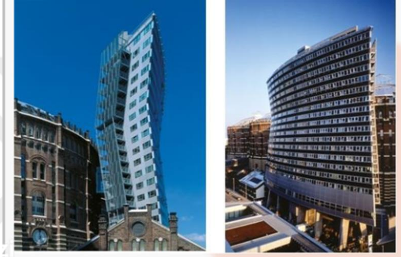
Şekil 3.8. Gazometrelerin restorasyon sonrası cephesi (Wehdorn, 2002)
