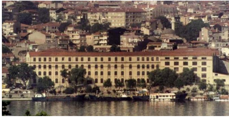
Şekil 3.25. Cibali Tütün ve Sigara Fabrikası(Tures,2022)
