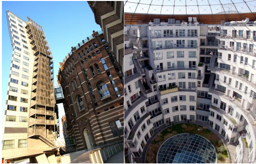
Şekil 3.6. Gazometrelerin konut olarak işlevlendirilen (C Blok) bölümü (Wehdorn, 2002)
