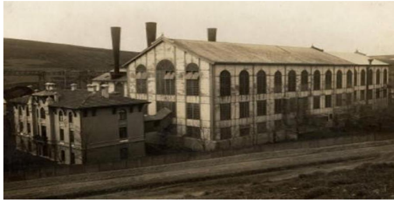
Şekil 3.17. Restorasyon öncesi fabrika (Teknisite, 2021)
