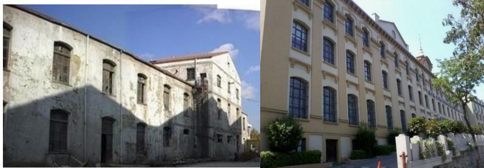
Şekil 3.28. Cibali Tütün Fabrikasının restorasyon öncesi ve sonrası görünümü (Wikipedia, 2013)
