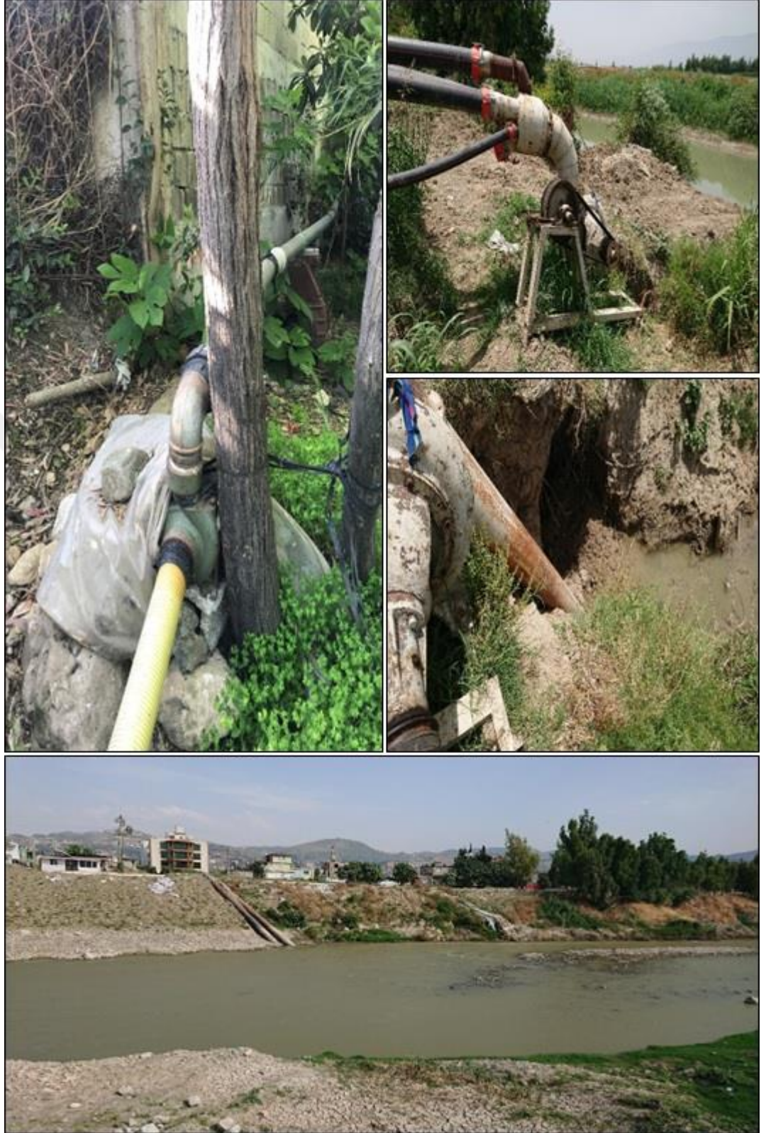
Şekil 4.3. Asi Nehri’nden tarım arazilerine su transferi için kurulan bazı sistemler.
