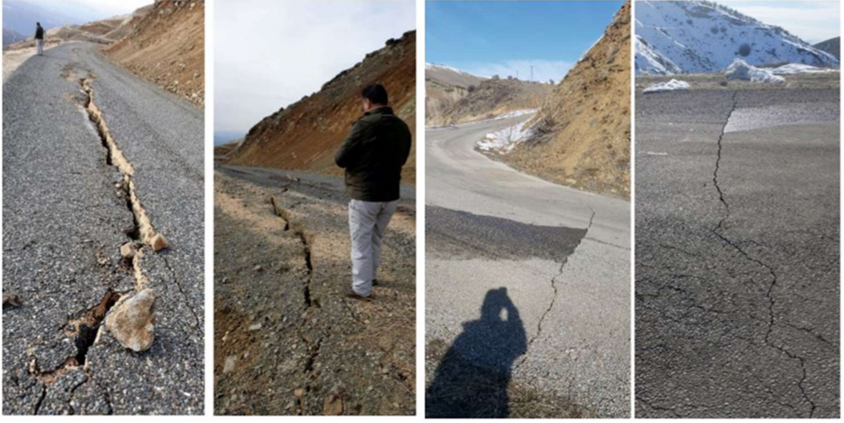
Şekil 4.21. Deprem sırasında Sivrice İlçesini Doğanbağı köyüne bağlayan yollar üzerinde meydana gelen sismo-gravitasyonel yüzey-kırık deformasyon yapıları (Tatar ve diğ., 2020).
