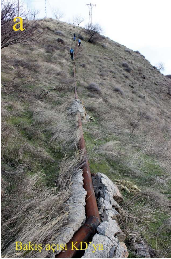
Şekil 4.14. Yüzey deformasyonlarının gözlendiği (B) kısmında Şekil 4.11.'de harita üzerinde a) ile gösterilen bölgede deprem sırasında etkilenen su borusu (Koldere köyü).
