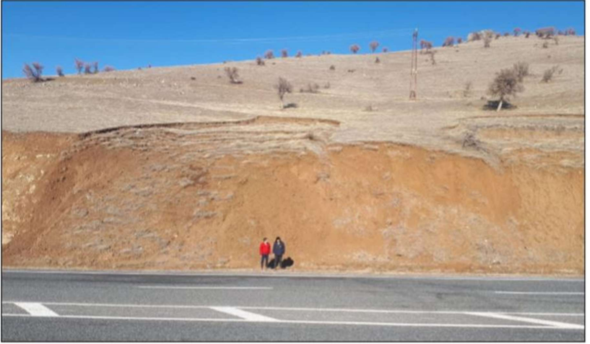
Şekil 4.24. Ocak 2020 Sivrice (Elazığ) Depreminde Hazar Gölü kuzey, kuzey batısında Gezin ilçesini Sivrice ilçesine bağlayan karayolunun kuzey, kuzey batı yamaçlarında meydana gelen dairesel kaymalar (Kuzey, kuzey batıya bakış) (Kürçer ve diğ., 2020).
