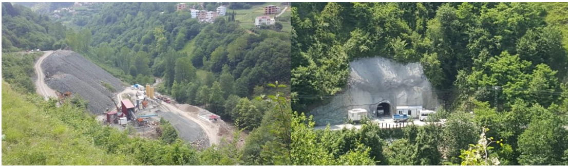
Şekil 104. S6-S5 örnek noktaları arasında bulunan kum ocağı ve tünel çalışması
