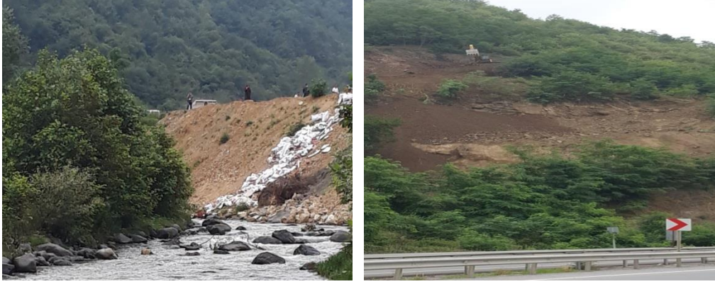
Şekil 105. S3-S4 örnek noktaları arasında bulunan hafriyatın döküldüğü yer ve yol yapım çalışması
