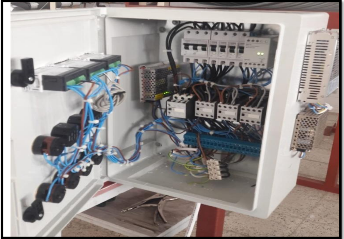
Şekil 26. Deney düzeneği kontrol ve elektrik panosu
