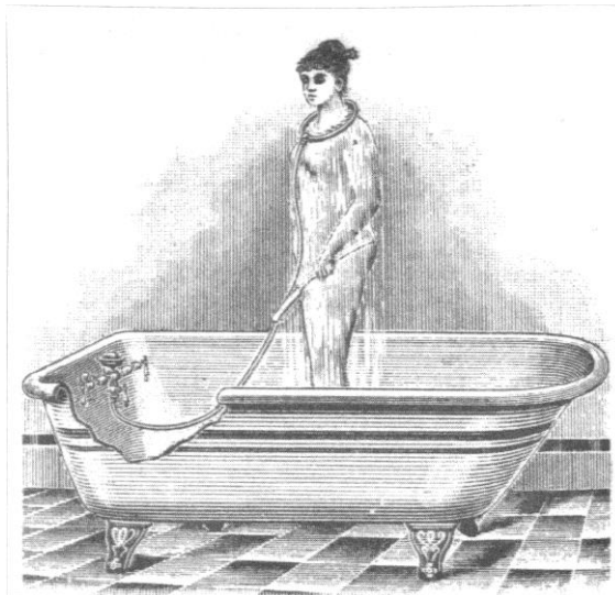
Şekil 3.8. Akan su etkisinin kullanıldığı duş halkası çalışması, 1895 (Talu, 2012)
