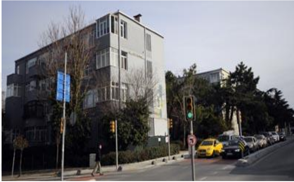
Şekil 4.17. 4. Levent mahallesi evleri - 1956 (Dergipark, 2012)
