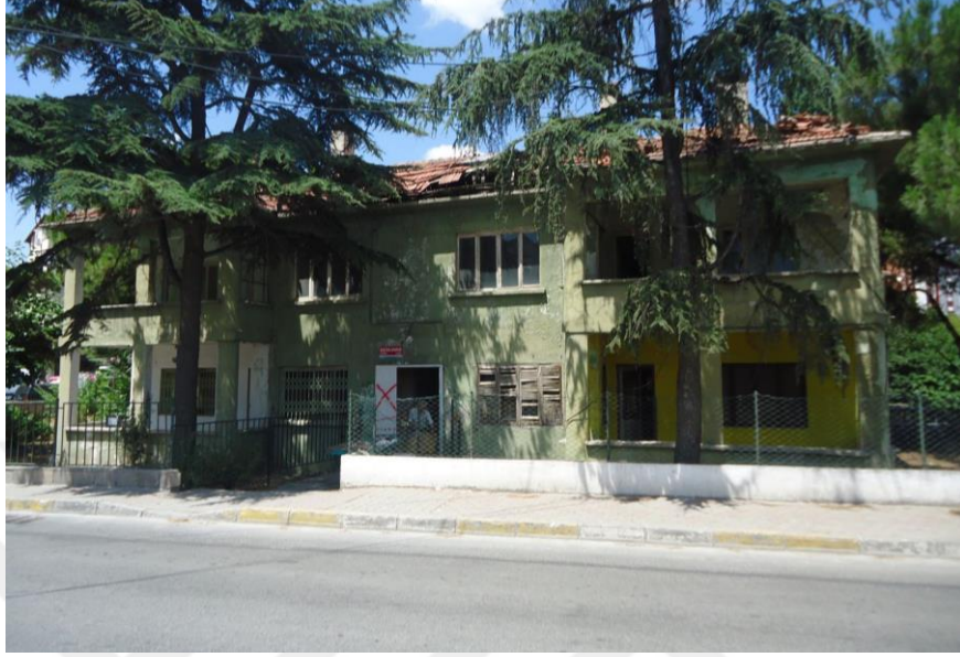
Şekil 5.31. 702/89 ada parsel 2 katlı eski yapı (K.B.F.A.)
