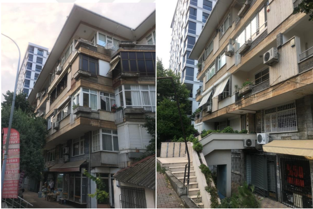
Şekil 5.20. 665 / 19 ada parsel Divan Palas apartmanı (Özbilgiç, 2021)
