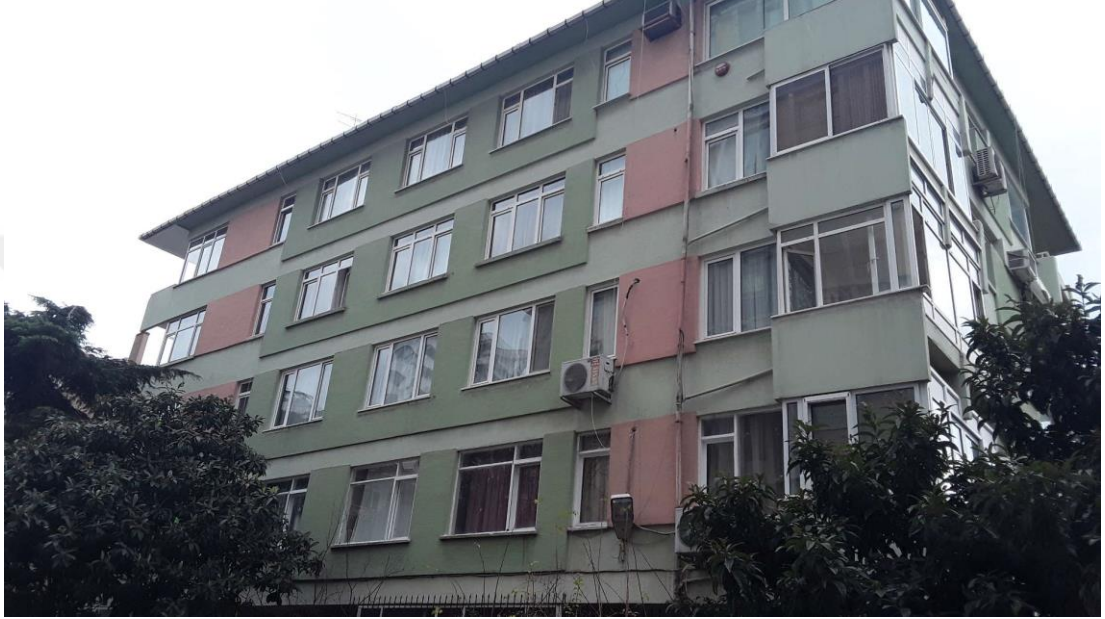
Şekil 5.28. 674 / 2 ada parsel 5 katlı Bora apartmanı
