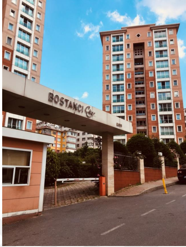
Şekil 5.33. 3225 / 141 ada parsel Bostancı City kapalı site A.22
