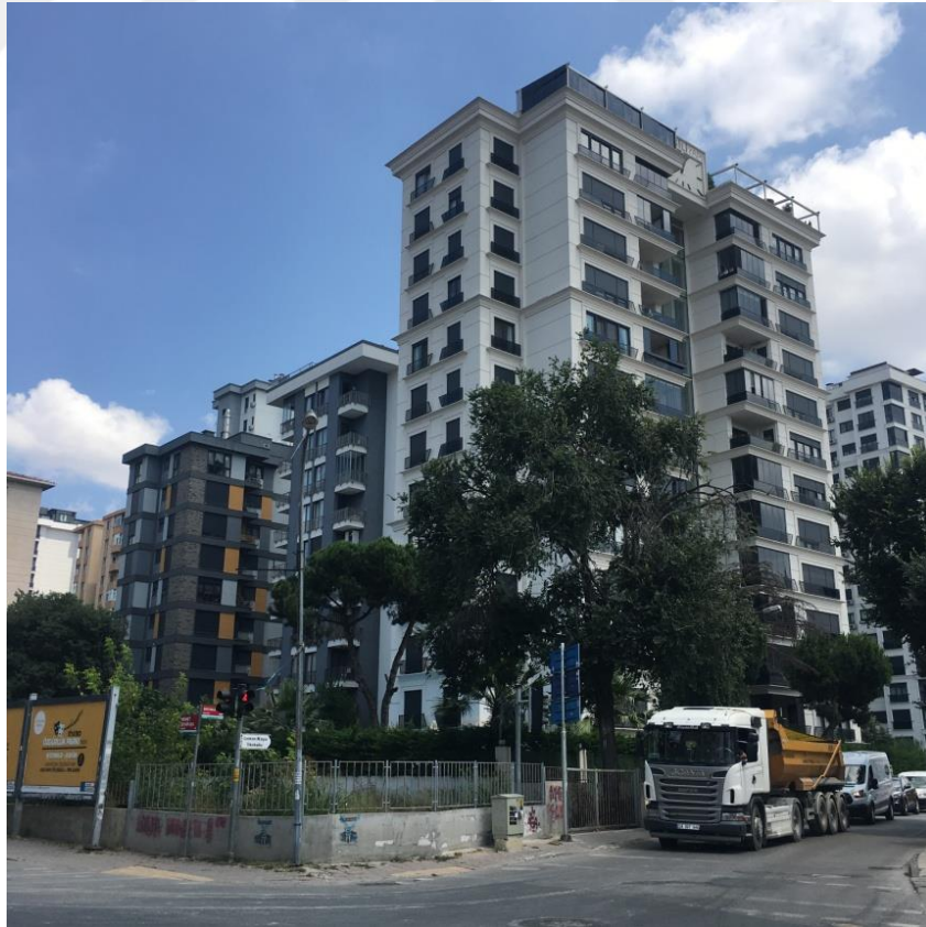
Şekil 5.32. 702/89 ada parsel 14 katlı yeni yapı
