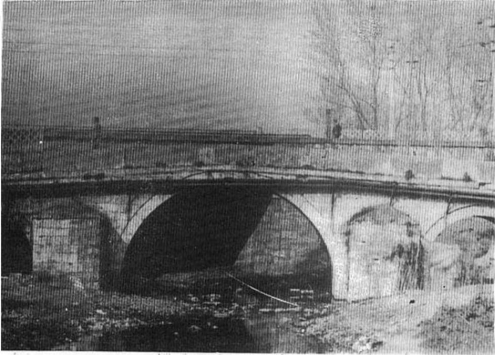
Şekil 4.29. Derbent Köprüsü - Bostancı, 1524 (Arkitekt, 1973)
