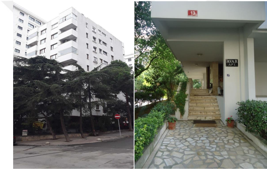
Şekil 5.26. 675/13 ada parsel 8 katlı Avar apartmanı
