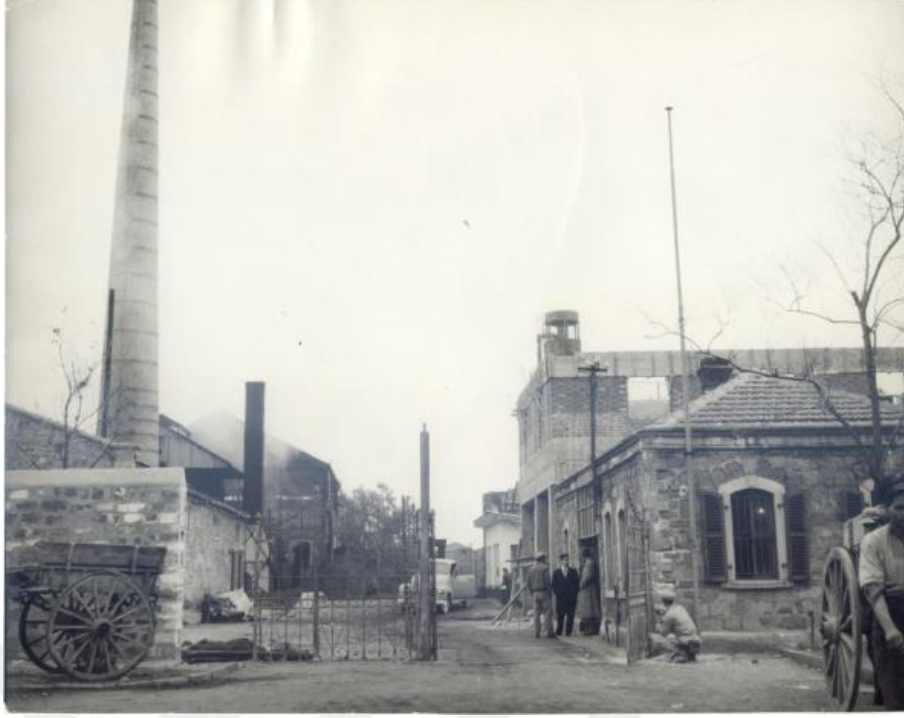
Şekil 5.17 İzmir Havagazı Fabrikası (Eski) (Şimşek, 2006)
