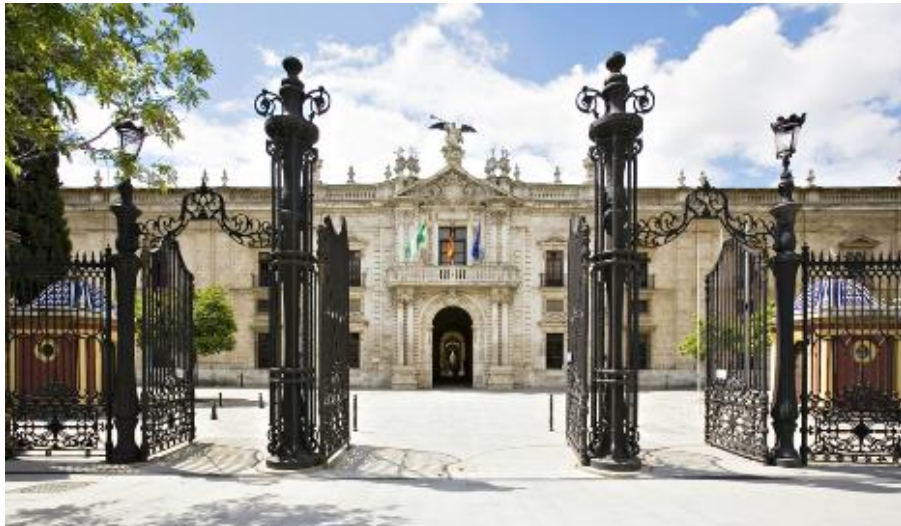
Şekil 3.20 Sevilla Üniversitesi günümüz görünümü (Fábrica de Tabacos de Sevilla)
