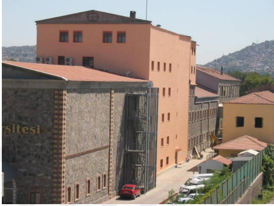
Şekil 5.11 Eski Un Fabrikası 1 (Şimşek, 2006)
