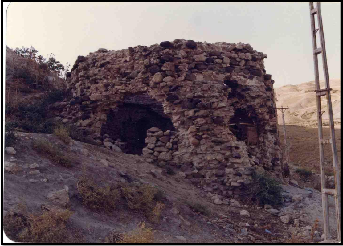
Foto 223. Kindik Hamamı sıcaklık kısmı yıkılmadan önce VGMA-1990'lı yıllar)
