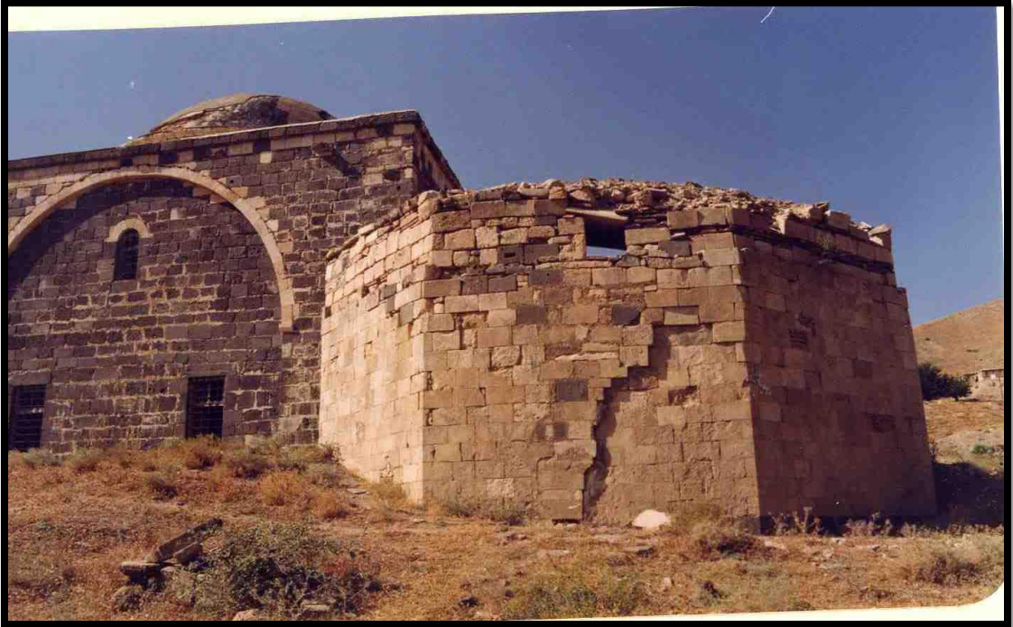
Foto 186. Cemşid Bey Türbesi güney cephe (VGMA-1992)
