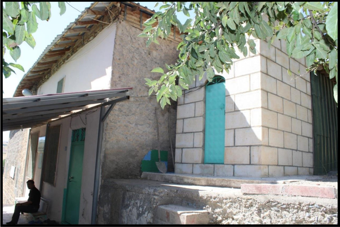
Foto 148. Seydili Köyü Tekkesi Doğu Cephe Muhdes Ek ve Minare
