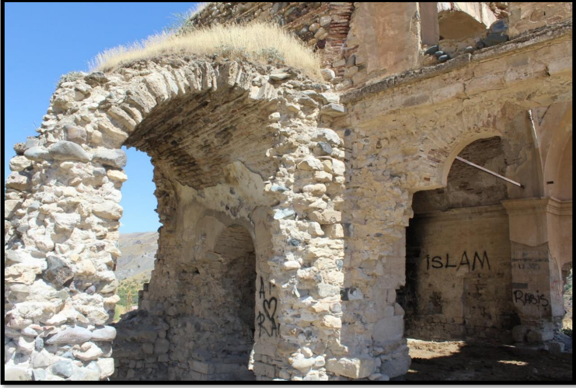
Foto 171. Surp Lusavoriç Kilisesi vaftiz odası
