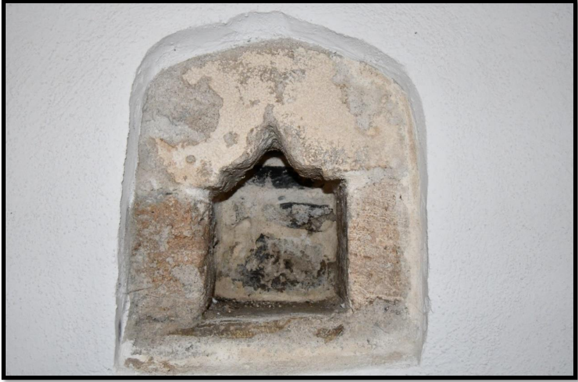
Foto 15. Ulu Cami doęu duvarındaki sadaka/kayıp niři
