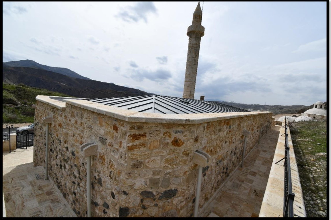
Foto 4. Kuzeydoğu köşeden, doğu ve kuzey cepheler
