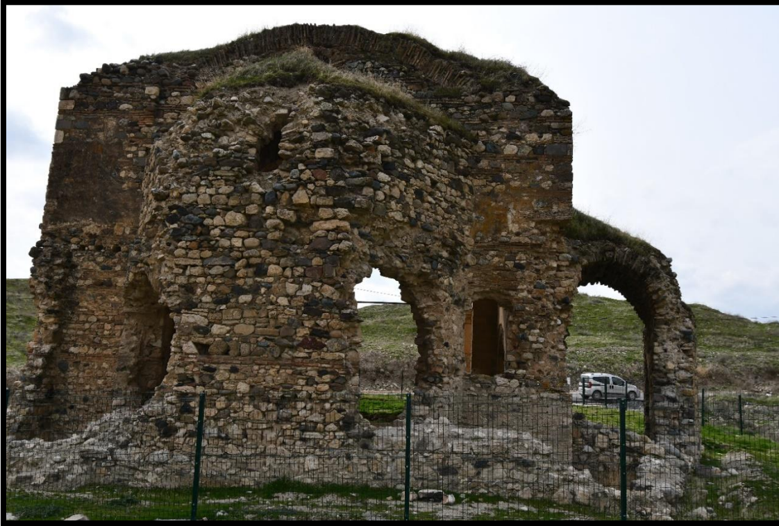
Foto 166 Surp Lusavoriç Kilisesi doęu cephesi
