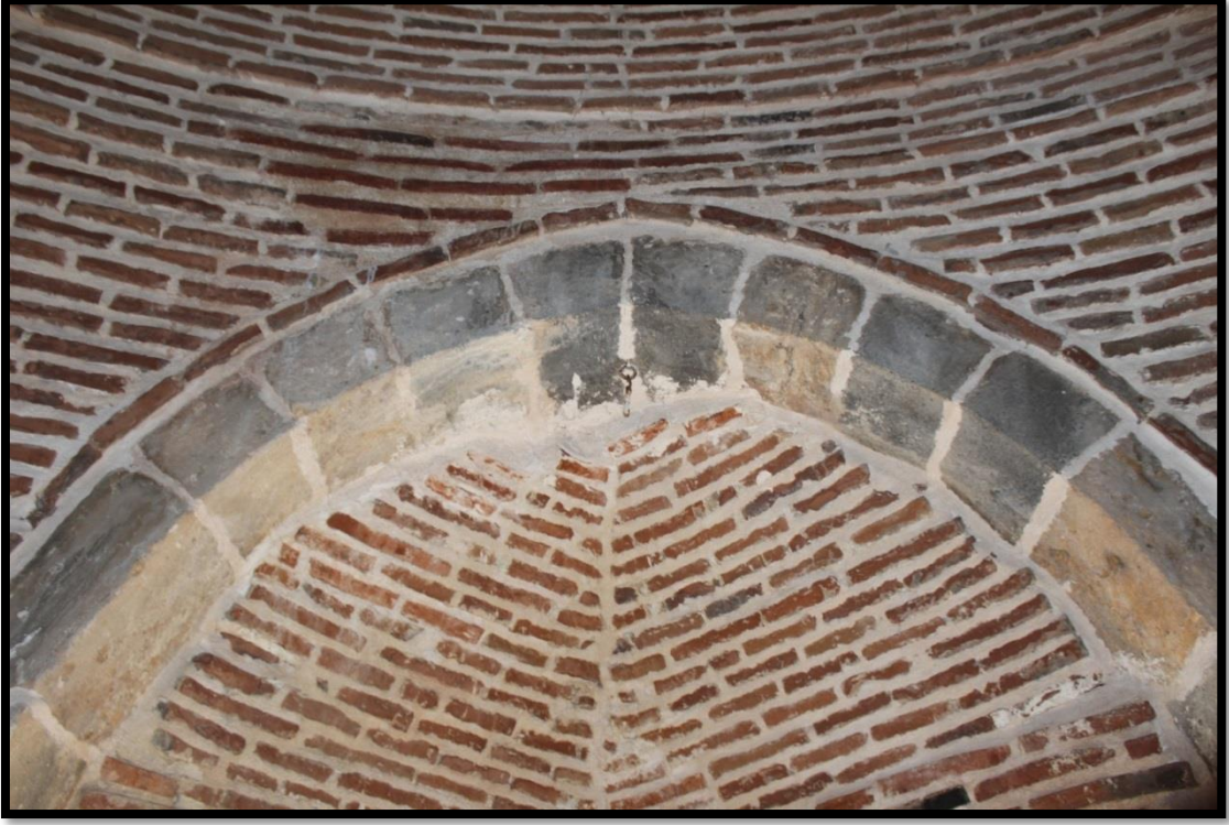
Foto 135. Alacalı Tekke Tervhidhanede Taş ve Tuğlanın Kullanımı
