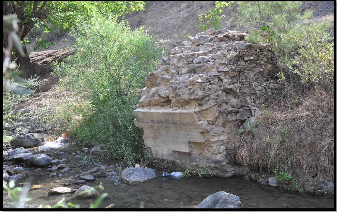
Foto 239. Teke Deresi Köprüsü batı mesnedi
