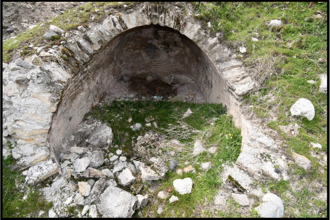
Foto 257. Anonim Yapı yıkılan doğu tarafı
