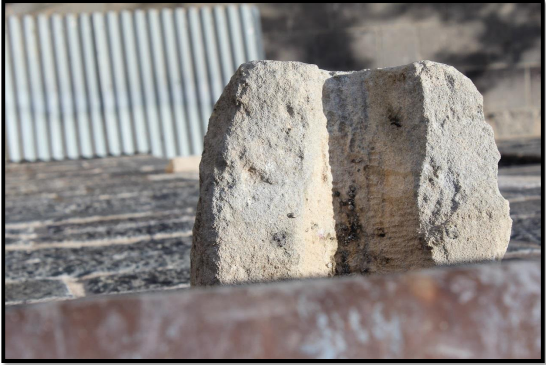
Foto 55. Cemşid Bey Cami Güney Cephe Saçak Altı Çörtenler
