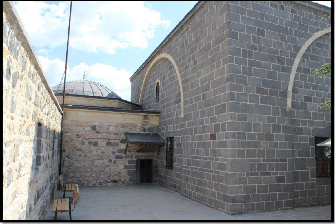
Foto 53. Cemşid Bey Cami doğu cephesi
