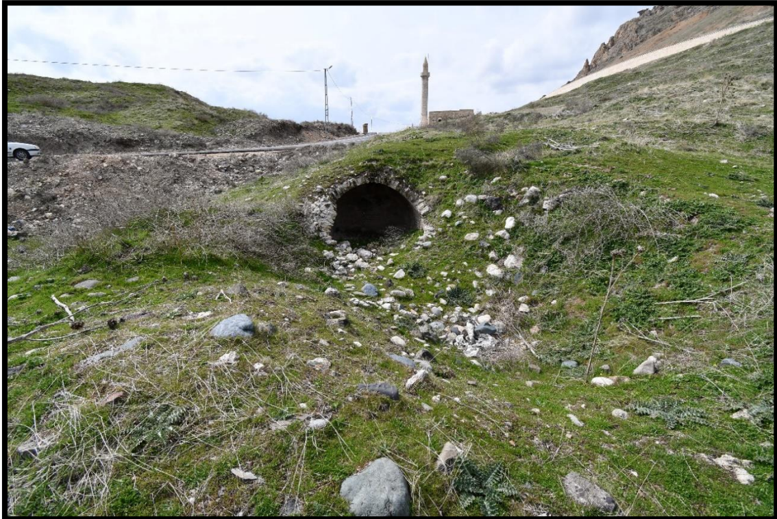
Foto 255. Anonim Yapı doğu yönünden bakış
