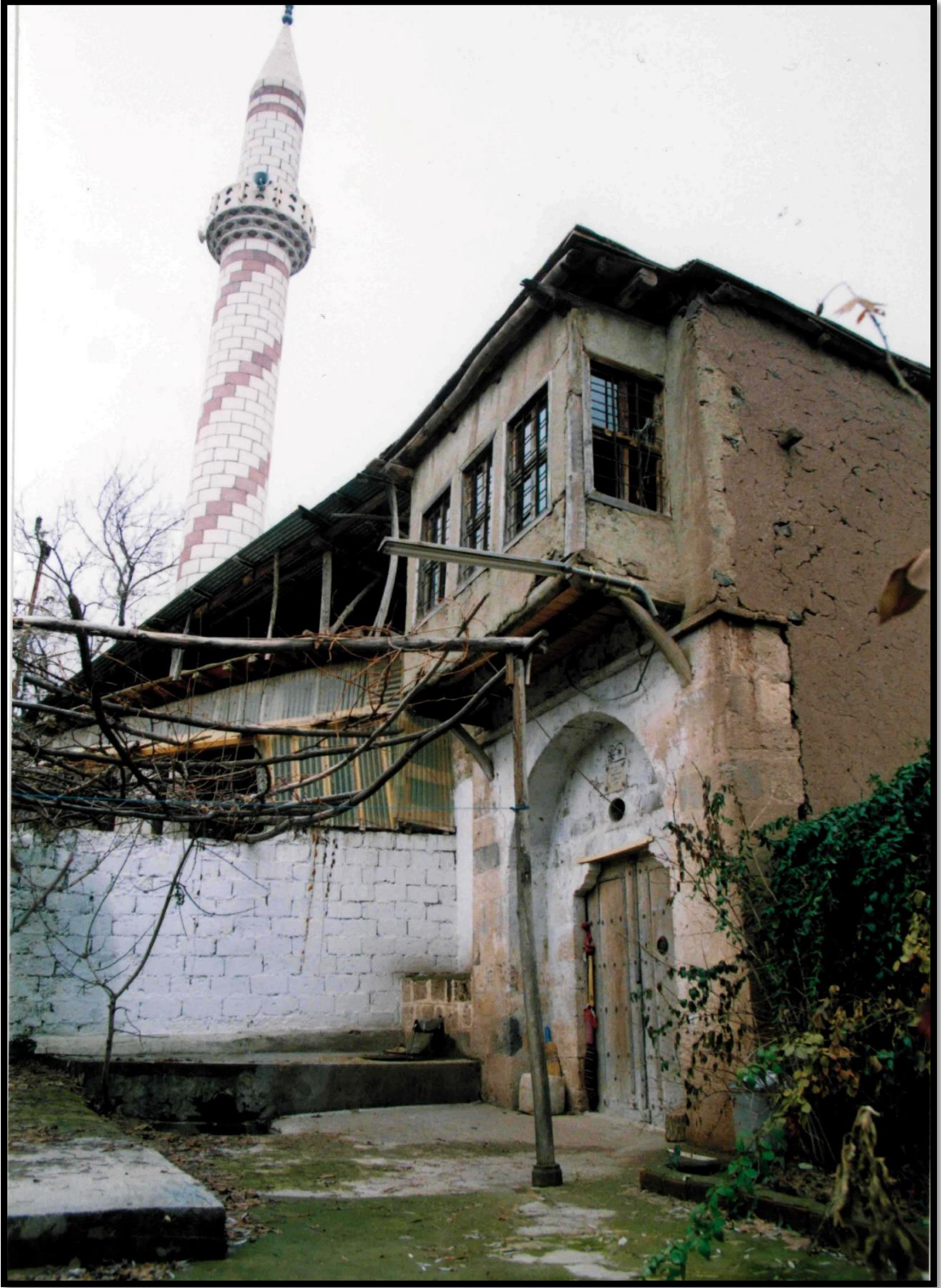
Foto 245. M. Samini Evi kuzeydoğu giriş cephesi (2006)
