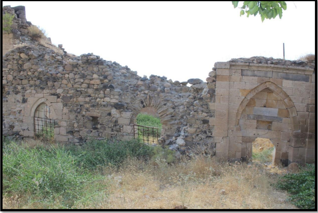
Foto 69. Dükkanönü Cami Doğu Cephe
