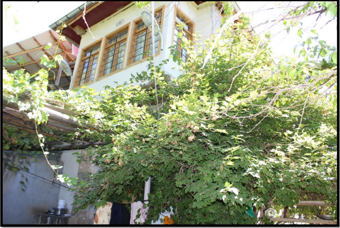
Foto 248. M. Samini Evi kuzeydoğu cephe cumba kısmı
