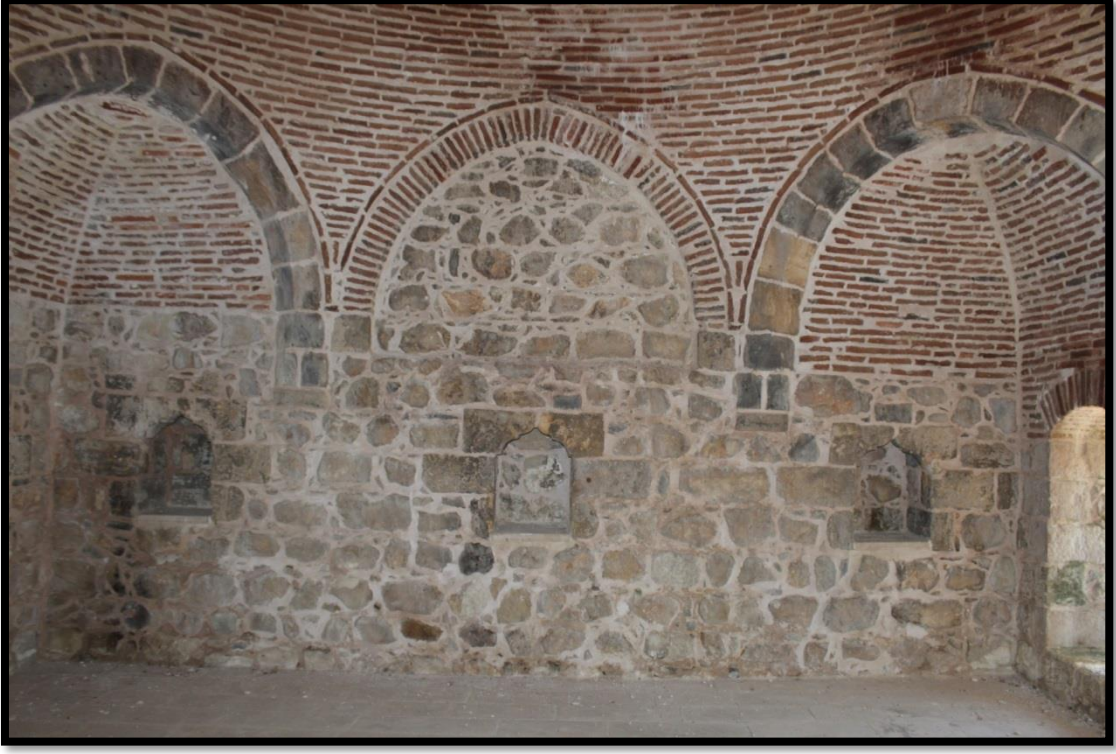
Foto 127. Alacalı Tekke Tevhidhane Doğu Duvarı
