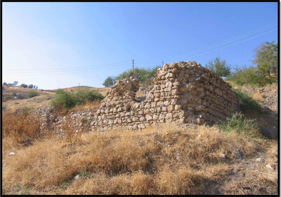
Foto 202. Cemşid Bey Hamamı güneydoğu cephe (2018)
