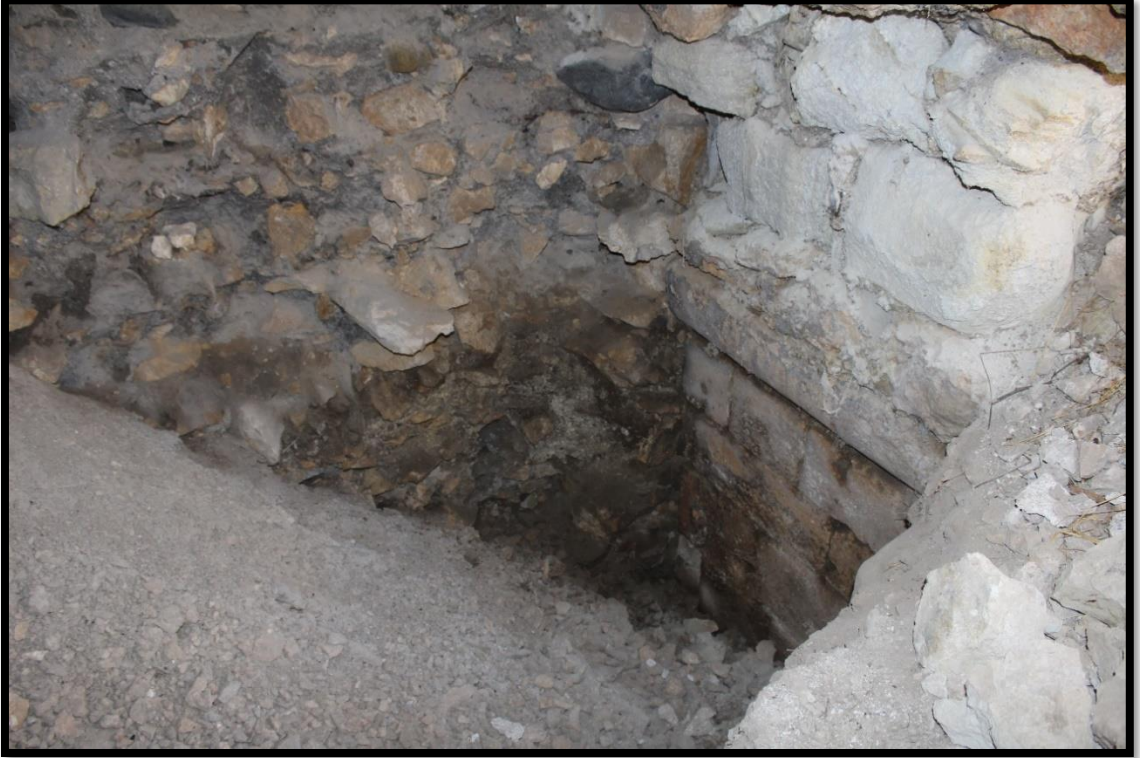
Foto 194. Zincirli Han kalıntının içinden, duvar ve taşıyıcı ayak izleri
