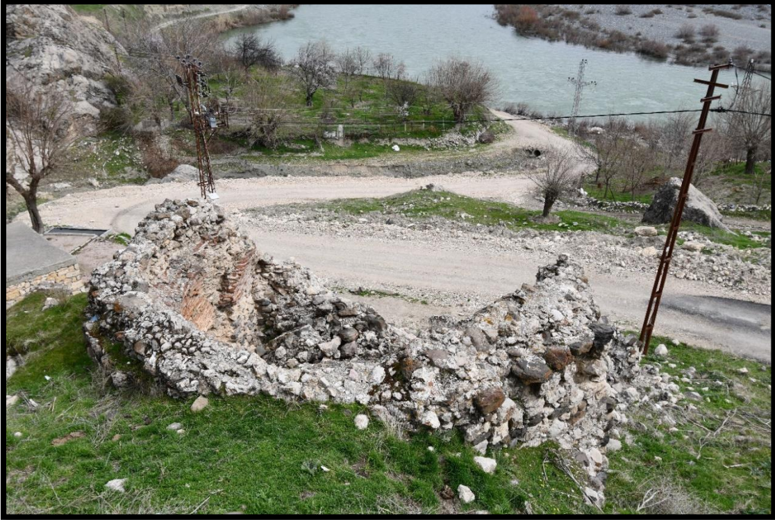
Foto 226. Kindik Hamamı toprak altındaki kuzey cephe ve sekizgen kubbe kasnağı
