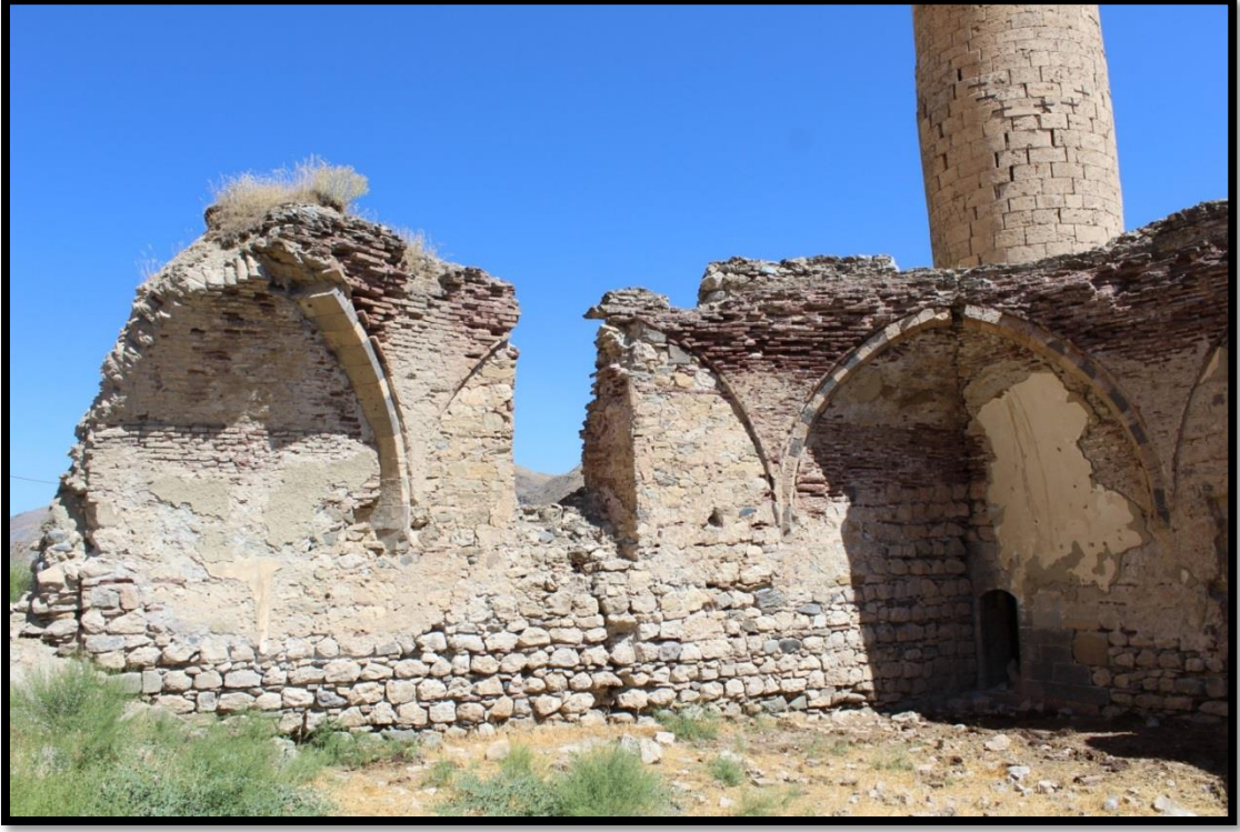
Foto 37. Küçük Cami harim doğu duvarı
