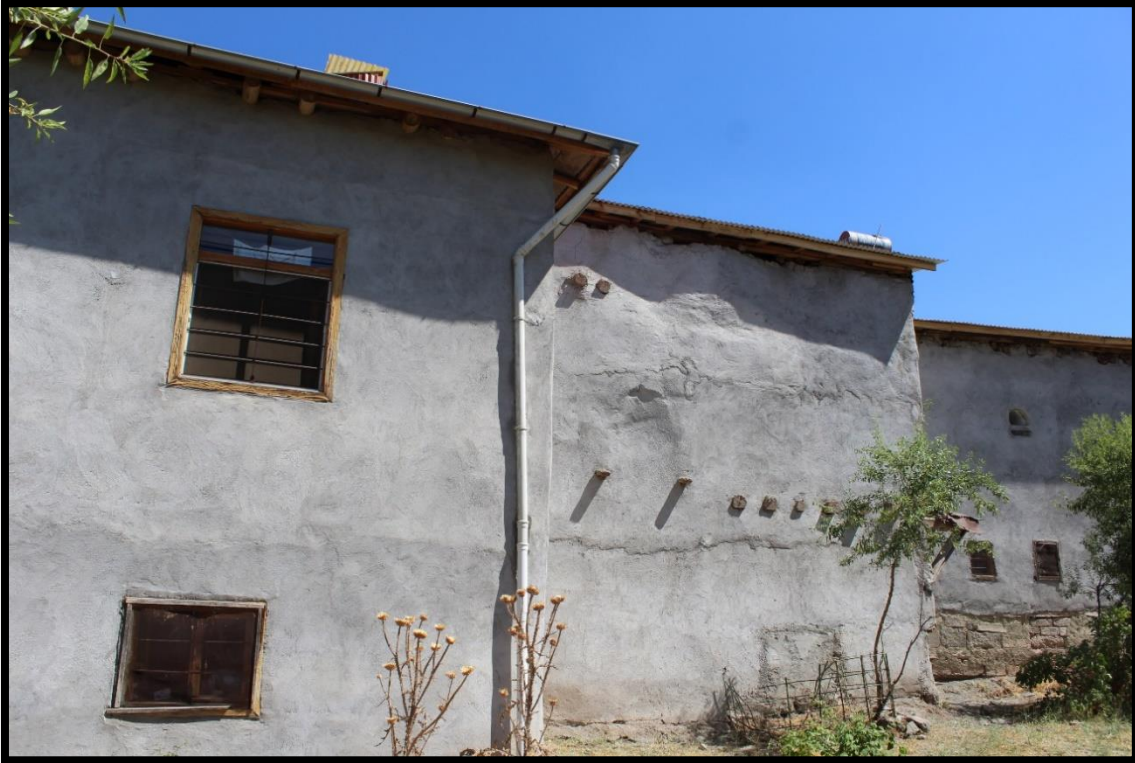
Foto 244. M. Samini Evi kuzeybatı cephe
