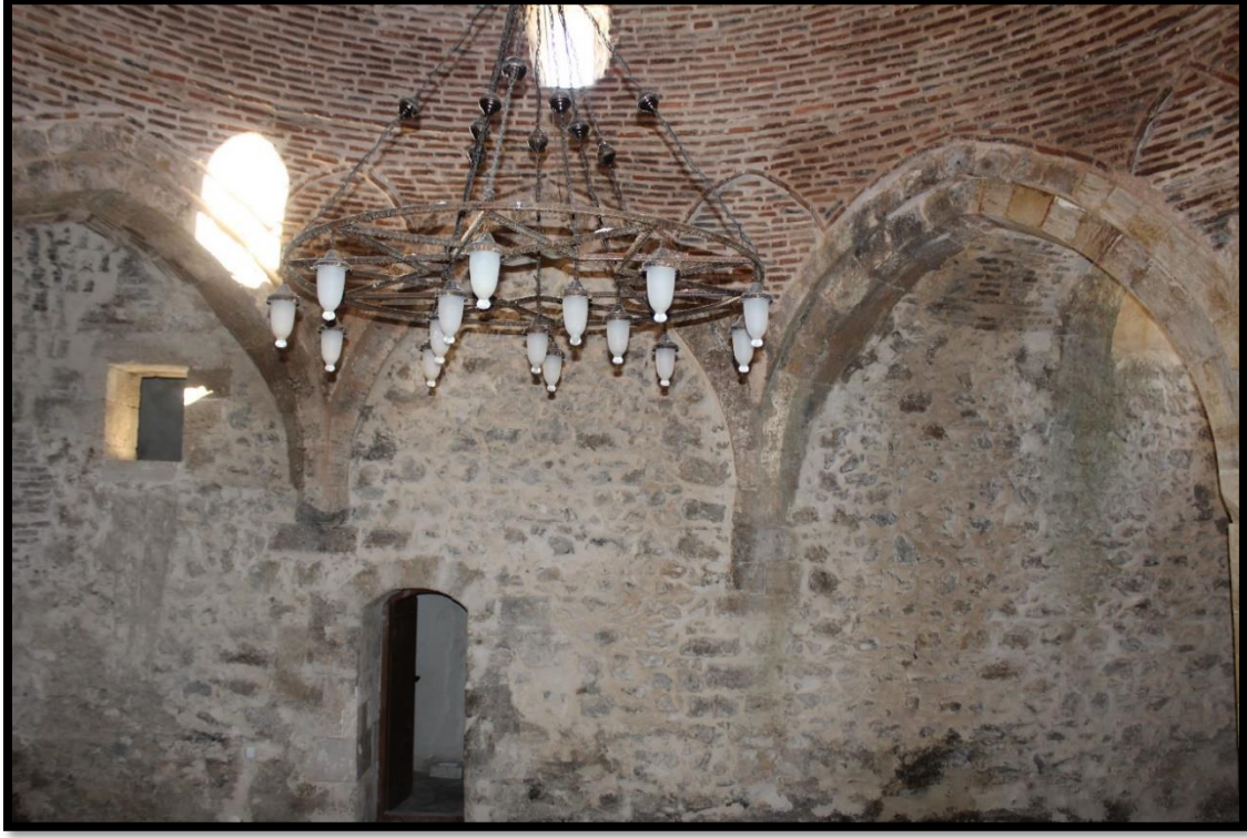
Foto 213 Çarşıbaşı Hamamı doğu duvarı ve ılıklik giriş kapısı
