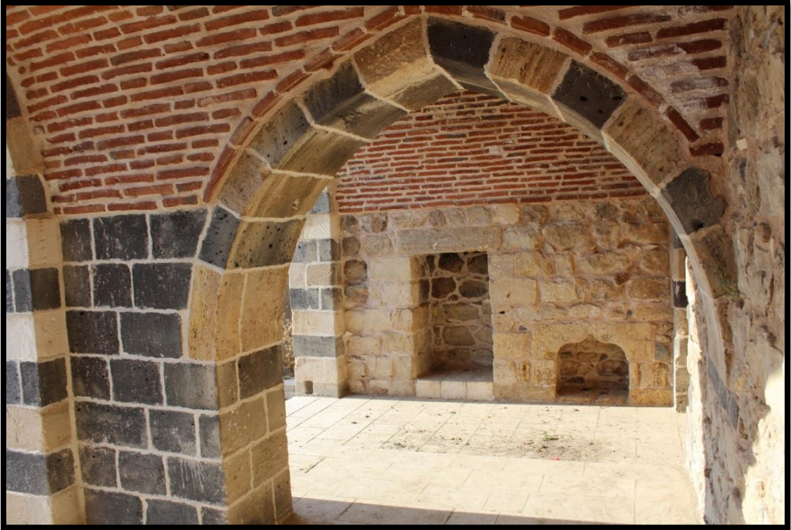
Foto 122. Alacalı Tekke Kemerli Bağlantı Açıklığı ve Nişler
