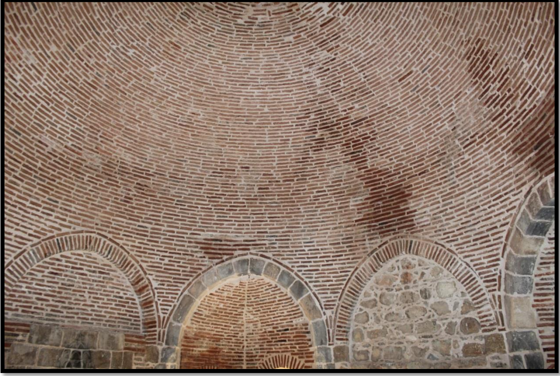
Foto 129. Alacalı Tekke Tevhidhane Kubbe ve Geçiş Öğeleri
