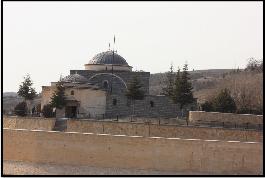
Foto 49. Cemşid Bey Külliyesi Genel Görünüş (Doğu)
