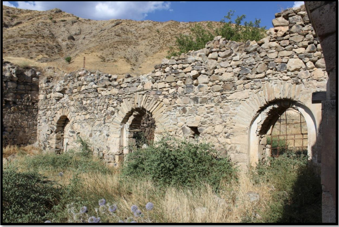
Foto 75. Dükkanönü Cami Harim Doğu Duvarı
