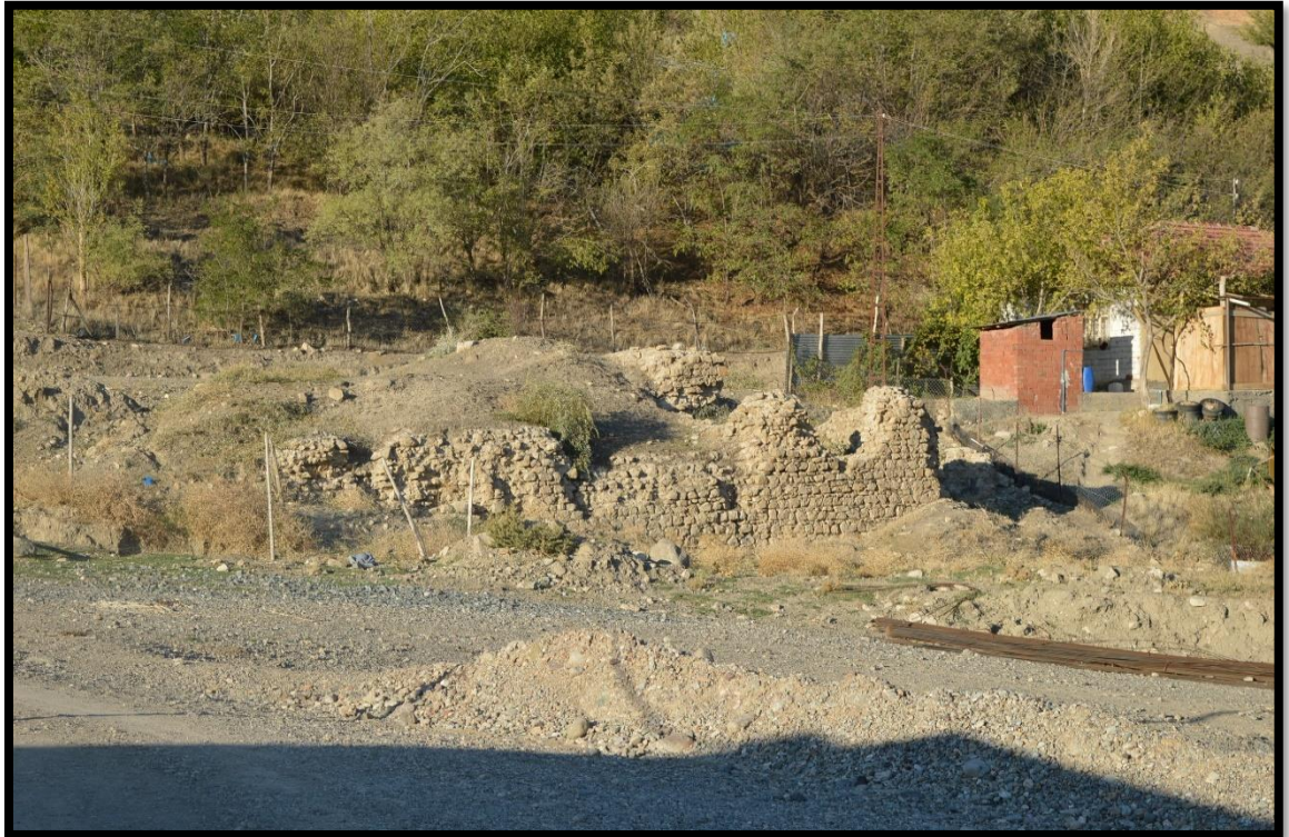
Foto 200. Cemşid Bey Hamamı güney cephe (VGMA-2014)
