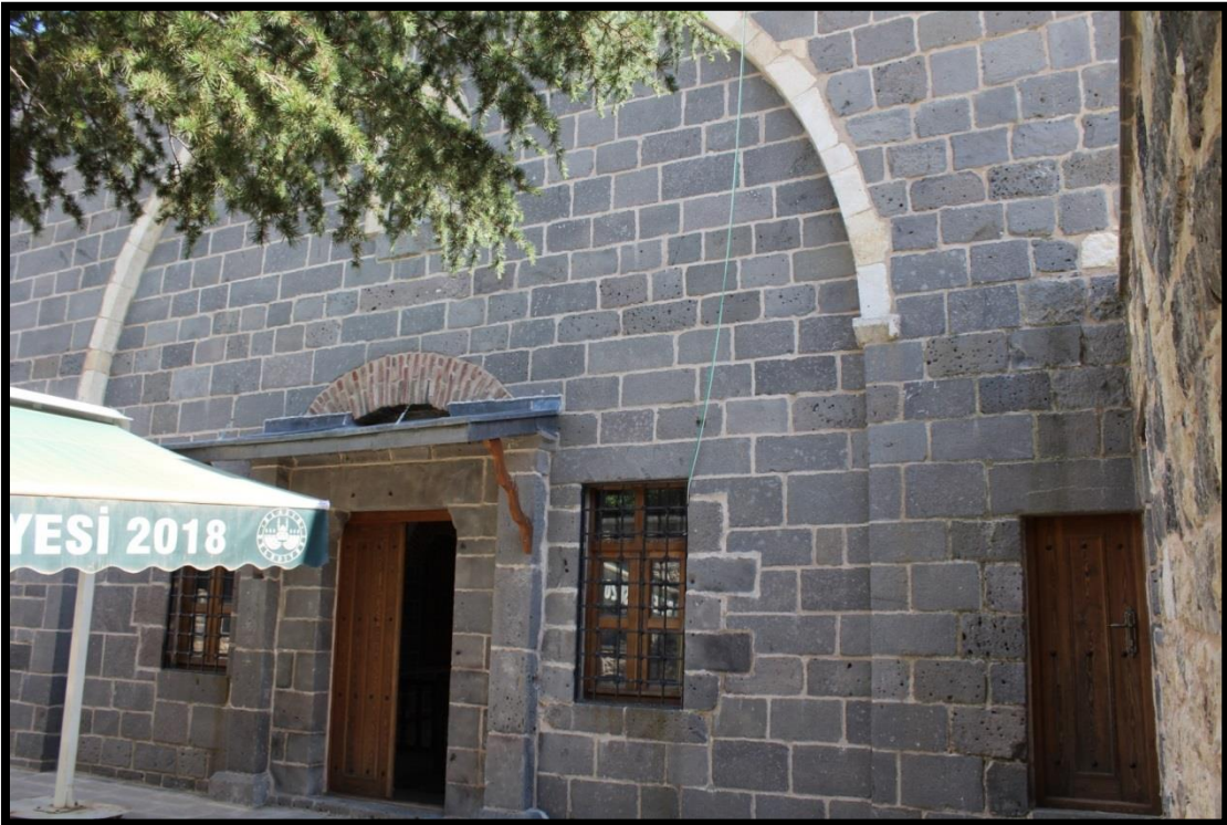
Foto 52. Cemşid Bey Cami Kuzey Cephe
