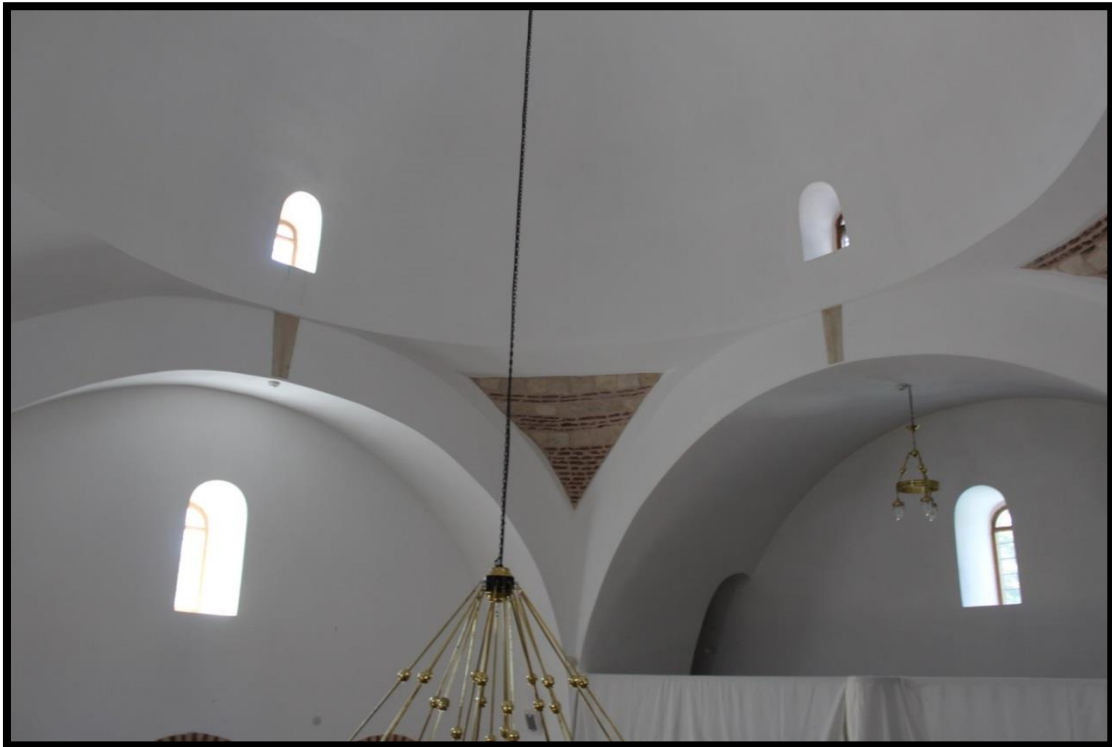
Foto 60. Cemşid Bey Cami kuzey kemeri, kubbe geçişleri ve kubbe
