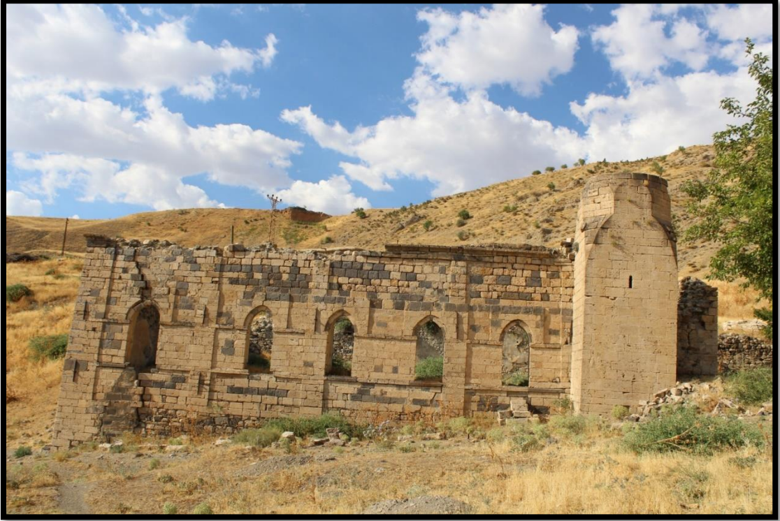
Foto 70. Dükkanönü Cami Güney Cephe
