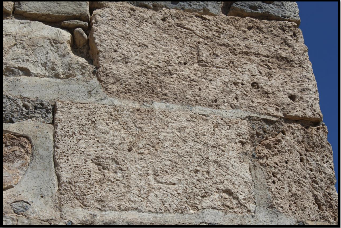
Foto 160. Seydili Köyü Tekkesi Güneybatı Köşedeki Taşçı İşaretleri
