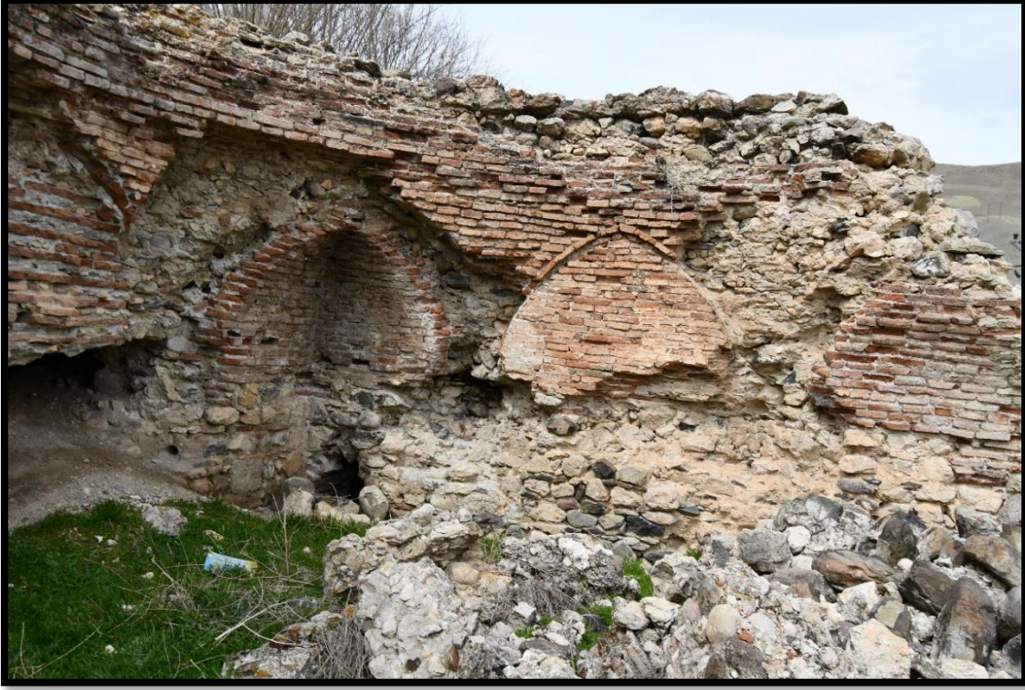
Foto 229. Kındik Hamamı sıcaklık kısmı
