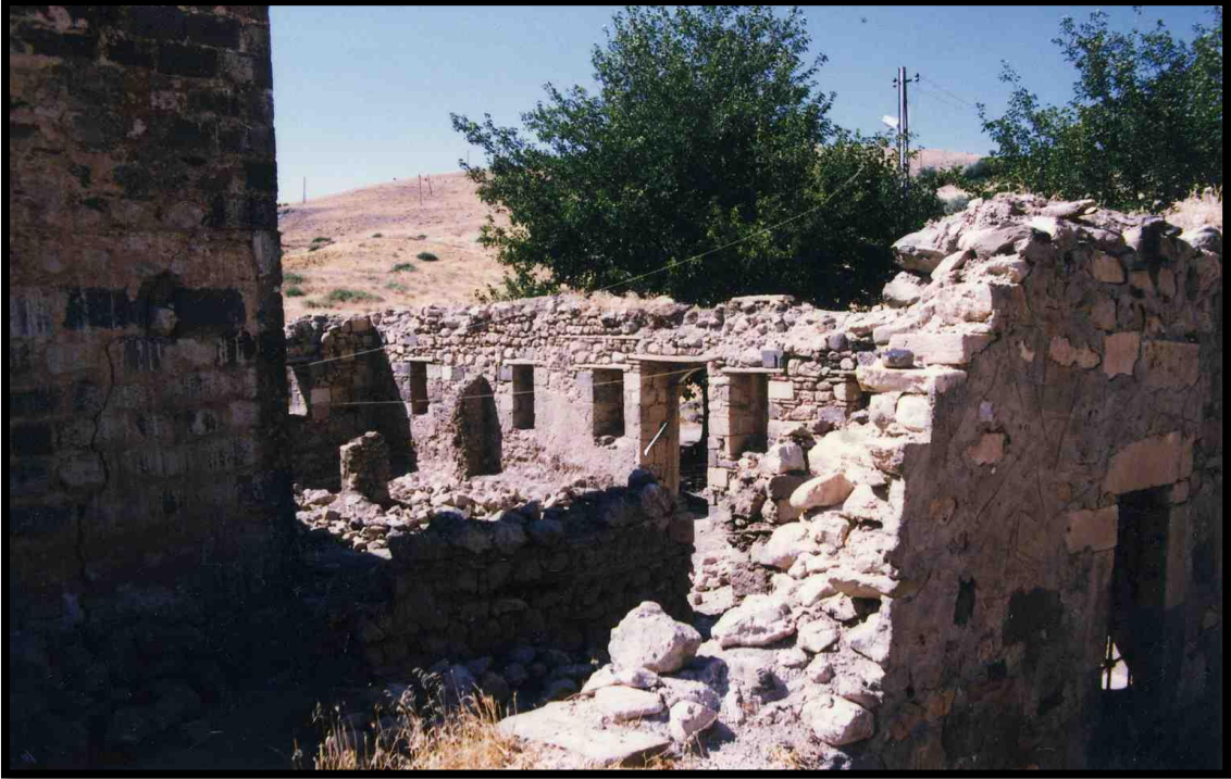
Foto 140. Cemşid Bey Zaviyesi cami avlusuna dönüştürülen kuzey hücre duvarları (VGMA-1990'lı yıllar)
