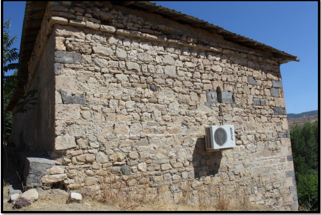
Foto 151. Seydili Köyü Tekkesi Batı Cephe
