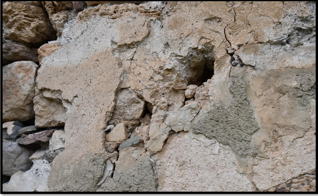
Foto 111. Kındık Tekkesi sıva kalıntıları
