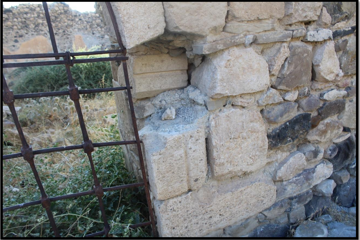
Foto 88. Dükkanönü Cami Pencere örgüsünde devşirme taşlar
