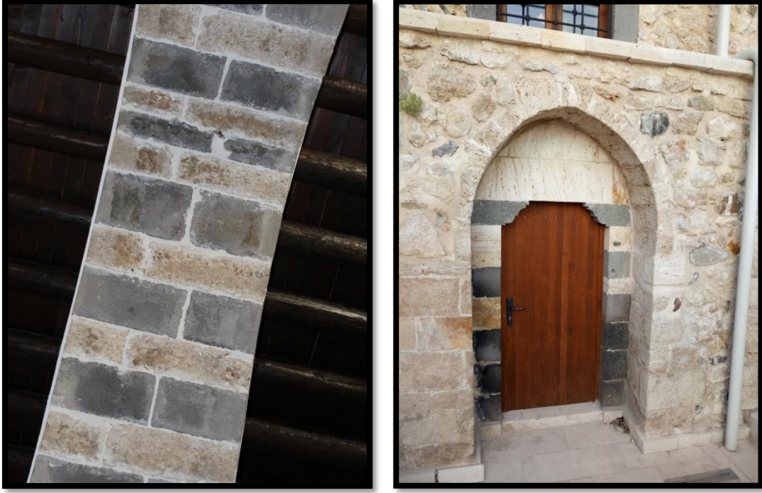
Foto 23. Ulu Cami almasıık düzende yapılmış taşıyıcı ve batı kapı girişı
