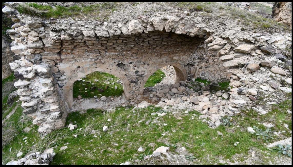
Foto 110. Kındık Tekkesi Şeyh Makamı ve sol duvar altında pencere söve izi
