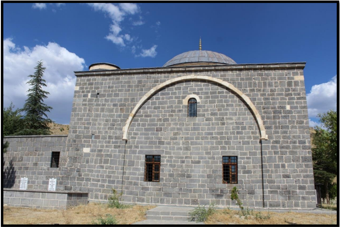
Foto 56. Cemşid Bey Cami Batı Cephe
