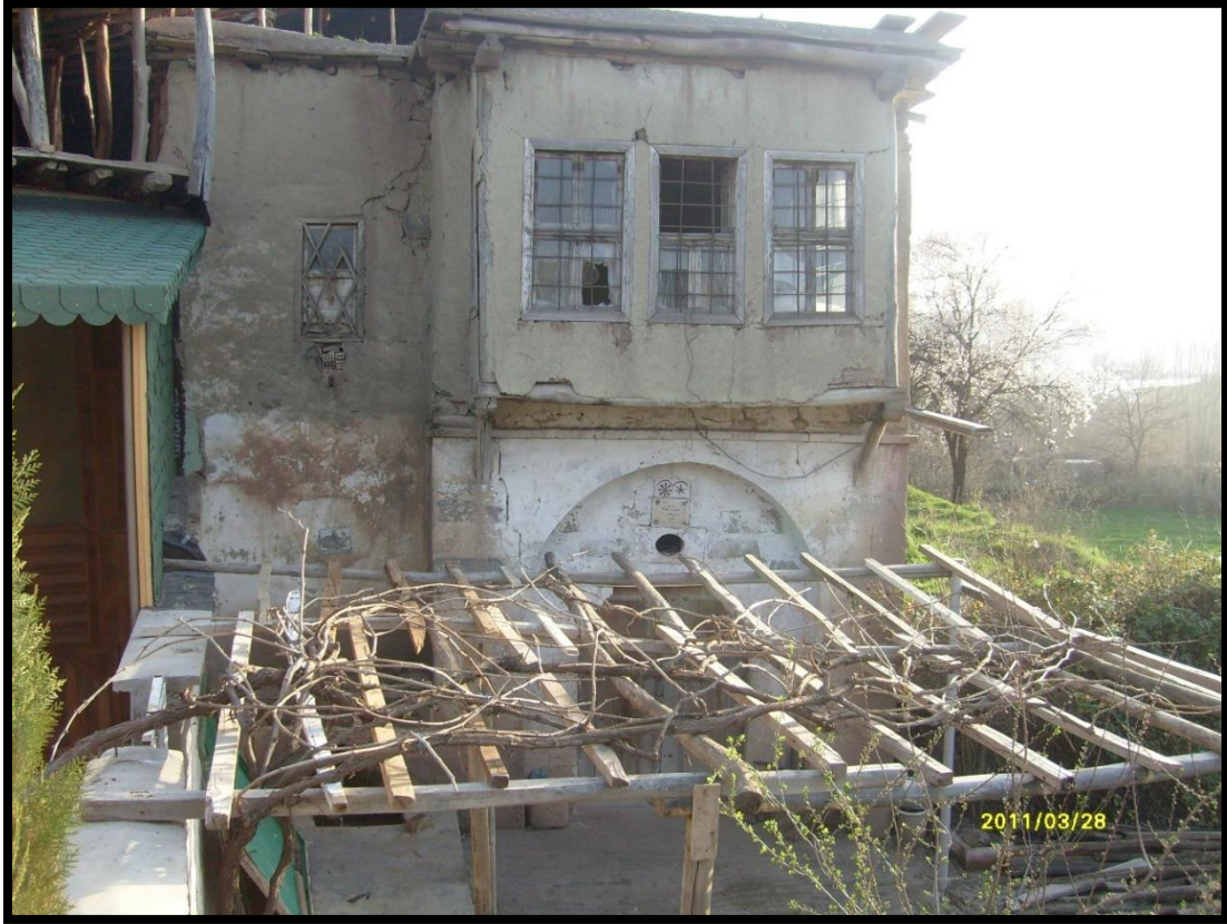
Foto 247. M. Samini Evi kuzeydoğu giriş cephesi (2011)
