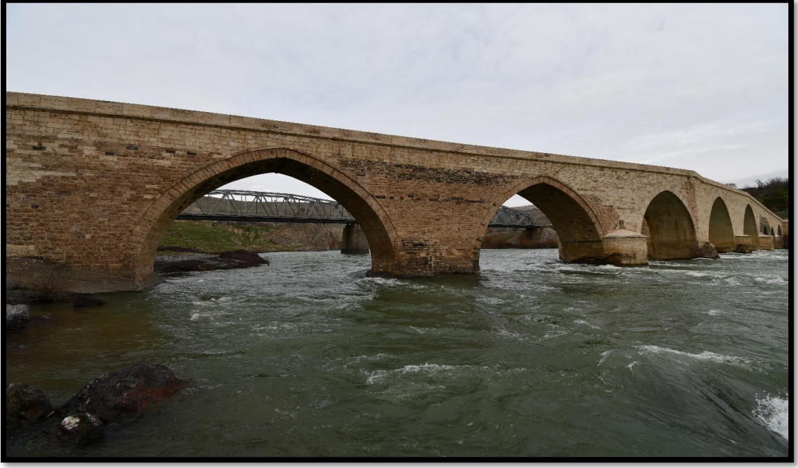
Foto 233. Palu Köprüsü Mansap yönü (güney)
