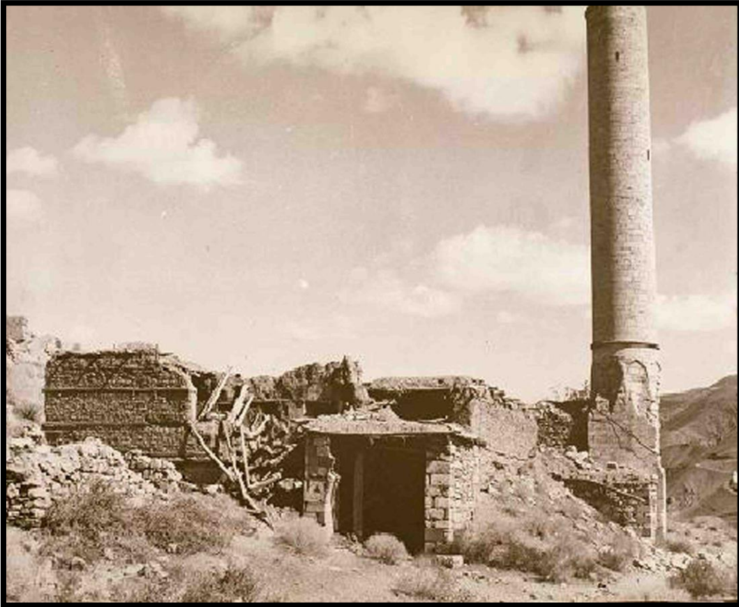
Foto 30. Ulu Cami batı cephe kerpiç duvarlı son cemaat kısmı
