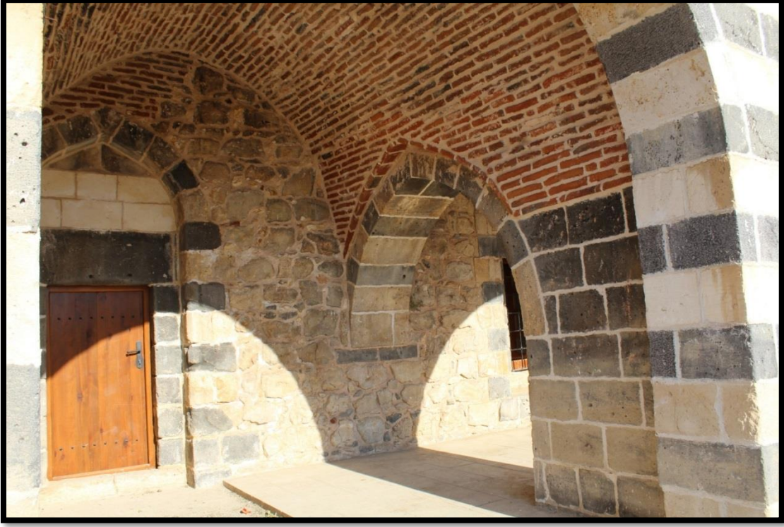
Foto 123. Alacalı Tekke Kemerli Bağlantı Açıklığı ve Kapı Girişi
