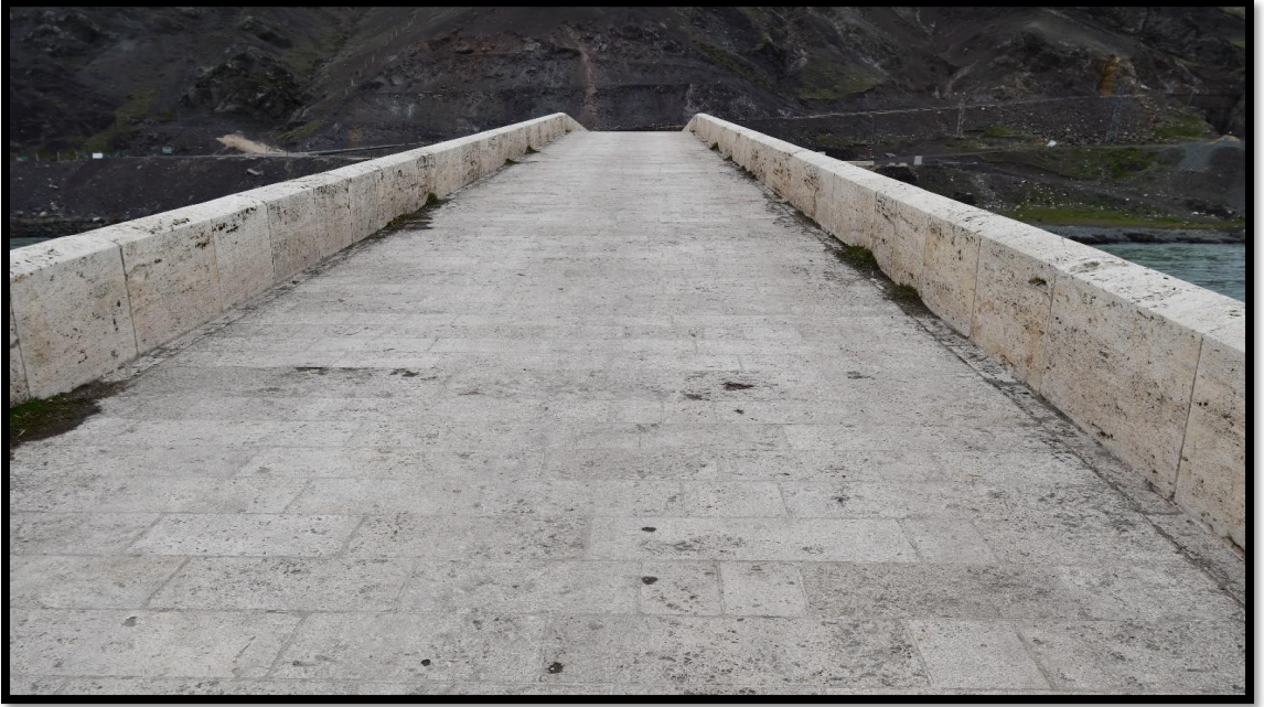
Foto 234. Palu Köprüsü tabliye
