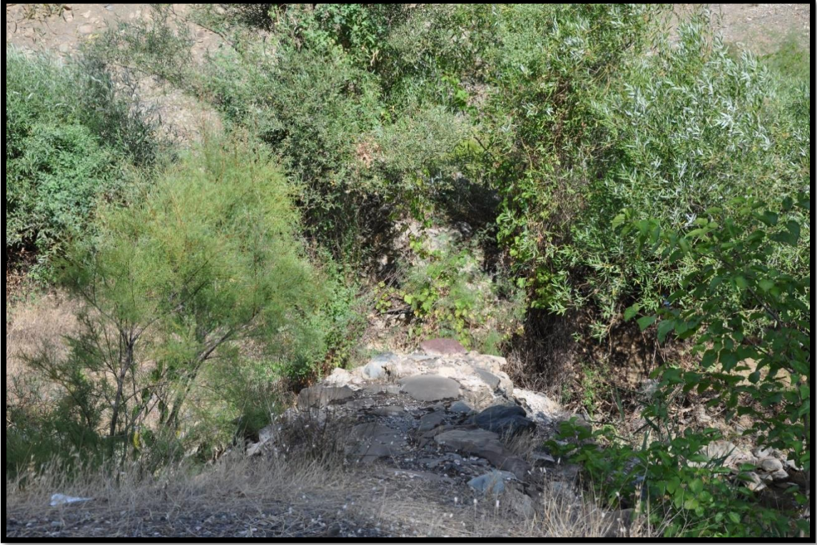
Foto 242. Teke Deresi Köprüsü batı yönü taş tabliye
