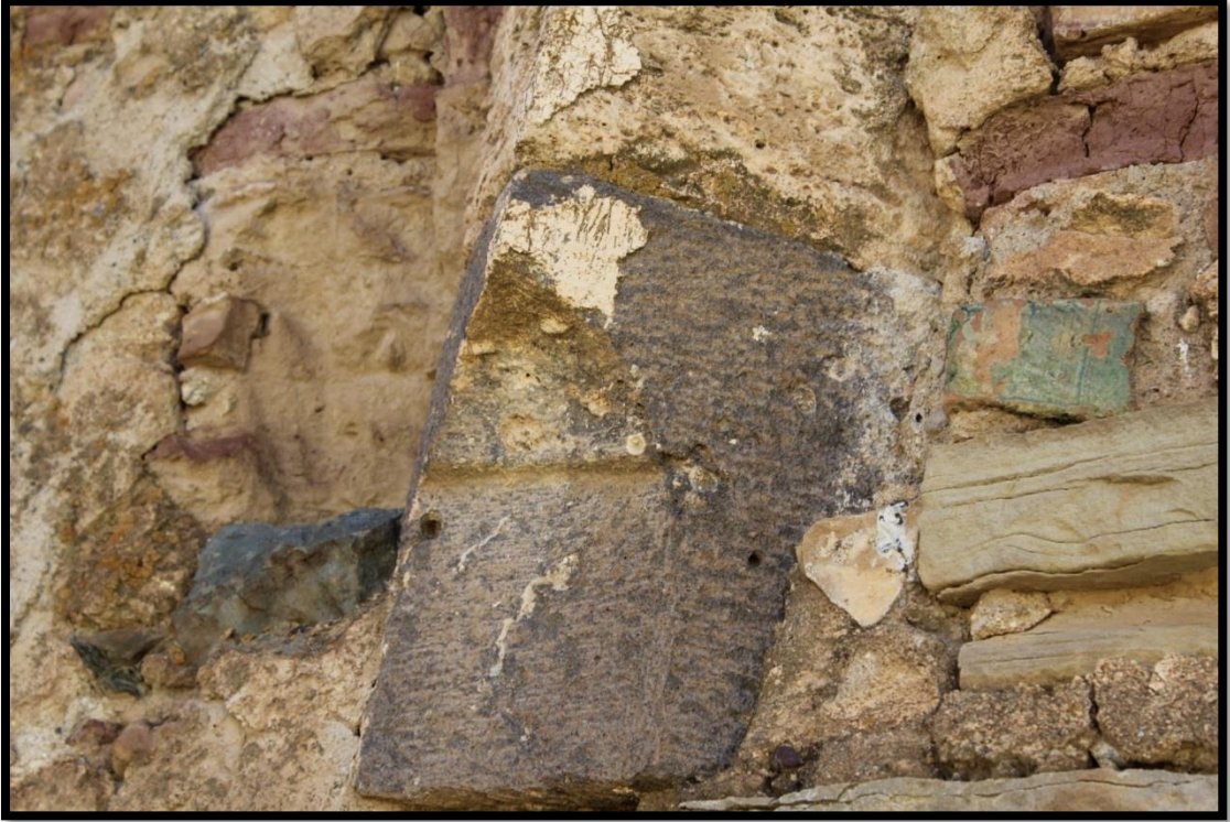
Foto 46. Küçük Cami harım içerisinde kemer üzengi taşı ve yeşil sırlı tuğla
