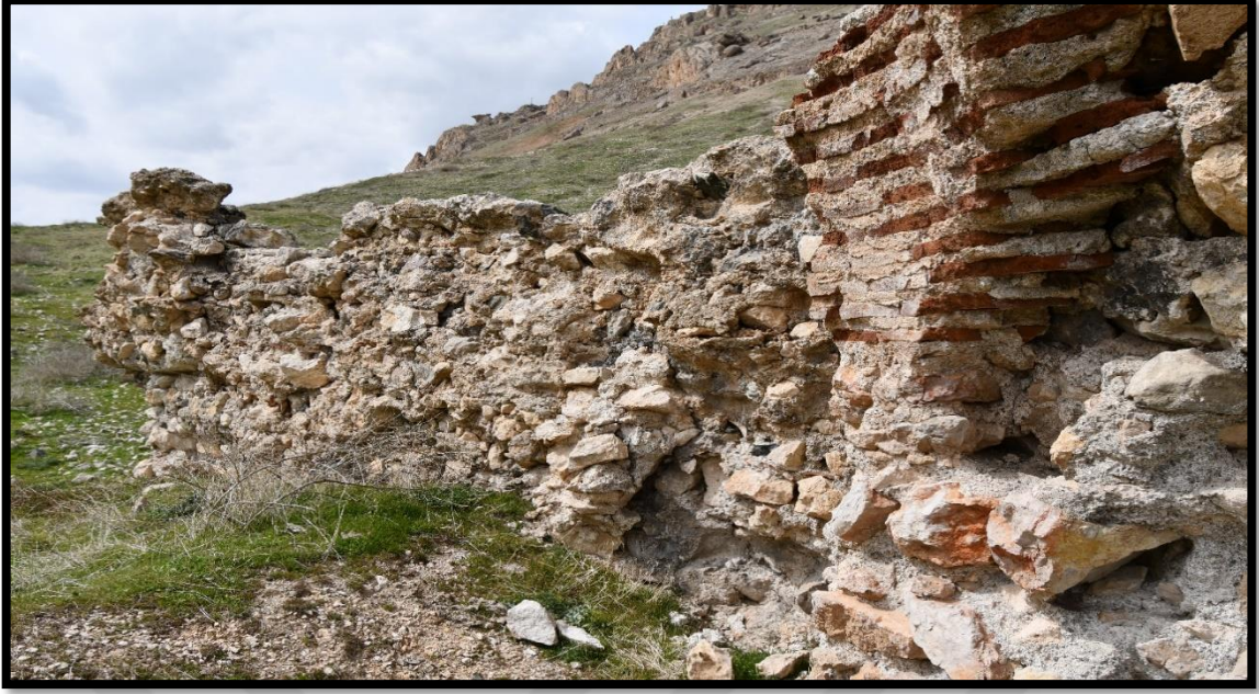
Foto 177. Küçük Kilise kuzey duvarı iç kısım
