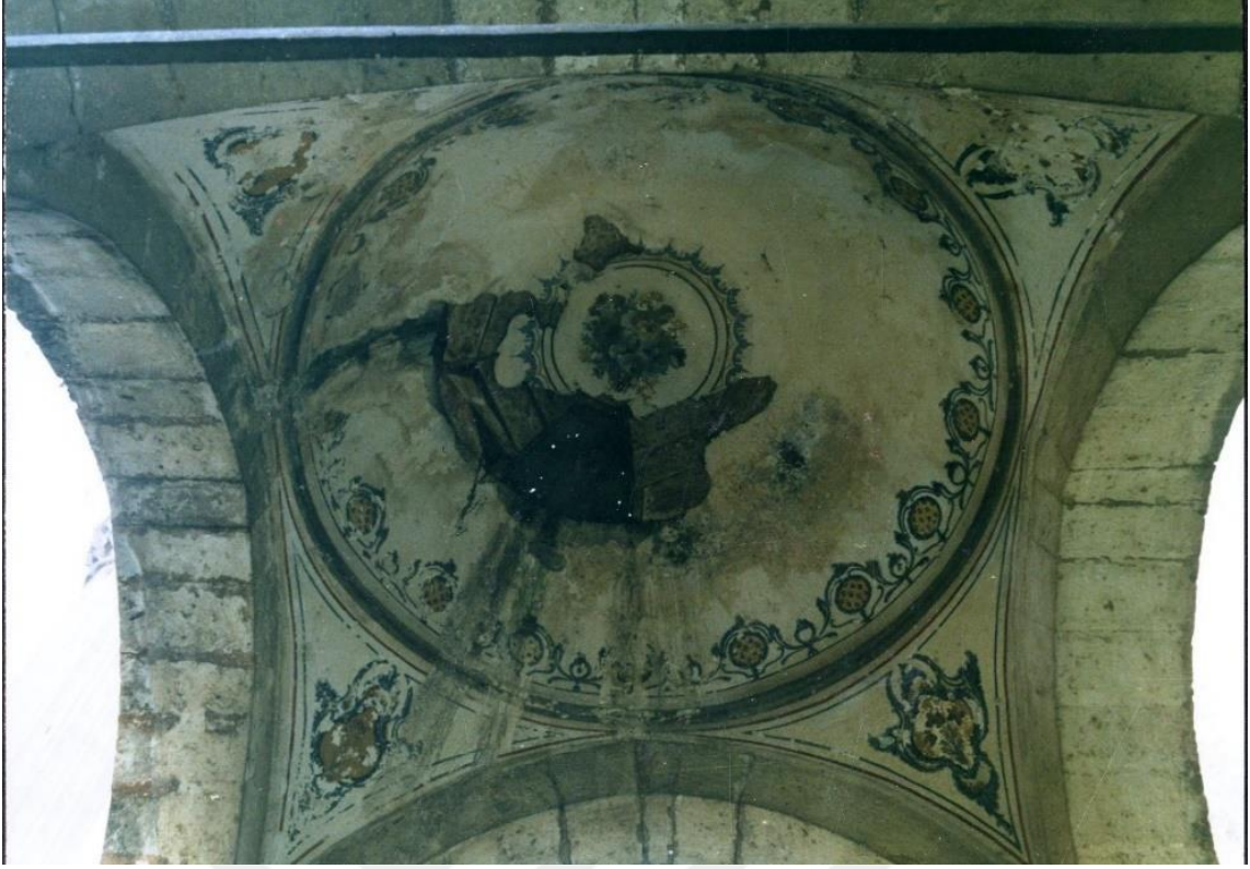
Resim 25: Selimiye Külliyesi, Şehzade Türbesi'nden kubbe detayı 573
