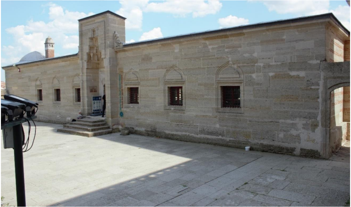
Resim 12: Caminin güneydoğu köşesinde bulunan medresenin kuzey cephesi (2021)
