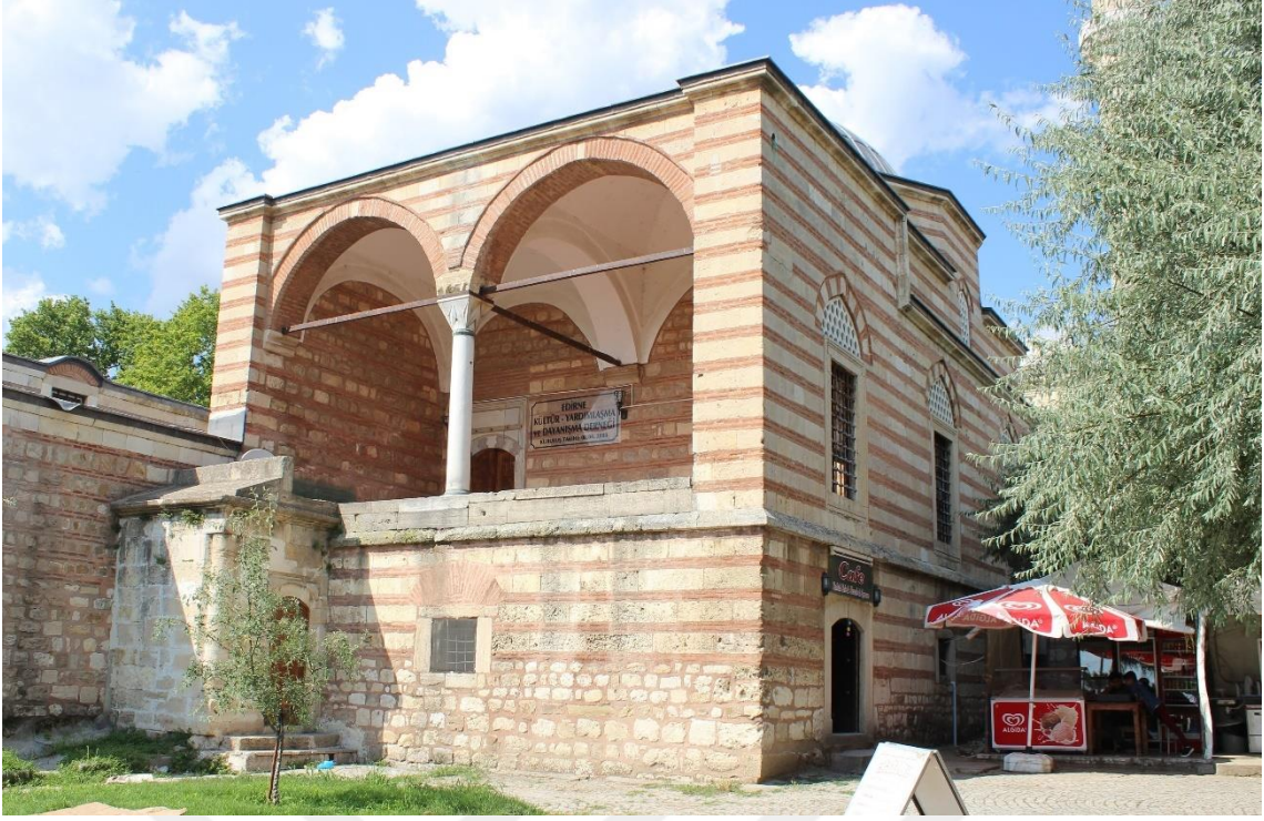
Resim 14: Sıbyan Mektebi'nin batı ve güney cepheleri (2021)
