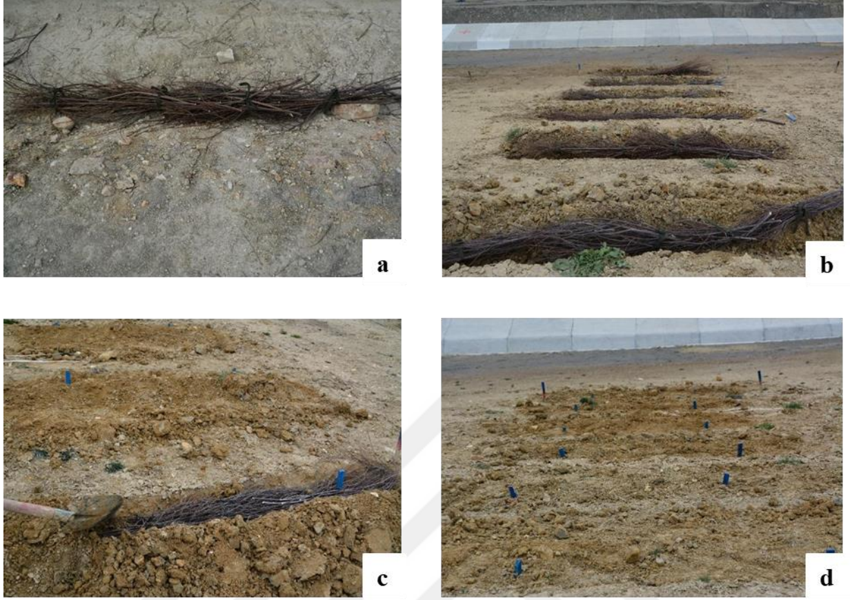
Şekil 3.9: Canlı dal demetlerinin hazırlanması (a) hendeklere yerleştirilmesi (b), kazıklarla sabitlenmesi (c) üzerinin kapatılması (d).
