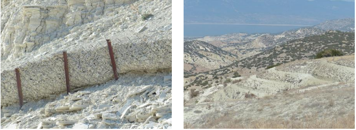
Şekil 4.26: Kafes tel çit teras (solda), teras yapımı-fidan dikimi (sağda).
