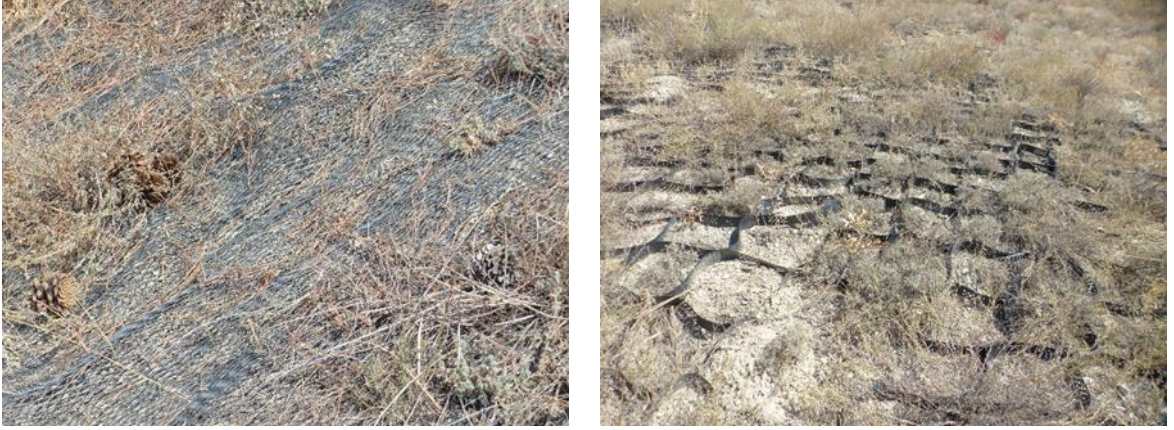
Şekil 4.23: Geonet- serme geosentetik (solda), geosentetik hücre serilmesi (sağda).
