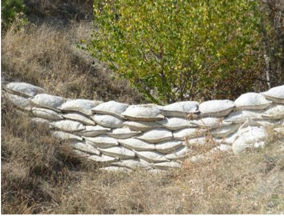
Şekil 4.21: Çuval sedde (solda), örme çit (sağda).
