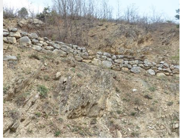
Şekil 4.32: Cep tipi teras- taş kordon.
