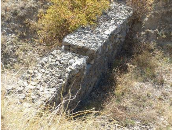
Şekil 4.22: Kutu gabion eşik (solda), çalı takviyeli teras (sağda).
