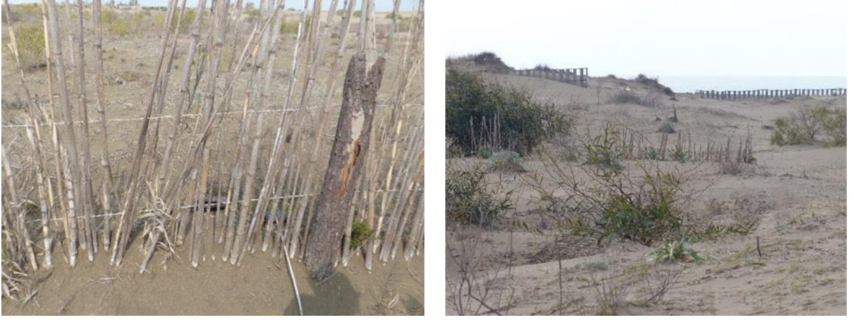
Şekil 4.29: Örme çit ve perde yapımı.
