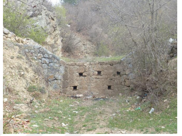
Şekil 4.31: Harçlı taş duvar eşik- harçlı ıslah sekisi.
