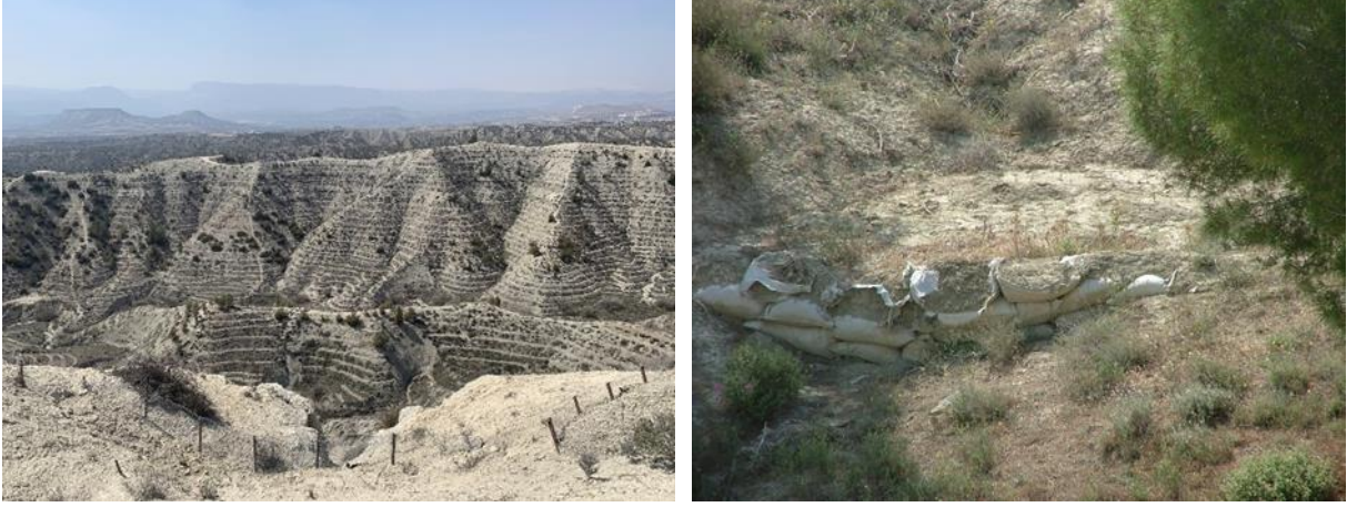
Şekil 4.30: Kafes tel çit teras, kafes tel eşik, teraslama, fidan dikimi (solda), çuval sedde (sağda).
