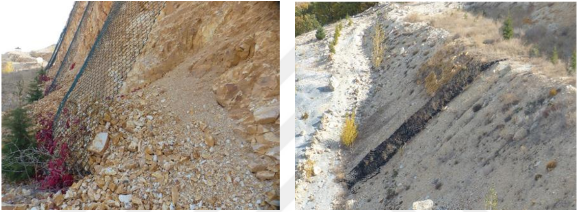
Şekil 4.19: Çelik tel ağ (solda), geonet serilmesi (sağda).
