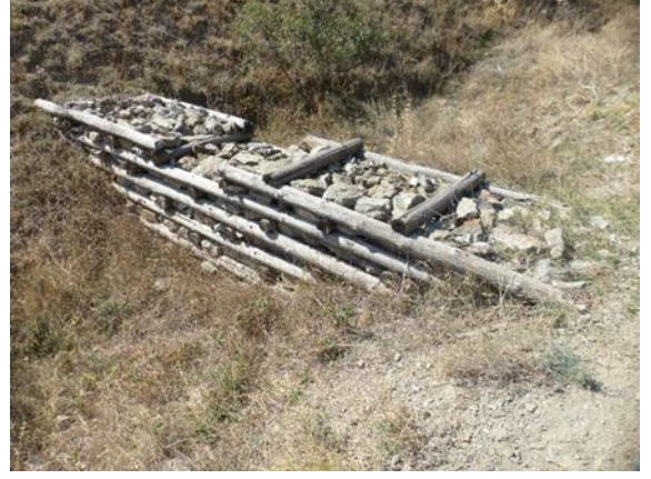
Şekil 4.20: Geonet çit (solda), ahşap kafes (çatma) eşik (sağda).
