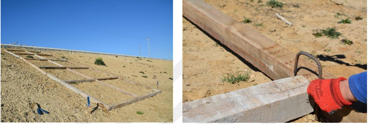
Şekil 3.11: Yamaç ızgaralarının hazırlanması ve demirlerle sabitlenmesi.
