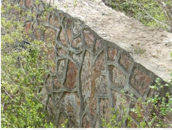
Şekil 4.31: Harçlı taş duvar eşik- harçlı ıslah sekisi.
