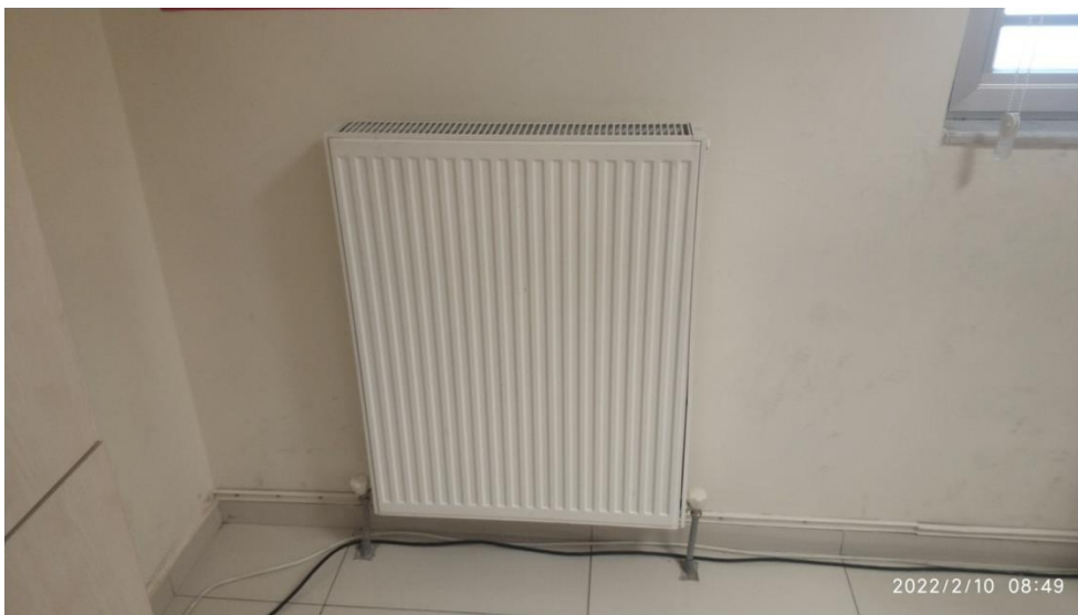
Görsel 5.31: Radyatör Bağlantı ve Vanaları
