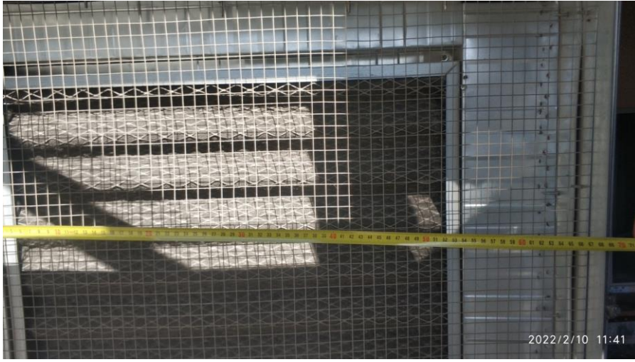
Görsel 5.17: Binanın 2'nci Bodrum Kat Havalandırma Kanal Ölçümleri
