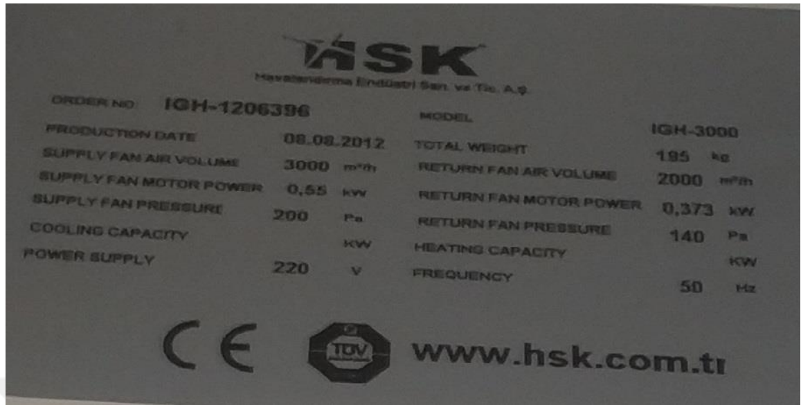
Görsel 5.27: Binanın 1'nci Bodrum Katındaki Vam (Rekuperatör) Etiketi
