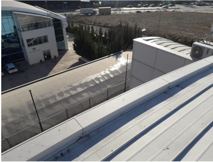
Görsel 5.30: Çatı ve Klima Dış Ünitesi
