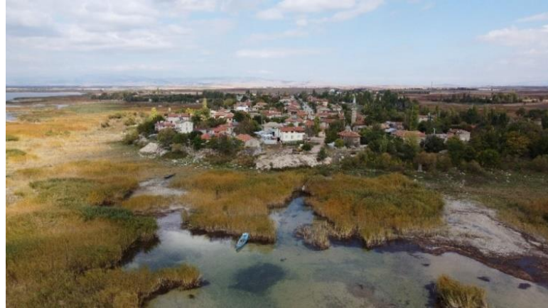
Şekil 47. Mahallenin burun kısmındaki dağınık ve organik yerleşim
