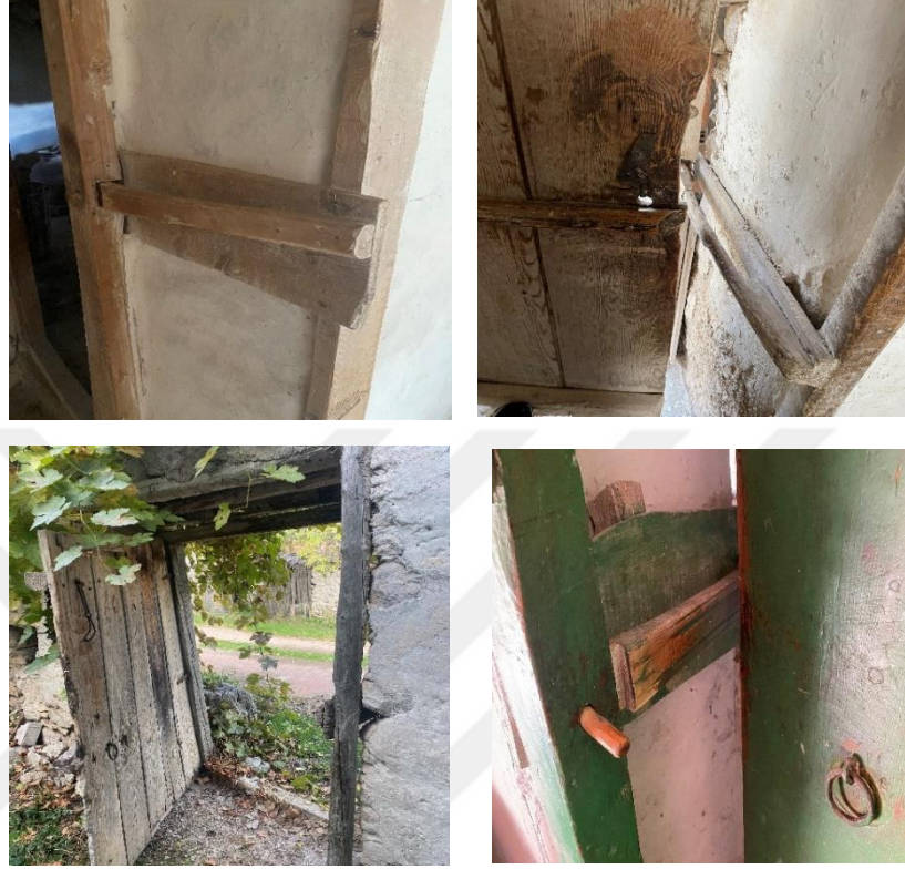
Şekil 84. Kapılardaki çeşitli kilit sistemleri
