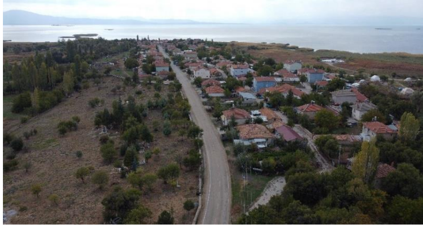
Şekil 45. Mahalle içerisinde yer alan lineer ana yol
