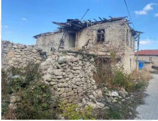
Şekil 81. Çatısı tamamen yıkılmış bir evin saçak kirişleri ve kapı üstü sundurması
