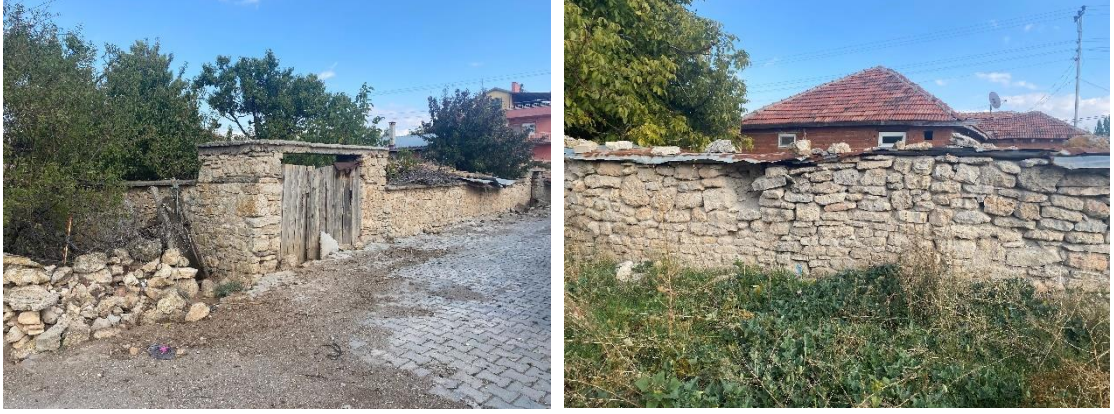
Şekil 82. Bitişleri farklı malzemeler kullanılarak sağlamlaştırılmış bahçe duvarları
