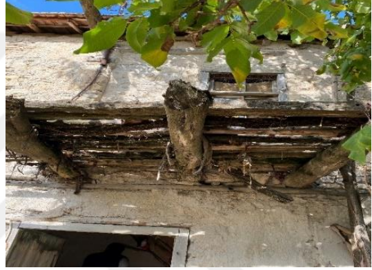
Şekil 81. Çatısı tamamen yıkılmış bir evin saçak kirişleri ve kapı üstü sundurması
