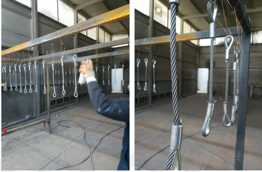
Şekil 4.24 Çelik halatların çinko bakımından zengin epoksi astar ile boyanması (Kişisel arşiv, 2021)
