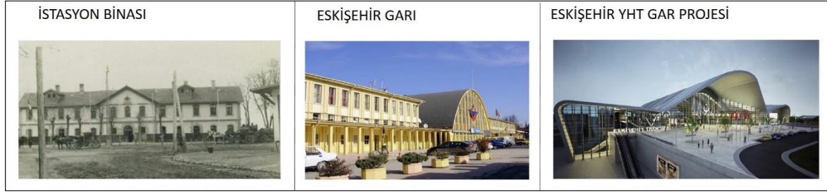
Çizelge 3.6. Eskişehir gar yapıları cephe karşılaştırması
