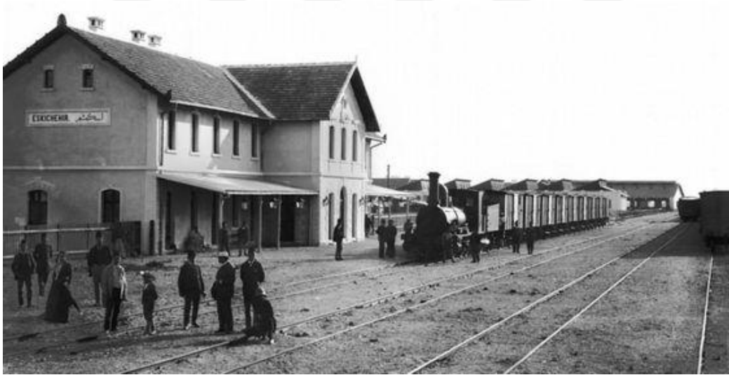
Resim 3.2. Eskişehir İstasyon Binası demiryolu cephesi (Eski Türkiye Fotoğrafları Arşivi, 2022).
