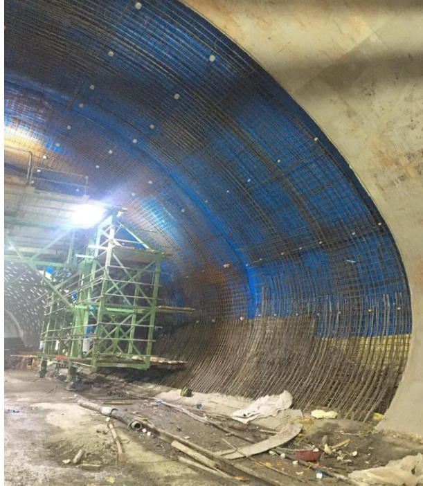
Şekil 4.28 : Kemer donatı imalatı.
