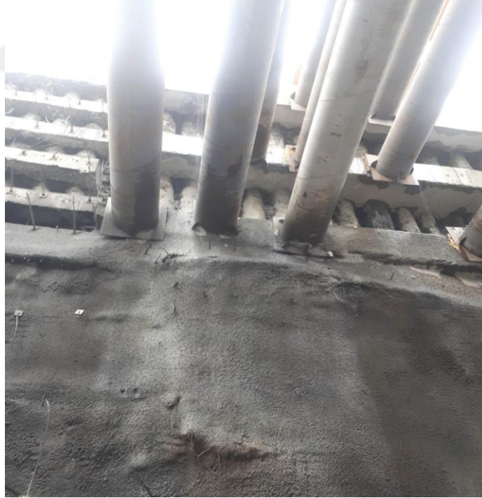
Şekil 4.68 : M14 makasında akma sonrası püskürtme beton-hasır çelik imalatı.
