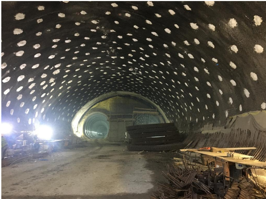
ekil 2.3 : NATM tnel kesiti.
