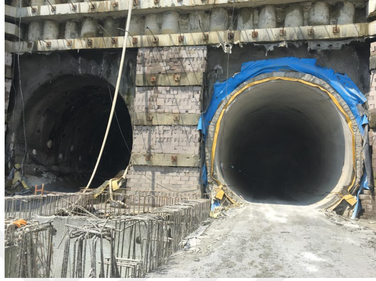
Şekil 4.31 : Geçici tahkimat imalatı (sağdaki) ve kalıcı kaplama imalatı (soldaki) tamamlanmış tünel kesitleri.
