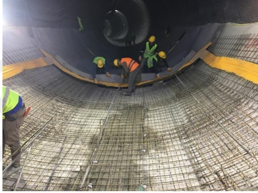
Şekil 4.24 : İnvirt donatı imalatı.
