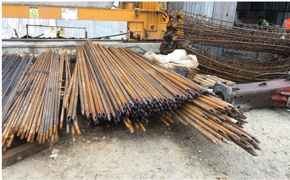
Şekil 4.19 : Süren ve tünel tahkimat donatıları.
