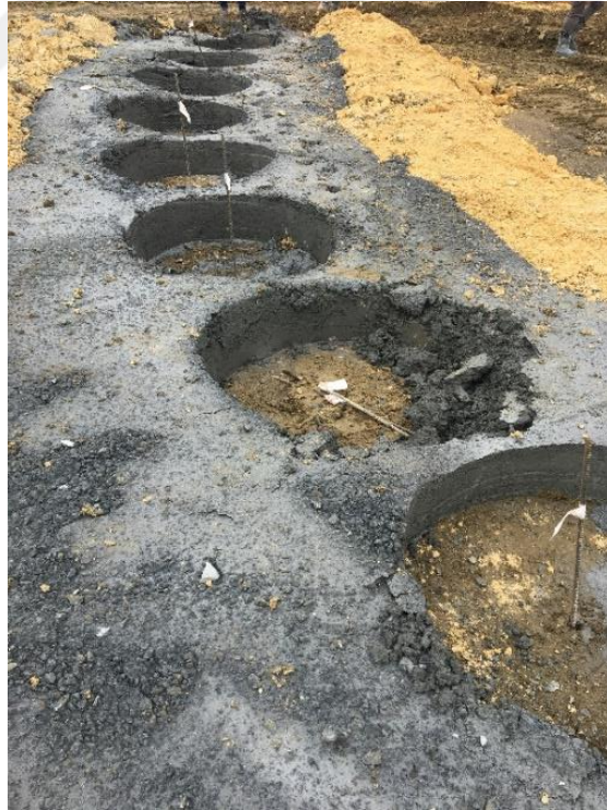
Ŗekil 4.48 : Gidaj beton uygulaması T17 servis istasyonu sahası.
