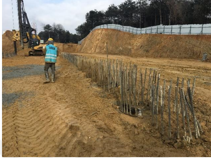
Ŗekil 4.47 : Kazık üŖ kotuna göre harfiyat alınan bekleme makası sahası.
