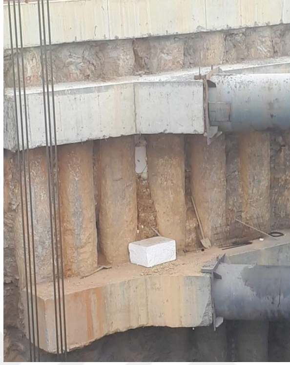
Şekil 4.67 : M14 makasında meydana gelen akma.
