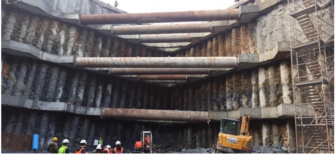
Şekil 4.52 : Kayaşehir istasyonu güney konkors sahasında çapraz strut imalatı.
