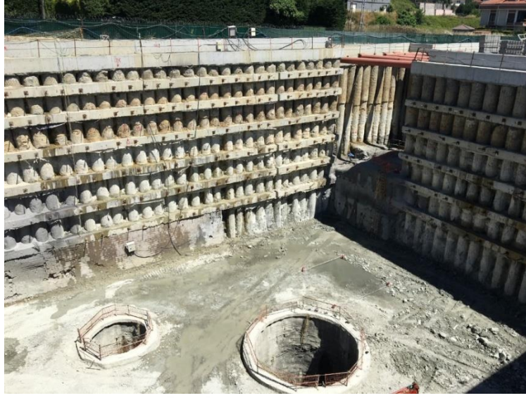
Şekil 4.54 : Arnavutköy 1 istasyonu kuzey konkors aç-kapa yapısı.
