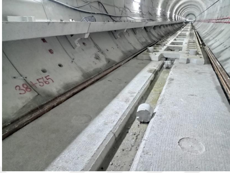
Şekil 4.46 : Yürüme yolu, ray altı betonu imalatları tamamlanmış tünel.
