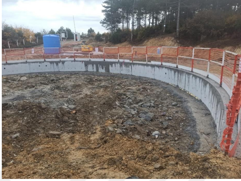
Şekil 4.61 : Fore kazık ve başlık kirişi imalatı tamamlanmış TK14 servis istasyonu şaftı kesiti.
