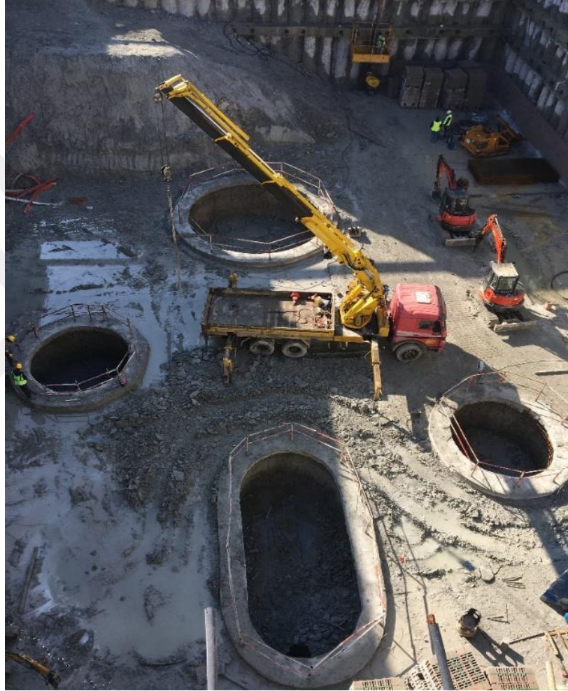
Şekil 4.56 : Arnavutköy 1 istasyonu güney konkors temel altı şaft saha görünümü.
