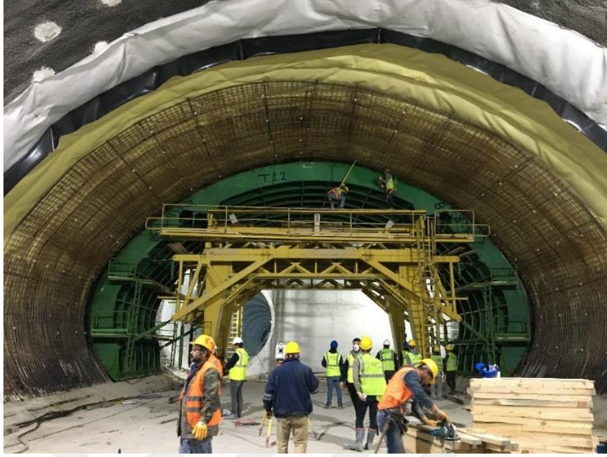
Şekil 4.25 : İzolasyon, donatı imalatı tamamlanan makas tüneline kalıcı kaplama için kemer kalıbın yerleştirilmesi.
