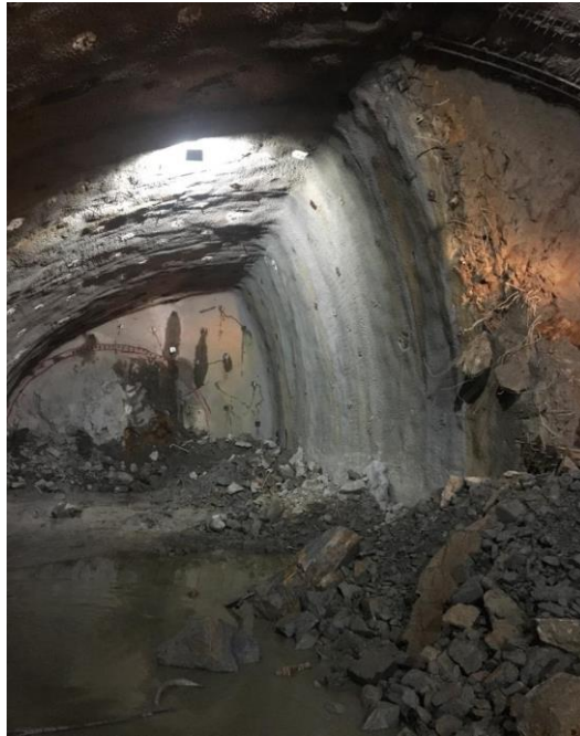
Şekil 4.17 : Aşamalı NATM kazısı.
