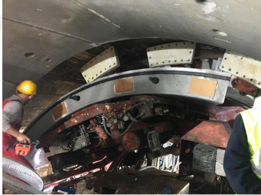
řekil 4.39 : Segmentlerin yerine yerleřtirilmesi.
