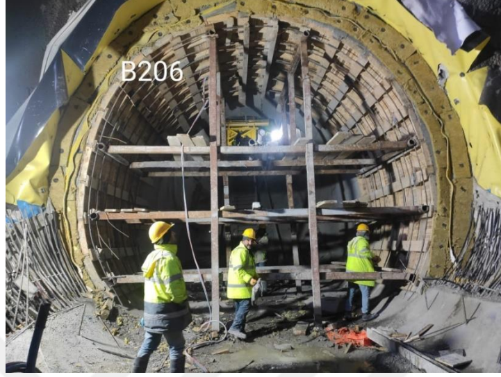
Şekil 4.27 : Ahşap kalıp imalatı.
