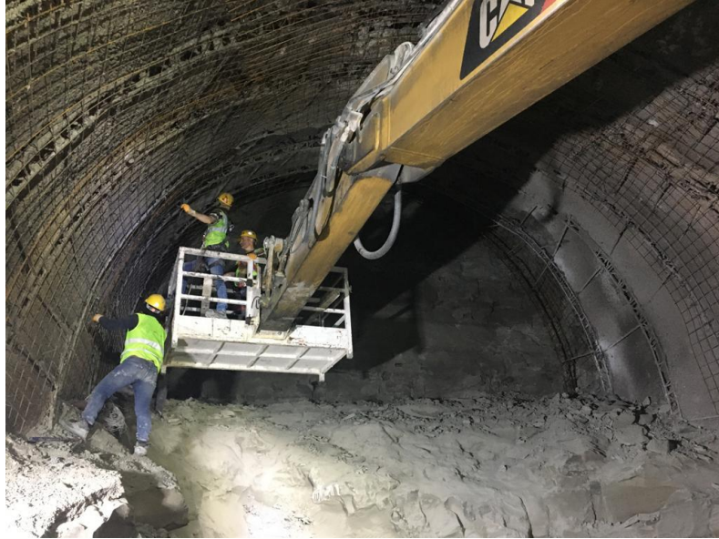
řekil 4.18 :  st yarı geici tahkimat donatısı imalatı.
