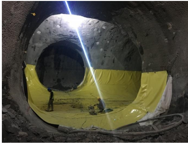
Şekil 4.23 : İnvirt izolasyon imalatı.
