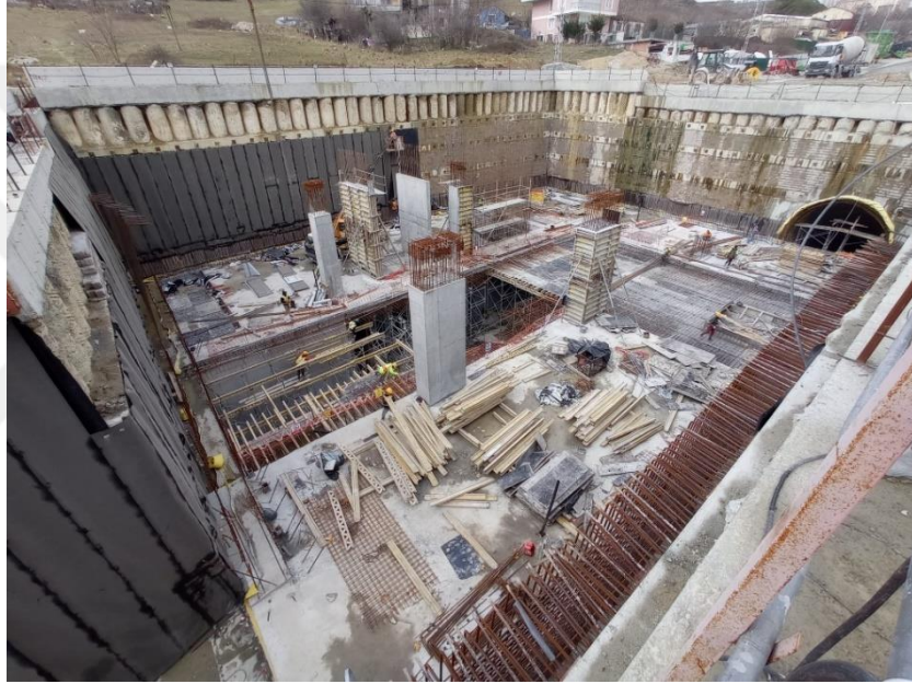
Şekil 4.59 : Arnavutköy 1 istasyonu kuzey konkors aç-kapa yapısı yalıtım uygulaması.
