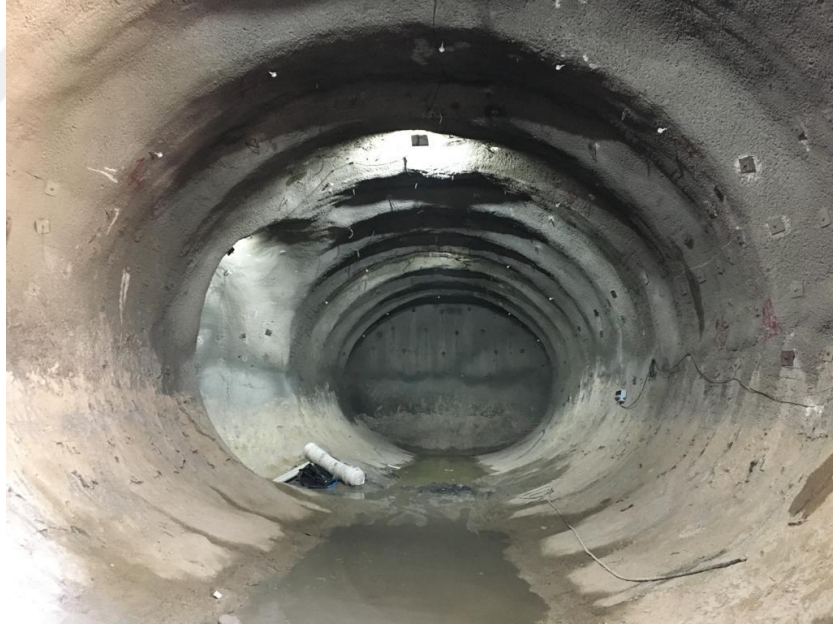
Şekil 4.21 : NATM tüneline reflektör yerleşimi.
