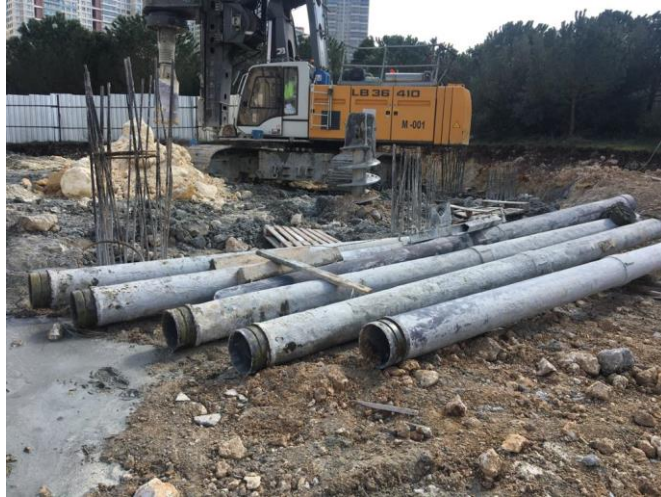
Şekil 4.50 : Tremi boruları.
