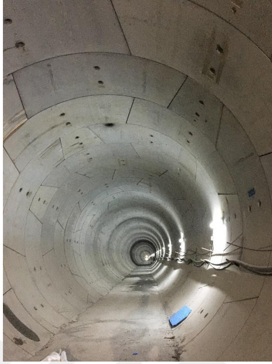
Şekil 4.45 : Segment döşemesi ve faz beton imatları tamamlanmış tünel.
