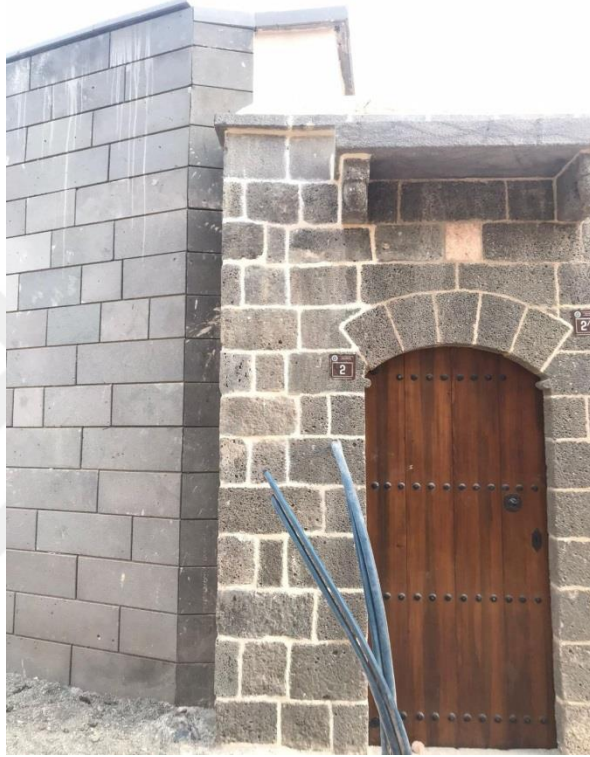
Şekil 87 Yapı Mevcut Durumu - No 2
