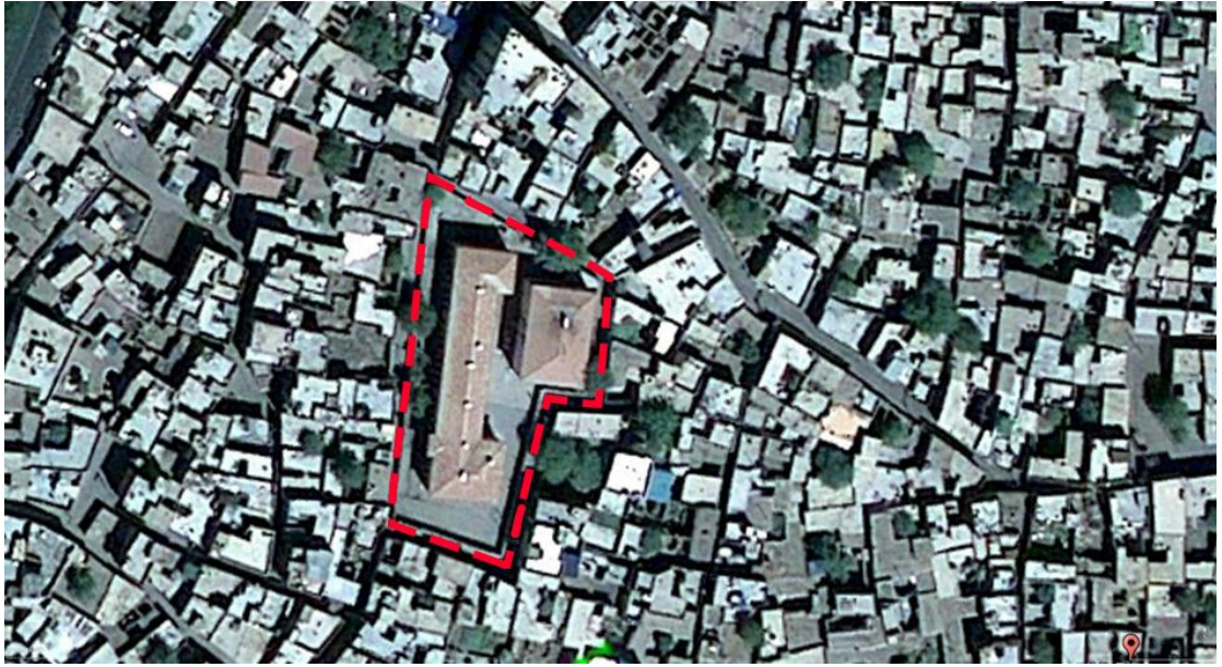
Şekil 96 Ali Paşa İlkokulu 2009 Yılı Hava Fotoğrafı (URL-5, yazar tarafından çalışma sınırı eklenmiştir)
