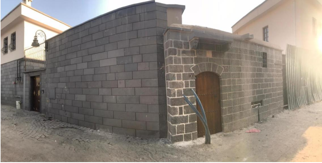
Şekil 88 Yapı Mevcut Durumu - No 2
