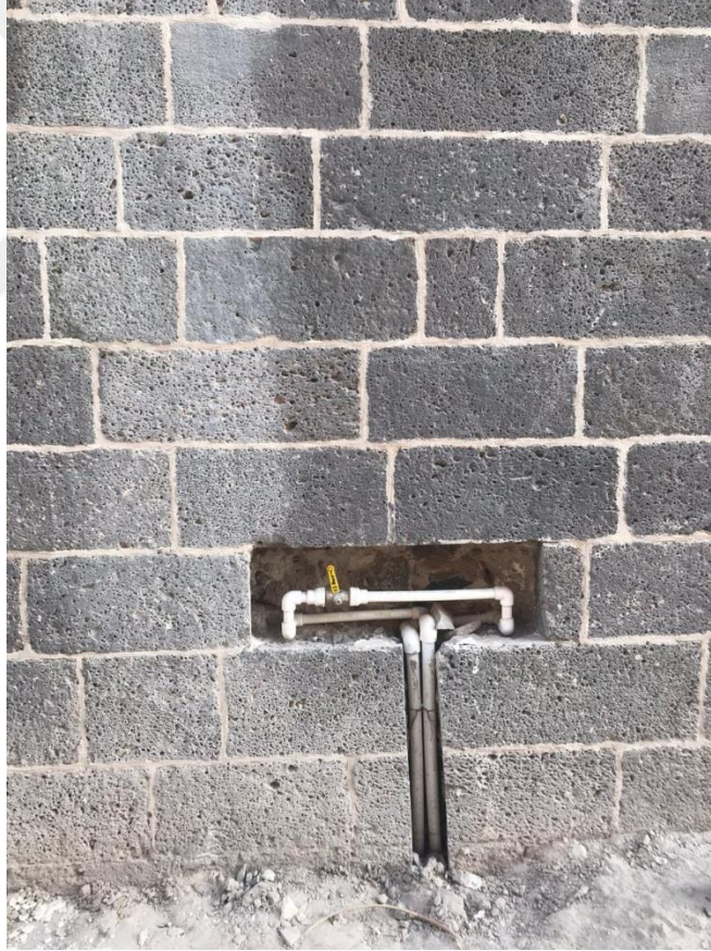
Şekil 89 Yapı Mevcut Durumu - No 2
