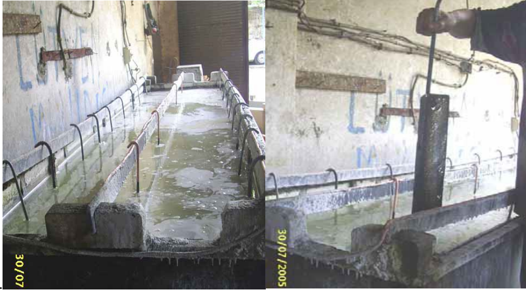
Şekil 2.32. Elektrolit galvaniz havuzu ve anot görevi yapan çinko külçe [66].
