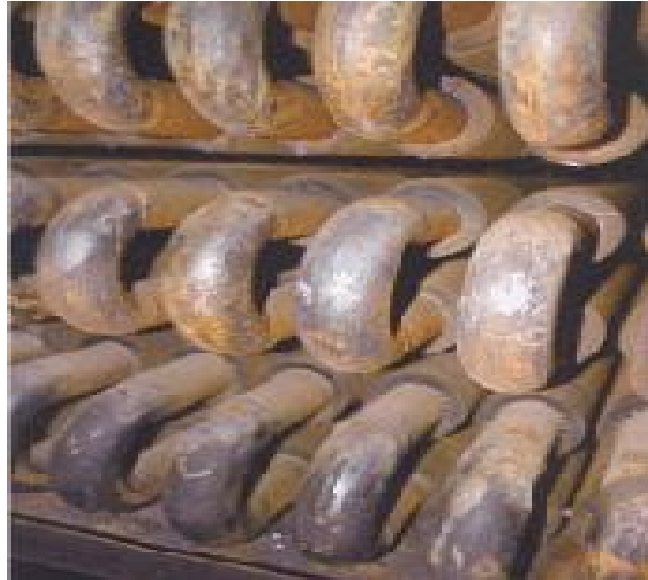
Şekil 2.21. Isı değiştiricilerde yüksek sıcaklık korozyonu [48].
