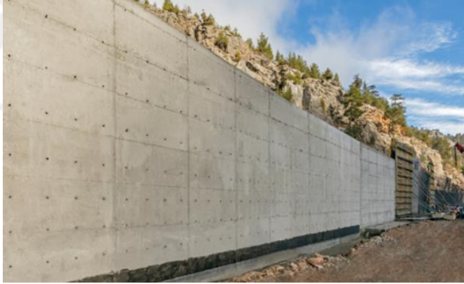
Şekil 2.13: Betonarme İstinat Duvarı ( http://www.acelinsaat.com/devam-eden-projeler/ )
