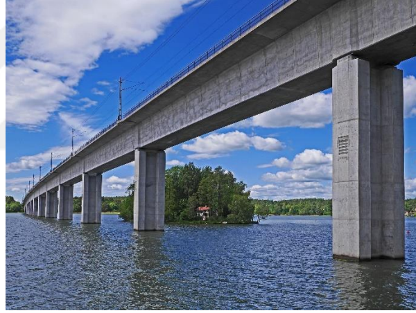
Şekil 2.2: Betonarme Köprü Uygulaması
