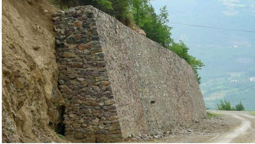
Şekil 2.11: İstinat Duvarı Örneği ( https://www.sanalsantiye.com/test-dayanma-yapilarina-ne-kadar-hakimiz/ )
